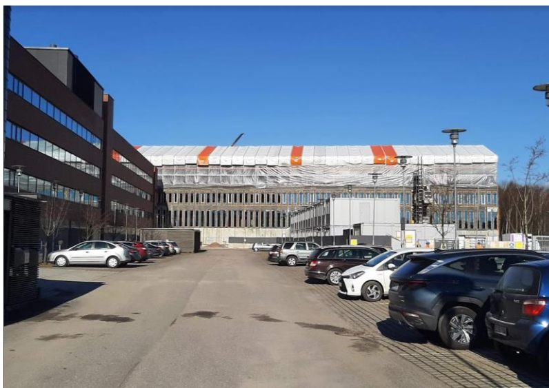
Kuva: Laajennusosan rakentaminen käynnissä. Kuvattu 28.4.2021.
