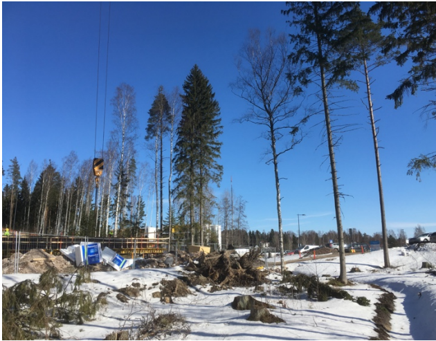
Kuva 4-9. Liikkumisyhteys Paapuurin päiväkodilta pohjoiseen on heikentynyt ja on muutamien puun varassa.
