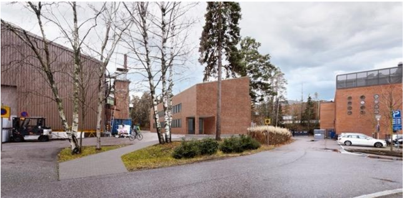
Uudisrakennuksen sisäänkäynti suuntautuu Geologintien ja Geologinpuistoon päin. Kuva Tietoa Oy.
