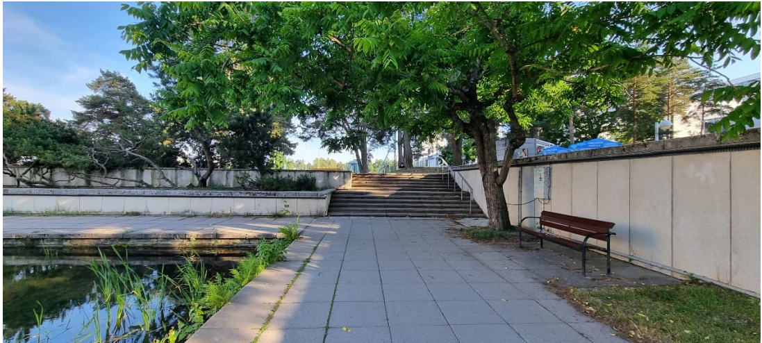
Kuva 12. Keskusaltaan ja Aarne Ervin aukion väliin, portaiden yhteyteen sijoitetaan esteetön yhteys Keskusaltaalle, jolloin Aarne Ervin aukioon rajautuva tukimuuri uusitaan. Uuden rakenteen johdosta nykyiset lehtipuut joudutaan poistamaan.
