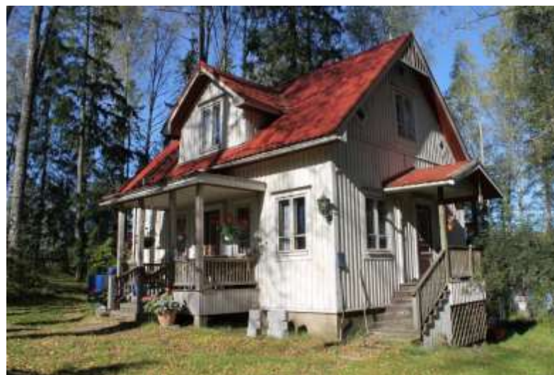
Lomarakennuksen Kolmperäntien puoleinen julkisivu.
