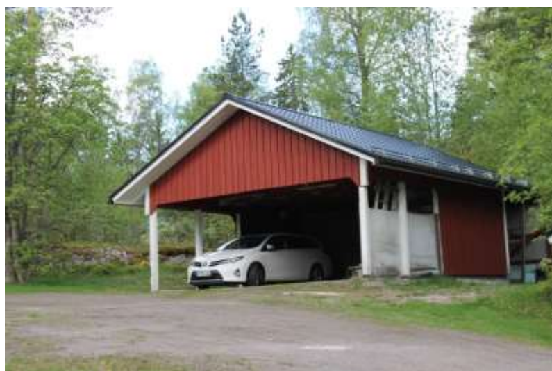
Autokatos ja varastorakennus.
