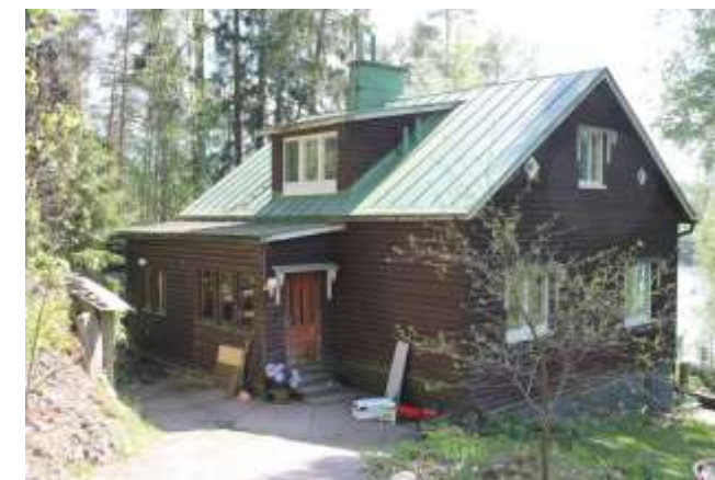
Asuinrakennuksen etupihan puoleinen julkisivu.
