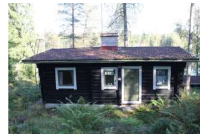
Lomarakennuksen Kolmperäntien puoleinen julkisivu.
