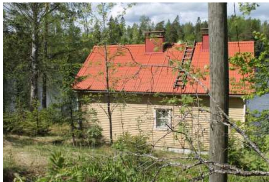
Lomarakennuksen Kolmperäntien puoleinen julkisivu.
