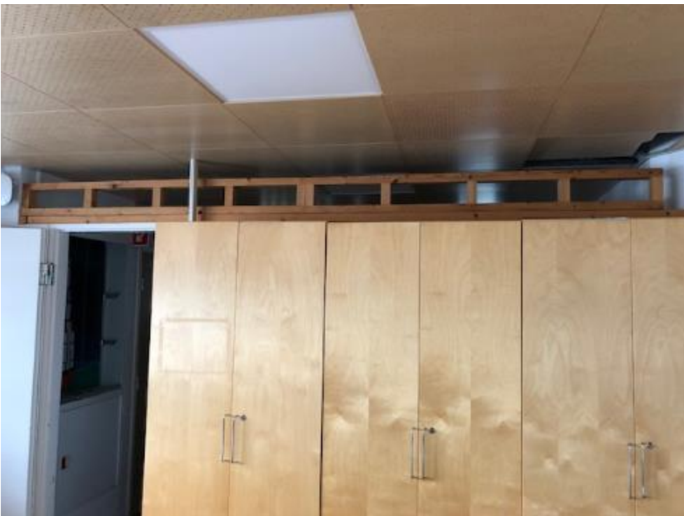
Kuva 4.7. Luokan 303 ja käytävän välinen väliseinärakenne kuvattuna luokasta päin.
