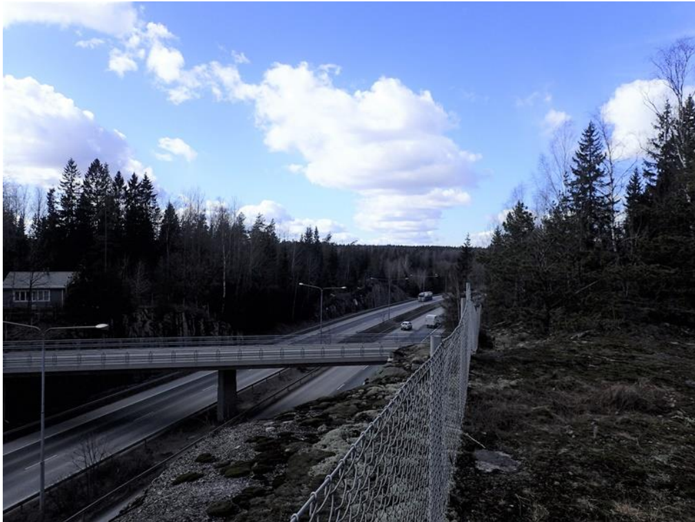
Kuva 2 Turunväylä rajaa selvitysalueetta etelässä. Kuvassa näkyy Nupurinkallionsilta.
