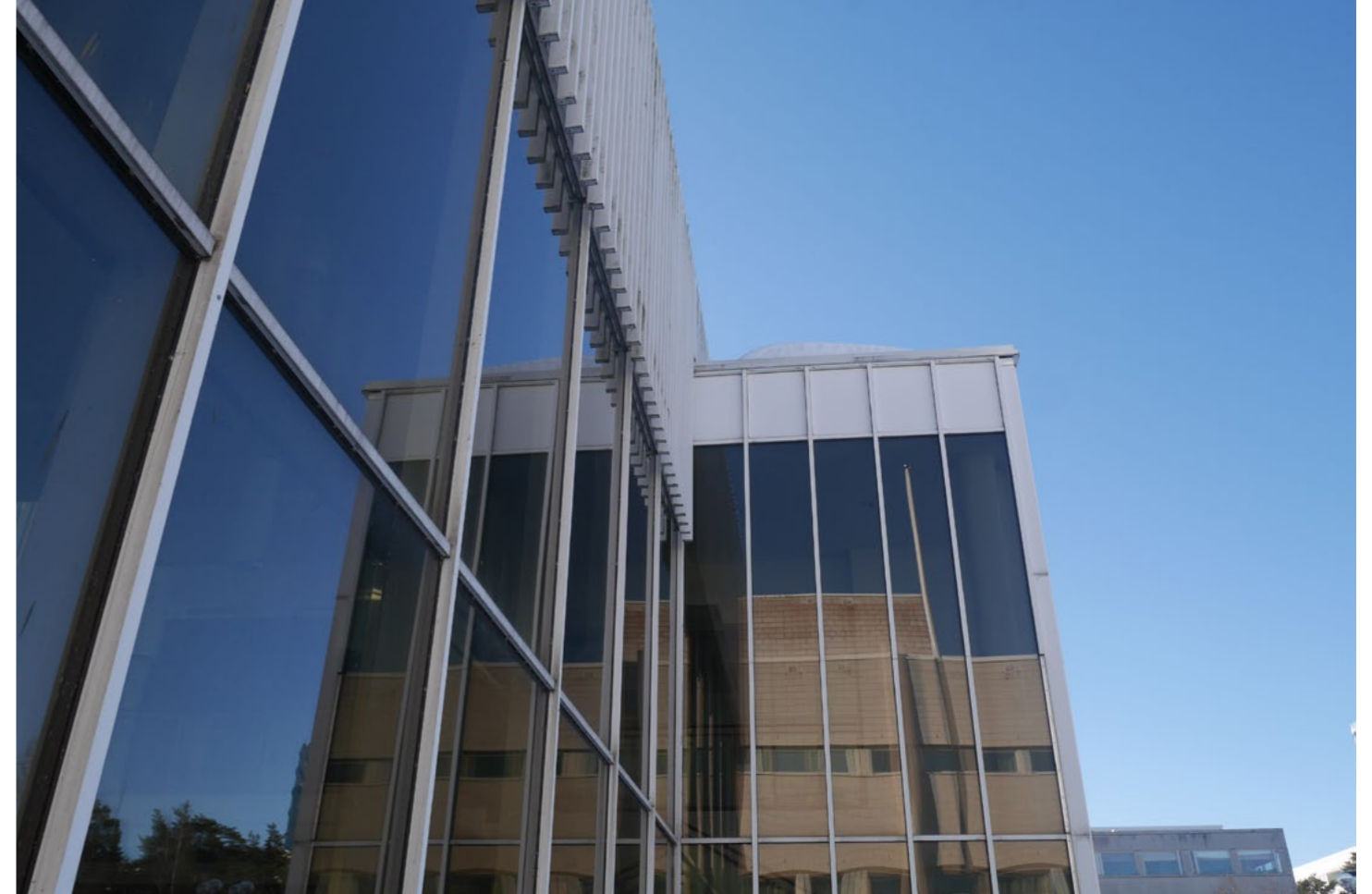
Lasijulkisivujen yläosassa on käytetty valkoiseksi maalatuista alumiiniprofileista rakennettua, varjostavaa ritiläihettä.
