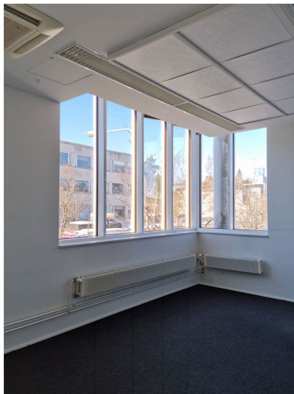
Luoteiskulman toimistohuoneessa on korkea kulmaikkuna, joka muodostaa kontrastin muiden työhuoneiden matalan nauhaikkunan leimaamalle julkisivulle.
