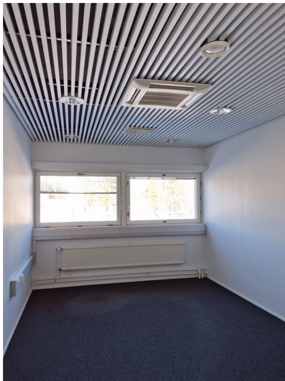
Alakattoja on uusittu ja muutettu tilamuutosten yhteydessä, muutamissa toimistotiloissa on vielä säilynyt Lautexin mallista edustava kevytmetallisälealakatto.
