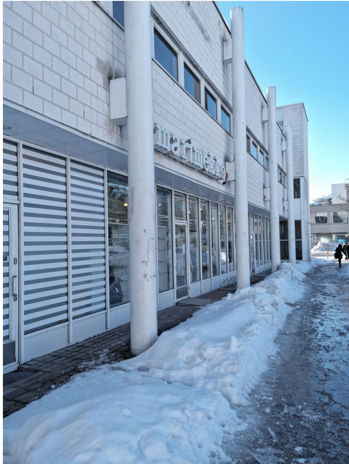
Julkisivua hallitsevat teräskuoreen valetut betonipilarit ja palkit, näyteikkunoiden yläpuolella on kvartsihiekkaharkoista muurattu julkisivu.
