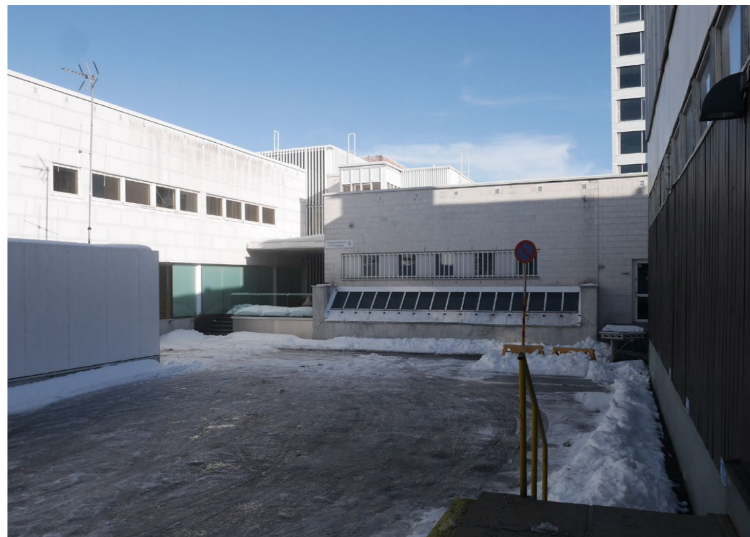
Huoltopiha, oikealla vanhan Tapiontorin myymäläkeskuksen sulkeutunut, huoltotoimintoja palveleva pohjoinen julkisivu.
