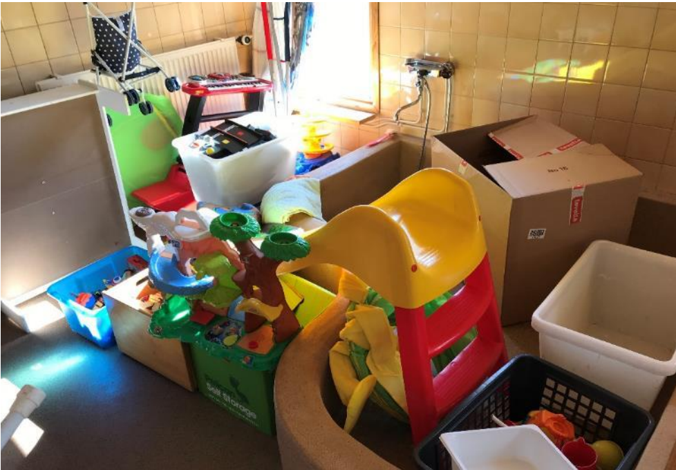
Kuva 5.9. Tavaroita on varastoitu lattiakaivon päälle.
