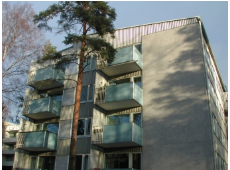
Vasemmalla Aalto-asbestikuitulevyä ja alumiinilevyä Pohjankonnun julkisivussa. Ruokakameroiden vanhat tuuletusputket modernina ornamenttina. Oikealla parvekkeissa siniseksi maalattua sileää asbestisementtilevyä ja sileänä seinäpintana harmaata pestyä terastirappausta. 2004.
