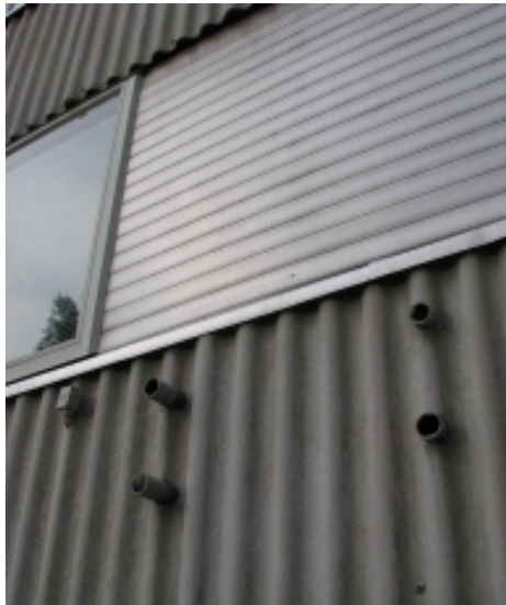
Vasemmalla Aalto-asbestikuitulevyä ja alumiinilevyä Pohjankonnun julkisivussa. Ruokakameroiden vanhat tuuletusputket modernina ornamenttina. Oikealla parvekkeissa siniseksi maalattua sileää asbestisementtilevyä ja sileänä seinäpintana harmaata pestyä terastirappausta. 2004.
