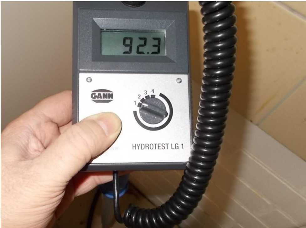
Kuva 4.12. Kosteusmittaus alakerran keittiötilan lattiasta.
