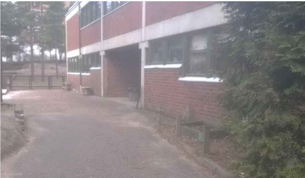
Kuva 4.2. Rakennuksessa on valesokkelirakenne ja tiiliverhous lähtee lähes maanpinnan tasolta.
