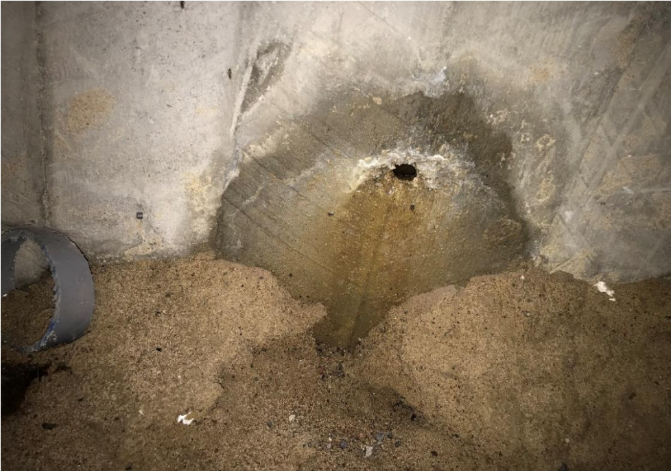
Kuva 4.23. Vesivuoto alapohjassa.
