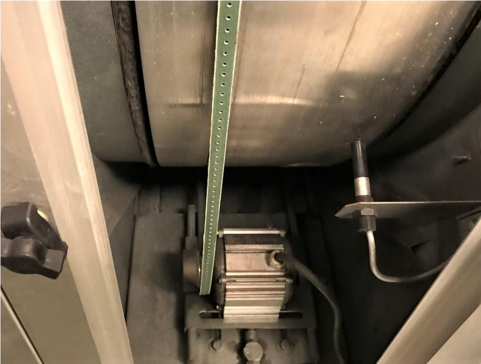
Kuva 6.2. LTO-kiekon hihna löysällä (kiristetty).
