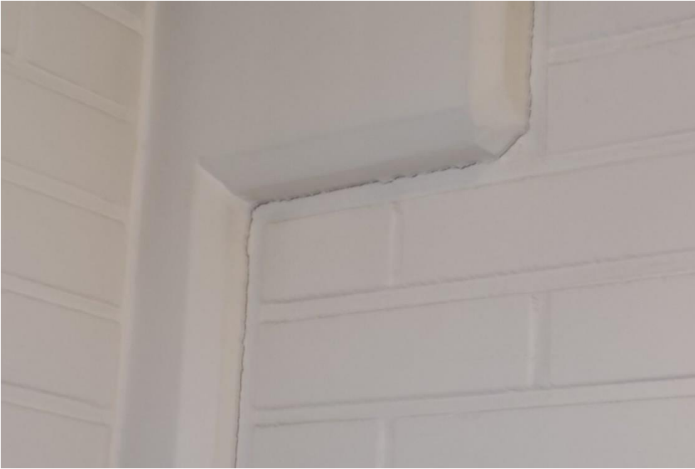
Kuva 4.5. Rakenneliitos.
