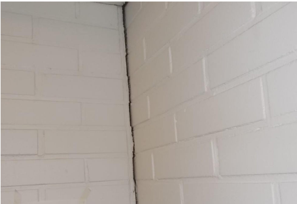
Kuva 4.14. Keittiötilan nurkka alakerrassa.
