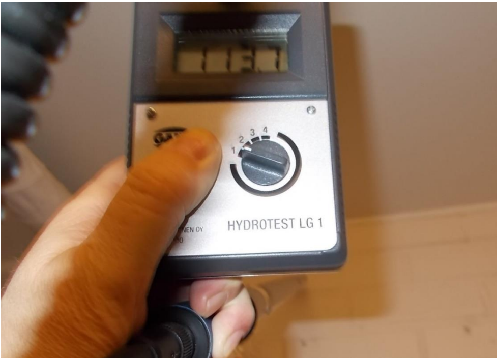
Kuva 4.13. Kosteusmittaus alakerran keittiötilan seinästä.
