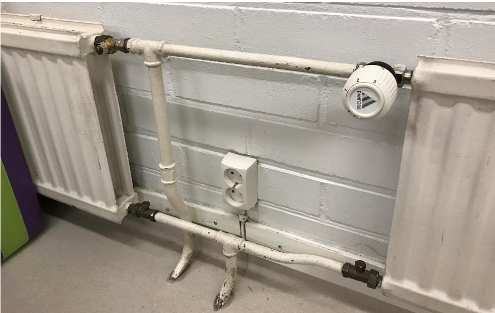
Kuva 5.7. Patteritermostaatteja puuttuu.
