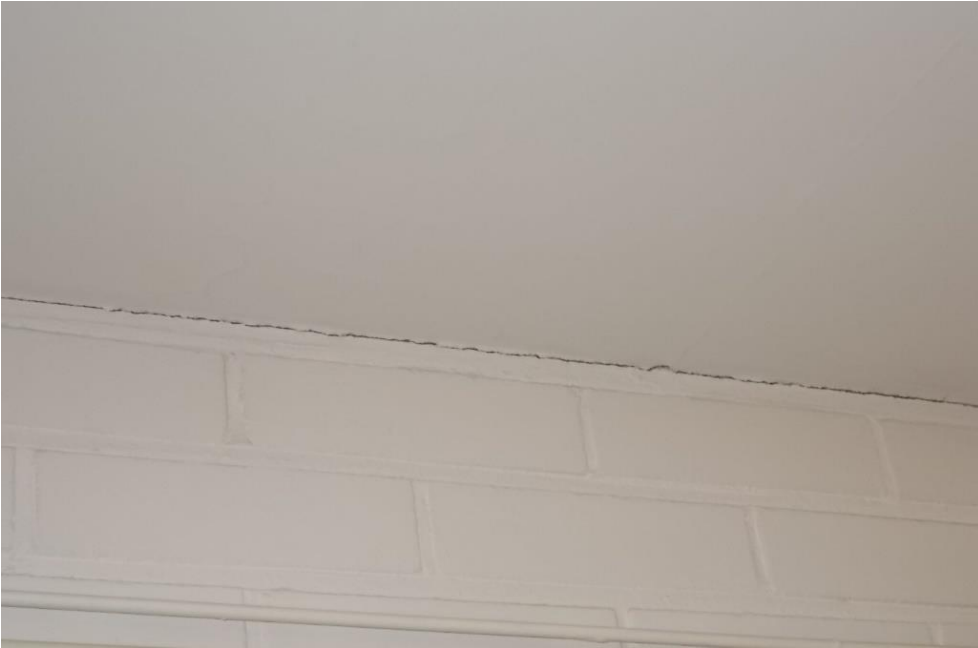
Kuva 4.19. Seinän ja katon välinen rakenneliitos.
