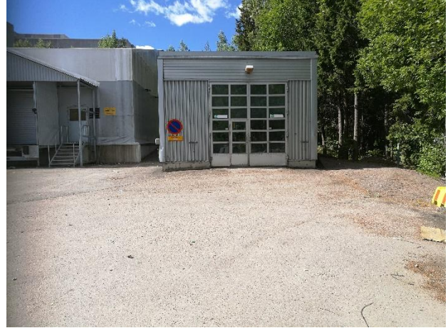
Valokuva 2. Autojen huoltorakennus, jonka edustalla tutkimuspiste VAH303. Oikealla kuvassa metsän rajassa pohjavesiputki PVP1.
