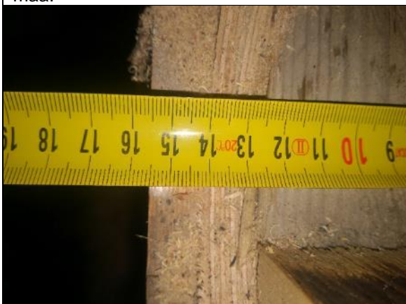
Kuva 128 RAK12. Rima, vaneri ja ulompi alaohjauspuu.
