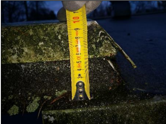
Kuva 220 Räystään korkeus on n. 100 mm kattopin- nasta.
