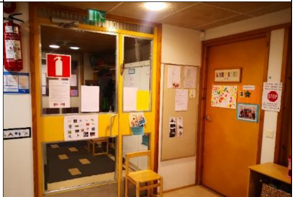
Kuva 97 Teräsrakenteinen ulko-ovi on maalattu sisäpuolelta keltaiseksi.
