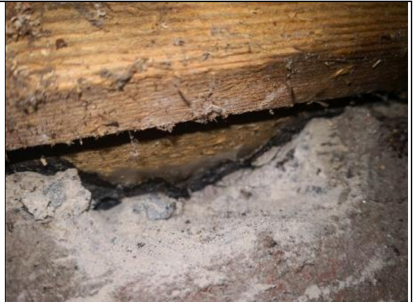
Kuva 89 Sokkelin ja ulkoseinän alaohjauspuun välissä on bitumikermikaistale ja rakennusmuovi.
