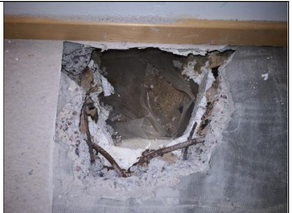
Kuva 58 RAK17. Alapohjan rakennetta.
