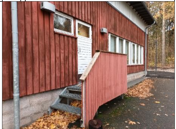
Kuva 291 Rakennuksen Koillis-seinustalla on Kodinhoitohuoneen 40 (tuleva Pienryhmä 136) sisäänkäynnin teräsrakenteiset portaat, joissa on puurakenteinen kaide.
