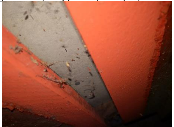
Kuva 133 RAK13. Lomalaudoituksen takana on tuulensuojalevy.
