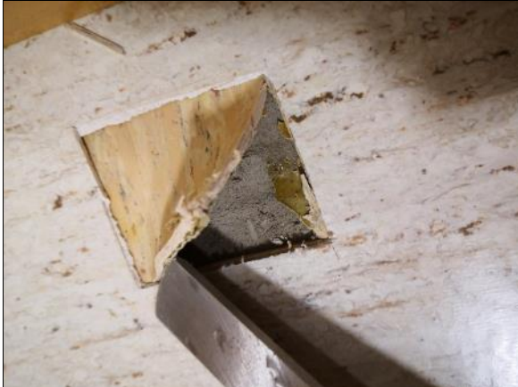
Kuva 29 Uudempiä muovimattoja on asennettu vanhojen mattojen päälle.
