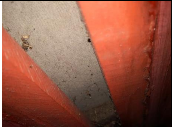
Kuva 139 RAK14. Lomalaudoituksen takana on tuulen- suojalevy.
