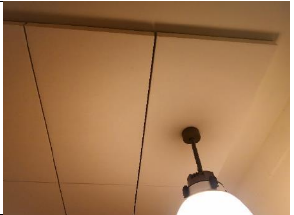
Kuva 236 Lähivuosina uusittuja akustiikkalevyjä päiväkodin tiloissa 15, 20 ja 04 (tulevat tilat 108, 109, 103 ja 104).
