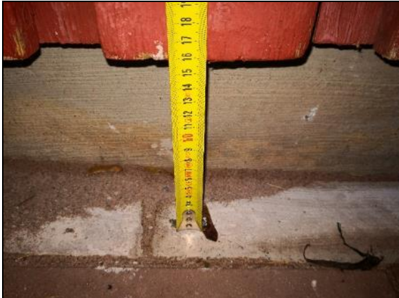
Kuva 88 Sokkelin korkeus on matalimmassa kohdassa vain n. 160 mm.
