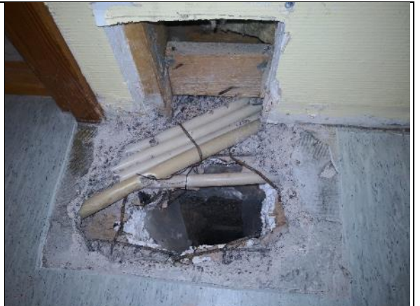
Kuva 66 RAK19. Alapohjan rakennetta.
