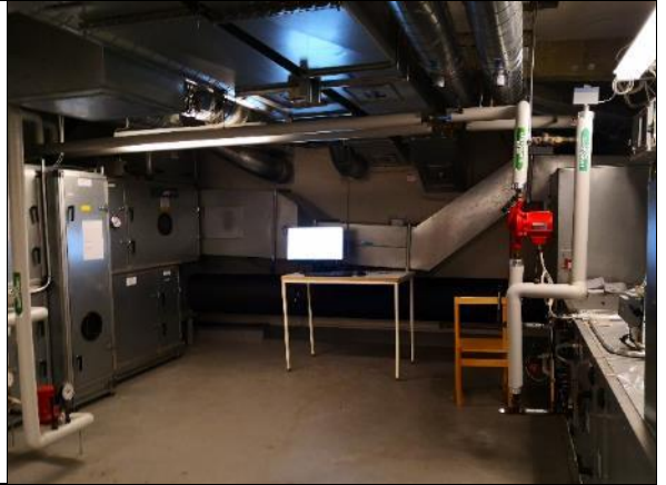
Kuva 149 Toisessa kerroksessa sijaitseva IV-konehuone. Lattiapinnoina on muovimatto.
