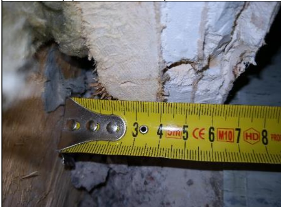
Kuva 187 RAK5. Kaksinkertainen kipsilevy ja vaakarunkopuu.
