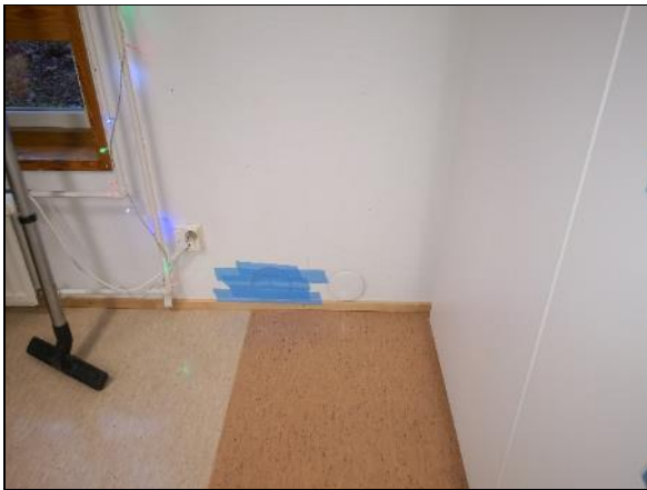
Kuva 130 RAK13. Rakenneavauksen sijainti.
