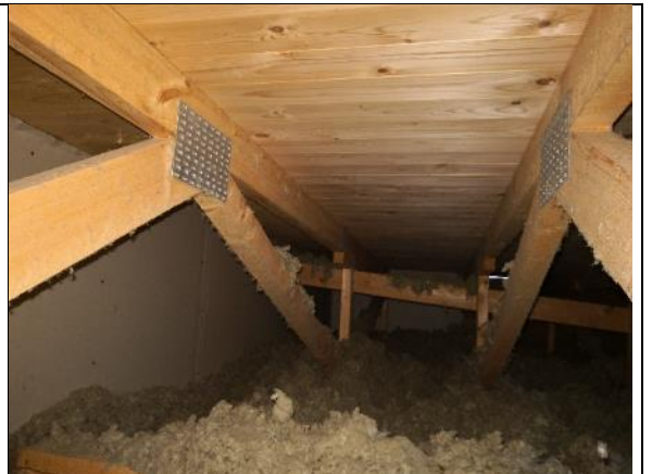
Kuva 267 Puurakenteet ovat hyväkuntoisia.
