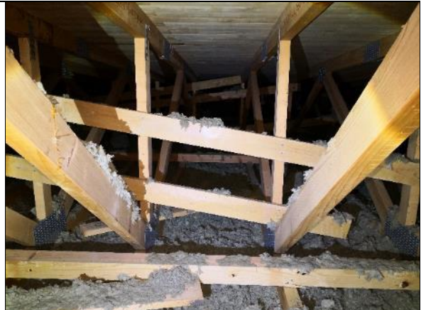
Kuva 259 Puurakenteet ovat hyväkuntoisia.
