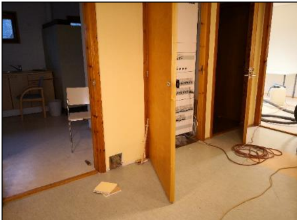
Kuva 185 RAK5. Rakenneavaus tehtiin Tilaan 51 (odotushuone) (tuleva Aula 150).
