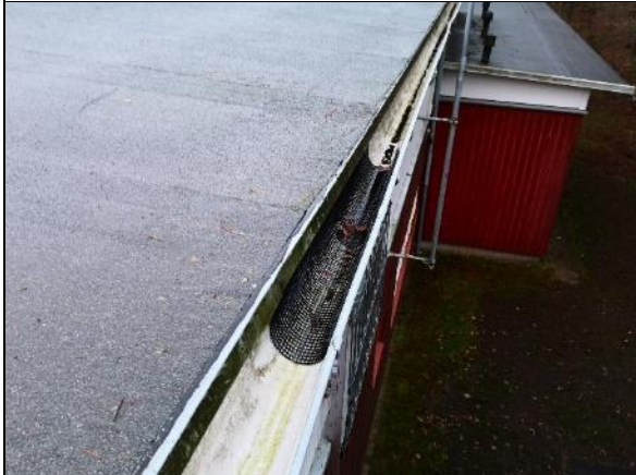
Kuva 224 Luoteis-seinustalla on räystäskourut.
