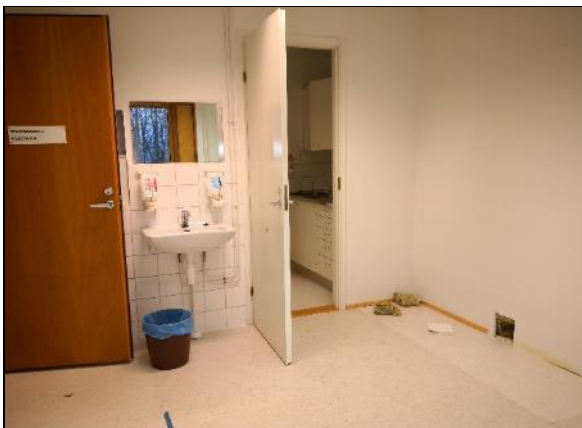
Kuva 199 RAK7. Rakenneavaus tehtiin tilaan Lääkäri 53 (tuleva Ryhmähuone 151)
