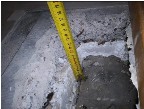
Kuva 63 RAK18. Betonin, paperin, EPS-eristeen ja muovin alla on leca-harkko.
