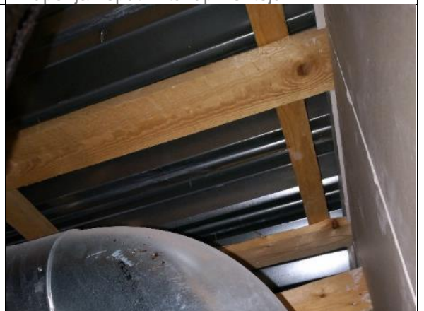
Kuva 255 Vesikaton puurakenteita ja liittolevyt.
