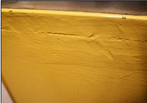
Kuva 100 Teräsovien pinnat ovat epätasaisia ja moneen kertaan maalattuja.
