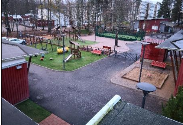
Kuva 13 Piha-alue on uusittu äskettäin.
