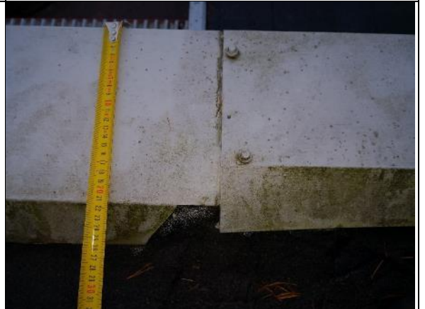
Kuva 223 Kahden eri levyisen räystäspellin liitoskohta.
