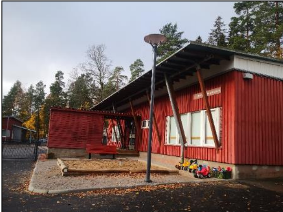
Kuva 226 Pilareiden kannattelema räystäsrakenne.
