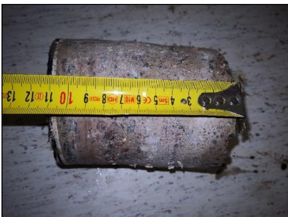
Kuva 47 RAK10. Alapohjan rakennetta.
