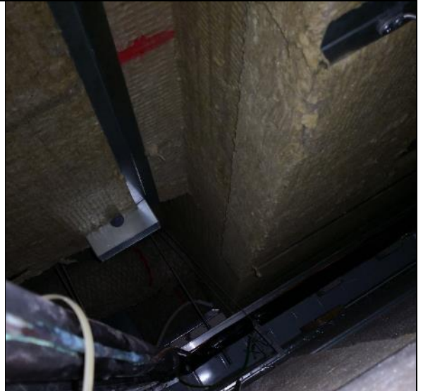
Kuva 231 Keittiön 28 (tuleva Keittiö 129) alueella on yläpohjan alapinnassa mineraalivillaa.
