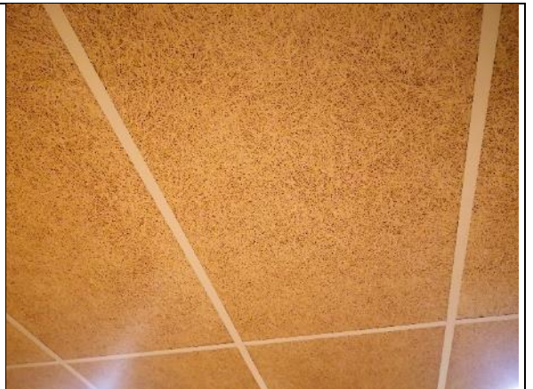
Kuva 238 Päiväkodin Hallissa 14 (tuleva Eteinen 107) on tojalevyistä tehty alas laskettu katto.
