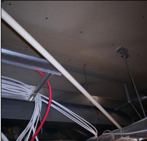
Kuva 230 Käytävän 21 (tuleva Käytävä 121) yläpohjan kipsilevypinnoitteista alapintaa.
