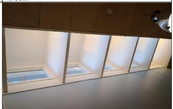
Kuva 93 Monitoimihallin 07 (tuleva Monitoimihalli 114) ikkunat on uusittu.
