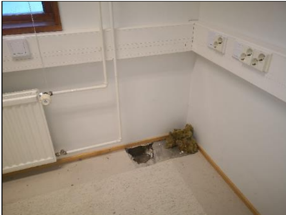
Kuva 57 RAK17. Rakenneavauksen sijainti.
