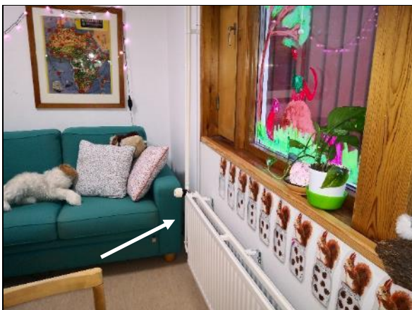
Kuva 140 RAK15. Rakenneavauksen sijainti (sohvan päädyn kohdalla).
