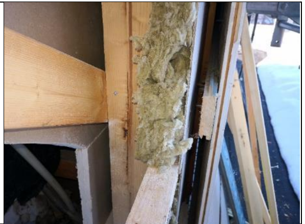
Kuva 249 Monitoimihallin ullakon ulkoseinän rakenne.
