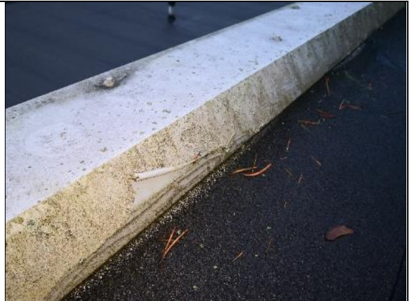
Kuva 221 Räystäspelttien maali irtoilee.
