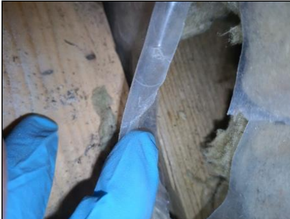
Kuva 138 RAK14. Rakennusmuovin takana oleva ulompi alaohjauspuu.
