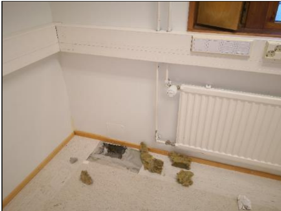
Kuva 61 RAK18. Rakenneavauksen sijainti.
