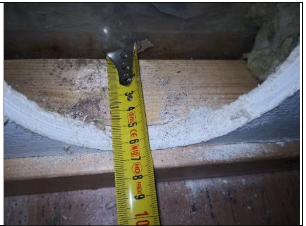
Kuva 131 RAK13. Kipsilevy ja sisempi alaohjauspuu.
