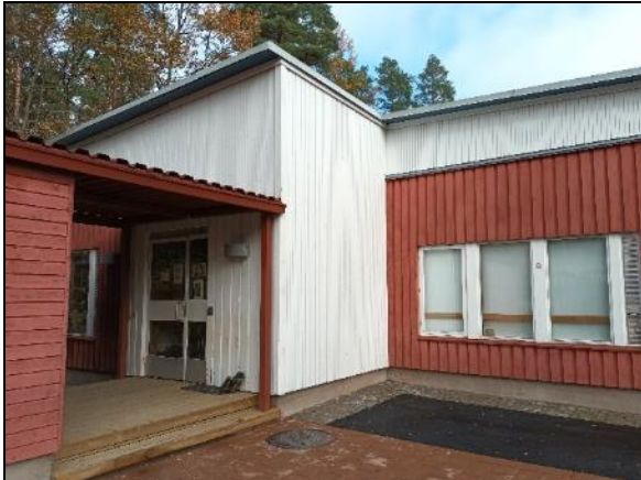
Kuva 292 Puurakenteinen porrastasanne Mesimarjojen sisäänkäynnin edustalla.
