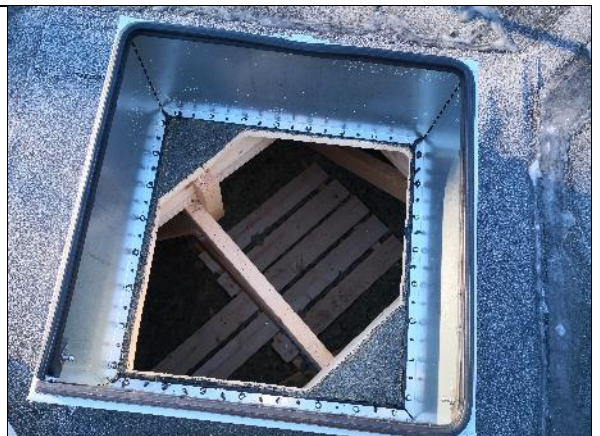
Kuva 263 Osastohuoneen 36 kohdalla oleva tarkastusluukku.
