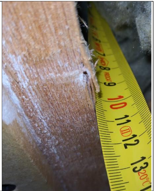
Kuva 174 RAK1. Pystyrunkopuu ja mineraalivillaa.
