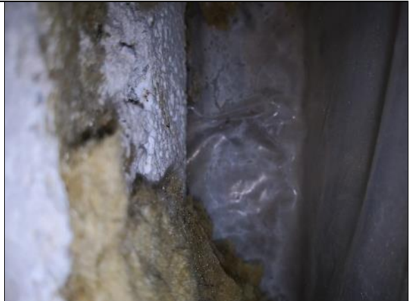
Kuva 46 RAK4. Alapohjan rakennetta. Teräsbetoni-laatta ja ESP-eristettä.
