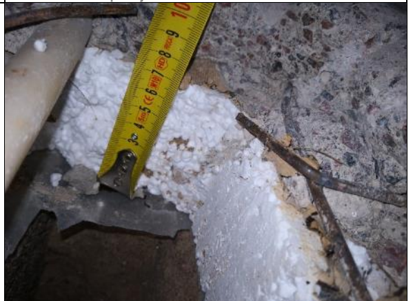
Kuva 68 RAK19. Betonin alla on paperi ja ESP-eriste.
