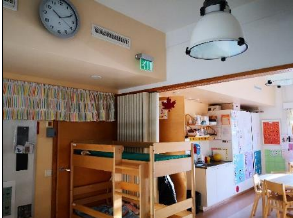
Kuva 278 Tulevassa Ryhmähuone 108:ssa (aiemmin Tila 15) on koko tilan sivun mittainen koteloraakenne.
