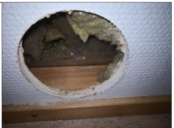
Kuva 141 RAK15. Kipsilevy ja sisempi alaohjauspuu.
