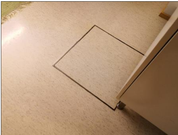
Kuva 41 Taukotila 123:ssa sijaitseva tarkastusluukku.
