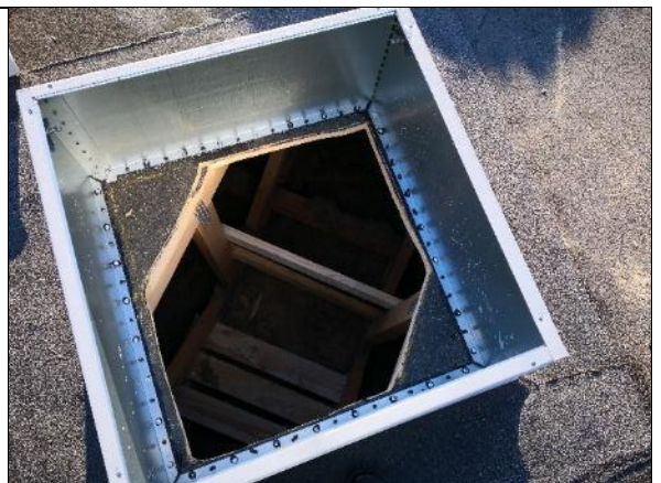
Kuva 257 Tilan 15 kohdalla oleva tarkastusluukku.
