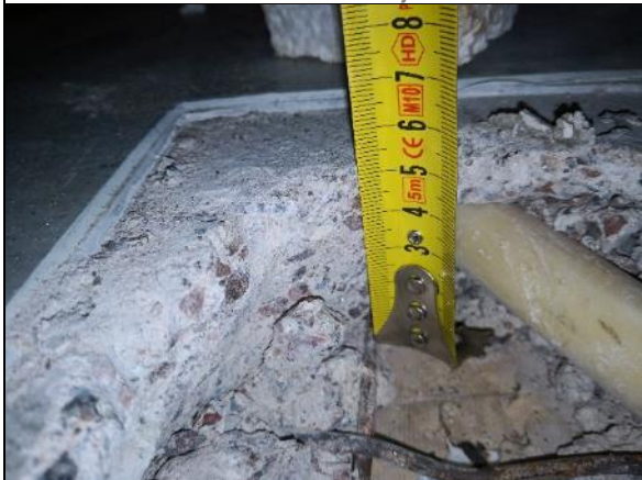
Kuva 67 RAK19. Betonin alla on paperi ja ESP-eriste.
