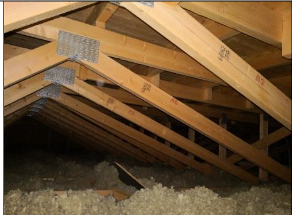
Kuva 265 Puurakenteet ovat hyväkuntoisia.
