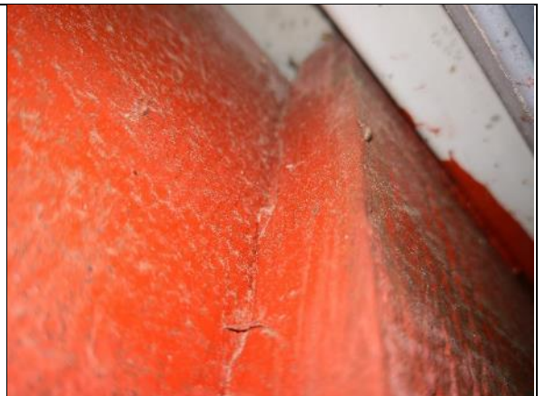
Kuva 75 Laudoitettujen seinäosuuksien yläosassa on pelti. Rakenne ei tuuletu tehokkaasti tätä kautta.
