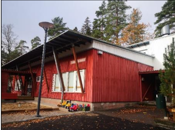
Kuva 72 Ulkoseinät ovat lauta- ja paneeliverhottuja.
