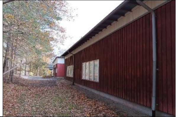
Kuva 14 Luoteis-seinustalla piha on selvästi muuta piha- aluetta kosteampi.
