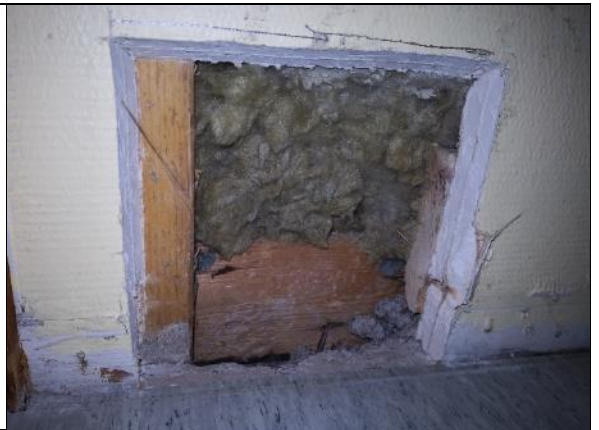
Kuva 186 RAK5. Kipsilevyt, vaakarunkopuu ja mineraalivillaa.
