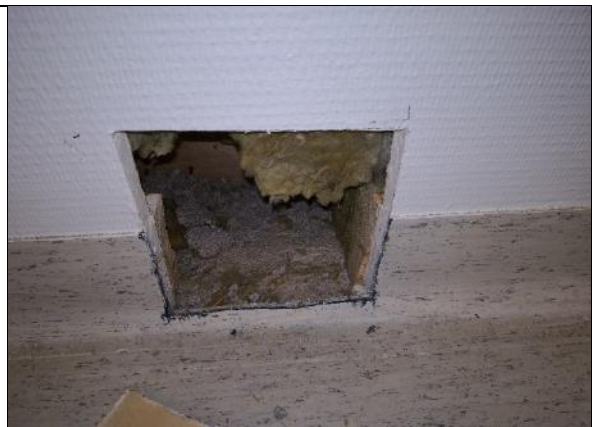
Kuva 194 RAK6. Rakenneseinä tehtiin Hammaslääkärin tilaan 63 (tuleva Ryhmähuone 153).
