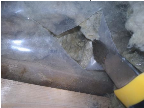
Kuva 132 RAK13. Rakennusmuovi ja sen takana oleva ulompi mineraalivilla ja alaohjauspuu.
