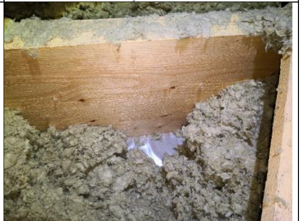
Kuva 261 Höyrynsulkumuovi puhallusvillan alla.
