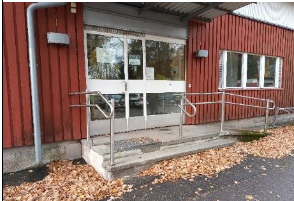
Kuva 96 Teräsrakenteinen ulko-ovi on maalattu ulko-puolelta valkoiseksi.
