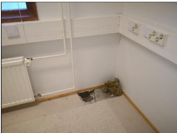
Kuva 144 RAK20. Rakenneavauksen sijainti.
