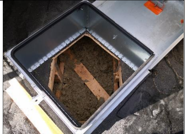
Kuva 271 Hammashoitolan ullakon tarkastusluukku.
