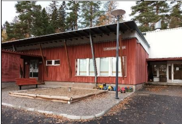
Kuva 3 Yleiskuva päiväkotiosan julkisivusta.
