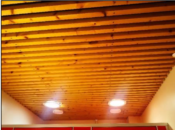
Kuva 239 WC-tiloissa ja pesuhuoneissa on puurimasta tehty alaslasku.
