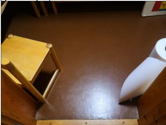
Kuva 31 Varastoissa ja WC-tiloissa on alkuperäistä muovimattoa.
