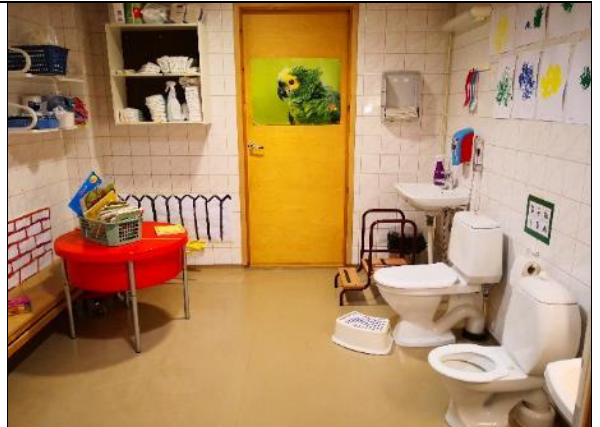
Kuva 159 Päiväkodin pesuhuoneissa on keraamista laattaa.
