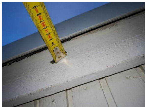
Kuva 219 Kermi on tuotu räystäspellin alla asianmukaisesti räystäään ulkoreunan yli. Ullakkotila tuuletuu laudan alla olevan tuuletusraon kautta.
