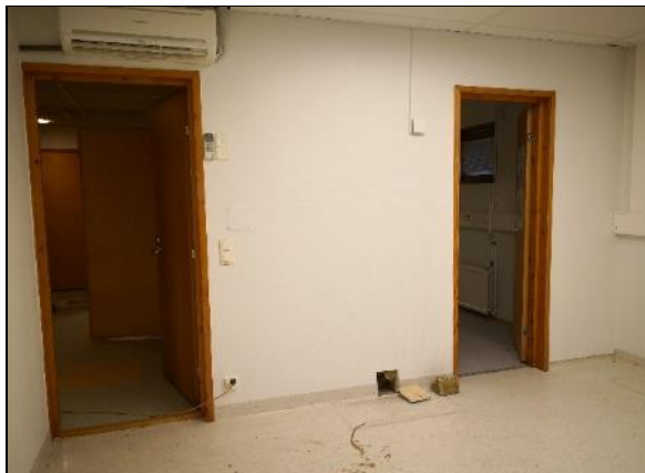
Kuva 193 RAK6. Rakenneseinä tehtiin Hammaslääkärin tilaan 63 (tuleva Ryhmähuone 153).
