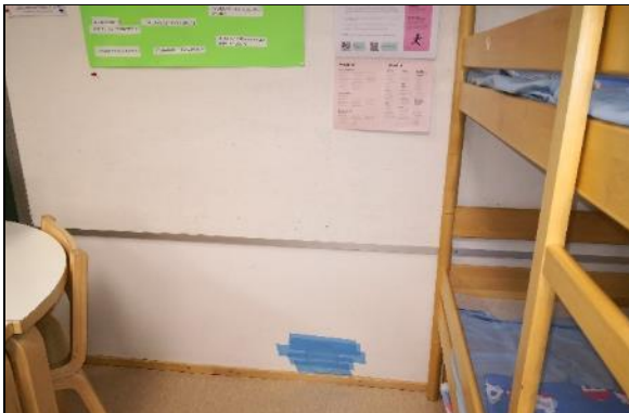
Kuva 134 RAK14. Rakenneavauksen sijainti.
