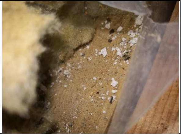
Kuva 143 RAK15. Rakennusmuovin takana oleva ulompi alaohjauspuu.
