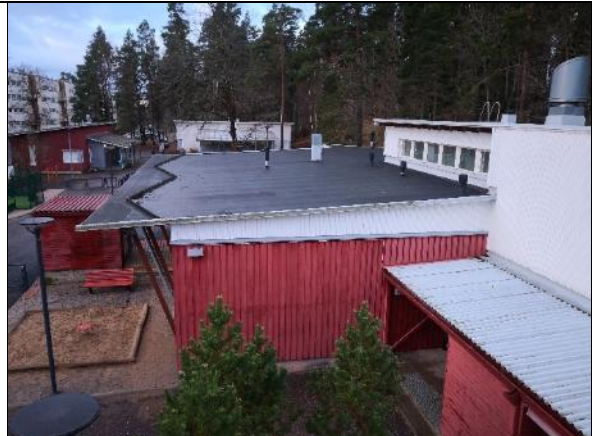
Kuva 227 Vedenohjausharjanteet sijaitsevat räystäään alueella.
