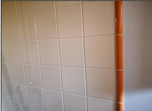
Kuva 160 Kerhotilan pesuhuoneessa 46 (tuleva Käytävä 158/Lepuhuone 152) on keraamista laattaa.
