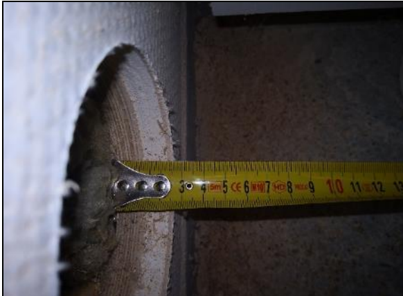
Kuva 197 RAK6. Väliseinän toisella puolella on vanerin lisäksi kipsilevy.
