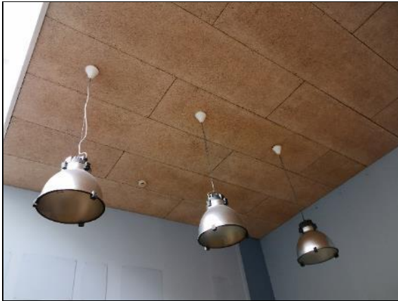
Kuva 235 Vanhoja akustiikkalevyjä Monitoimihallissa 101 (tuleva Monitoimihalli 114) yläpohjan alapinnassa.
