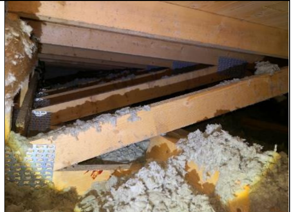
Kuva 273 Puurakenteet ovat hyvässä kunnossa.
