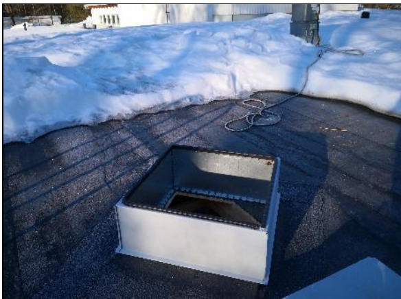
Kuva 262 Osastohuoneen 36 kohdalla oleva tarkastusluukku.
