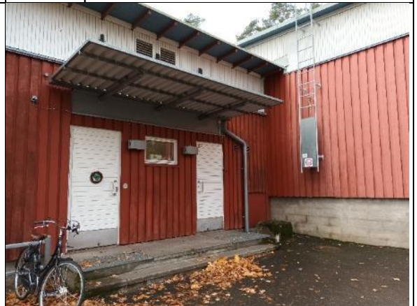
Kuva 289 Kerhon ja lämmönjakohuoneen 70 (tuleva 157) portaat Koillis-seinustalla.
