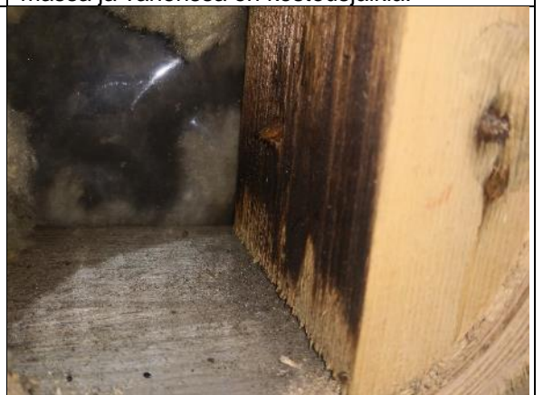
Kuva 127 RAK12. Pystyrunkokopuun alaosassa on tummentumaa.
