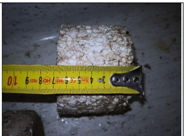
Kuva 48 RAK10. Alapohjan lämmöneristeenä on EPS-eriste. Kuvassa alempi eristelevy.
