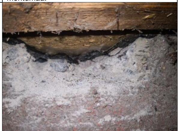
Kuva 129 RAK12. Alaohjauspuun alapuolella on rakennusmuovi sekä bitumikermi.
