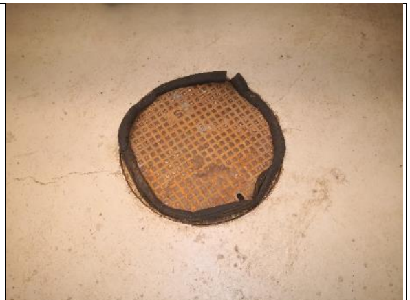
Kuva 42 Lämmönjakohuoneessa 157 sijaitseva kaivon kansi.
