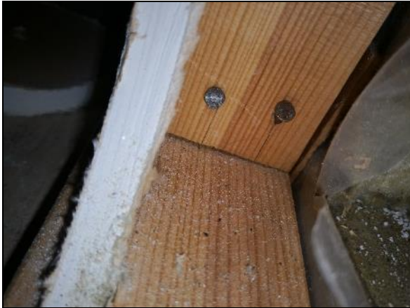
Kuva 142 RAK15. Sisempi alaohjauspuu ja pystyrunkopuu.
