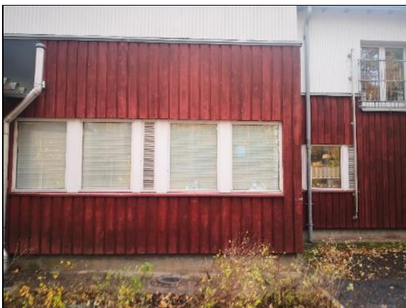
Kuva 90 Ikkunat ovat alkuperäisiä puuikkunoita.
