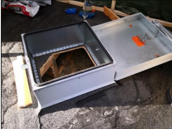
Kuva 270 Hammashoitolan ullakon tarkastusluukku.
