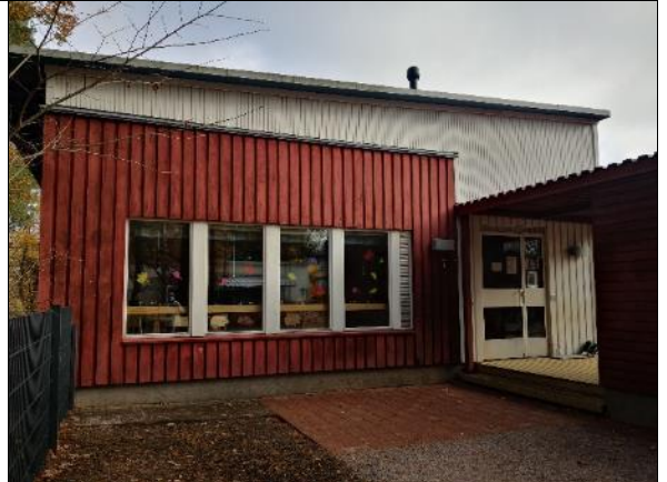
Kuva 73 Ulkoseinät ovat lauta- ja paneeliverhottuja.
