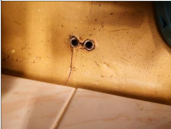
Kuva 37 Tiivistämättömiä läpivientejä.
