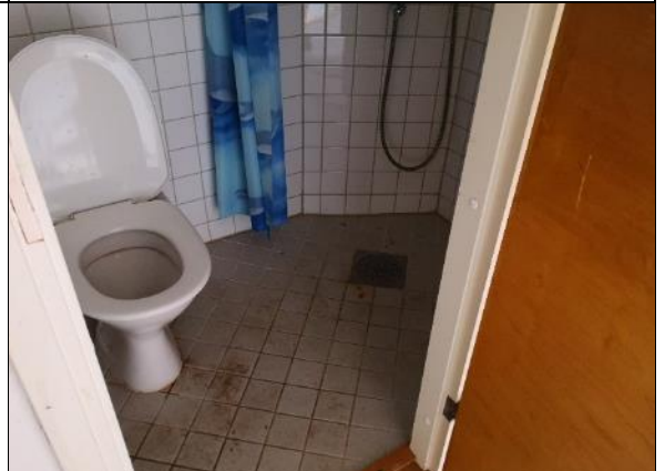
Kuva 161 Hammashoitolan pesuhuoneessa 60 on keraamista laattaa seinäpinnoitteena.
