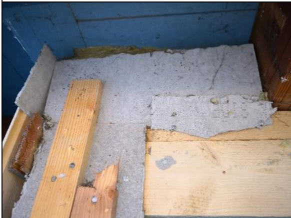
Kuva 250 Ullakon ulkoseinän rakennetta tehdyn aukon yläpuolella.
