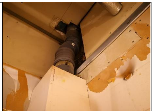
Kuva 241 Keittiön edustalla oleva kotelorakenne ja katon sadevesikaivon viemäri alaslaskun yläpuolella.
