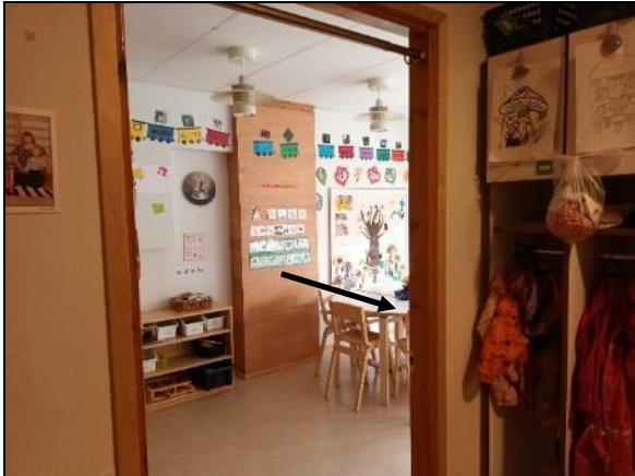
Kuva 45 RAK4. Rakenneavauksen sijainti (kuvassa olevan pöydän takana).
