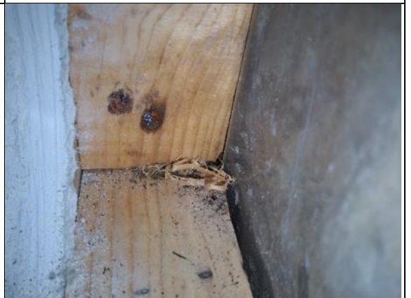
Kuva 137 RAK14. Sisempi alaohjauspuu ja pystysuuntainen runkopuu.
