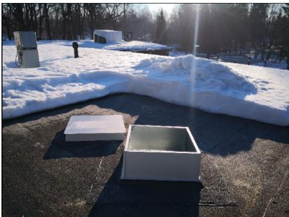
Kuva 256 Tilan 15 kohdalla oleva tarkastusluukku.
