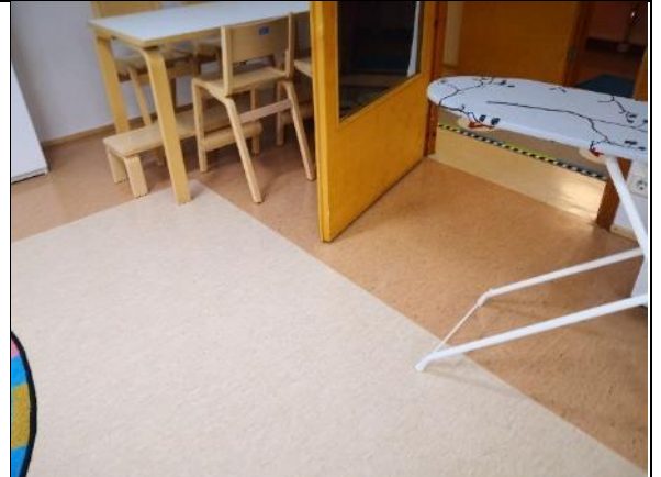
Kuva 30 Uusitut muovimatot ovat melko hyväkuntoisia päiväkodin alueella.
