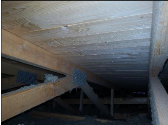
Kuva 272 Puurakenteet ovat hyvässä kunnossa.
