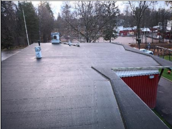
Kuva 212 Vedenpoisto on toteutettu kaadon ja vedenohjausharjanteiden avulla.
