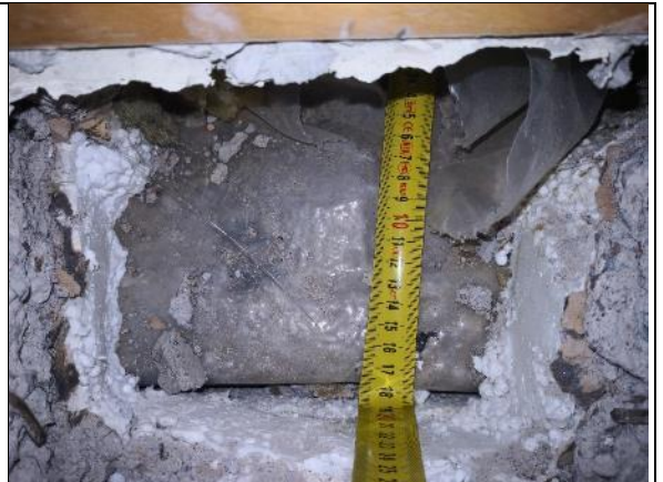
Kuva 62 RAK18. Betonin, paperin, EPS-eristeen ja muovin alla on leca-harkko.
