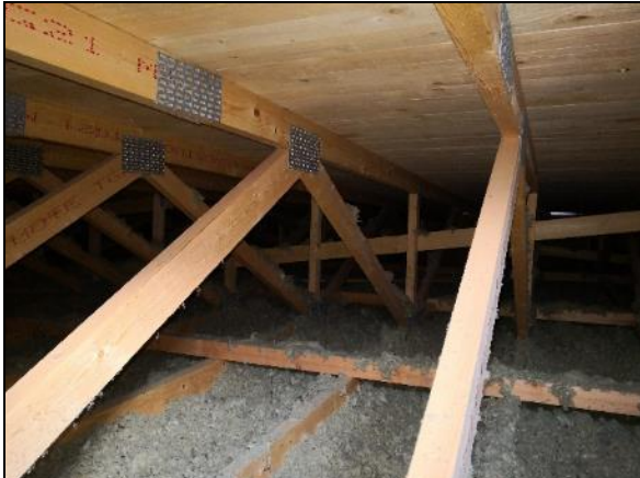
Kuva 258 Puurakenteet ovat hyväkuntoisia.
