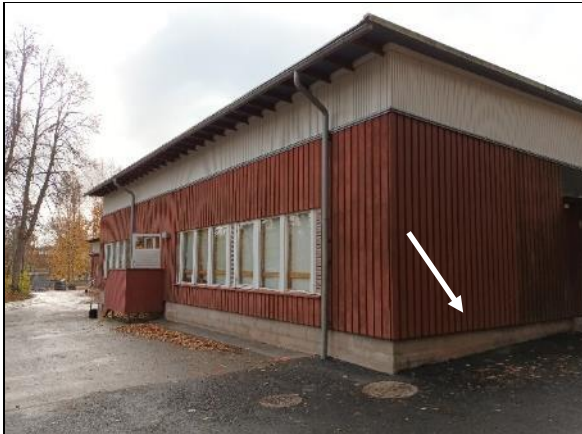
Kuva 124 RAK12. Rakenneavauksen sijainti.
