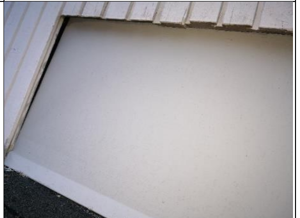
Kuva 213 Ylösnostopellitykset on toteutettu asianmukaisesti.
