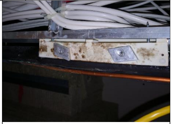
Kuva 247 Muovisen kannakkeen pinnalla on kasvustoa.
