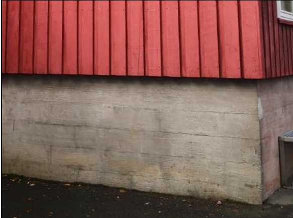
Kuva 78 Sokkelin pinnassa oleva rappaus on halkeillut harkkomuurauksen saumojen kohdalta.
