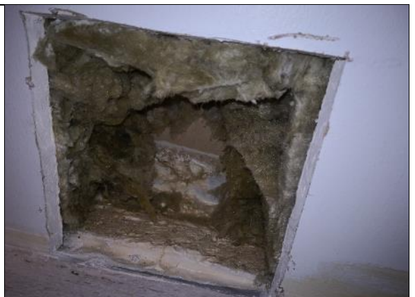
Kuva 200 RAK7. Rakenneavaus tehtiin tilaan Lääkäri 53 (tuleva Ryhmähuone 151)
