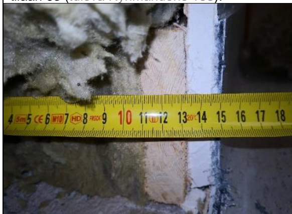
Kuva 195 RAK6. Kipsilevy ja vaakarunkopuu.
