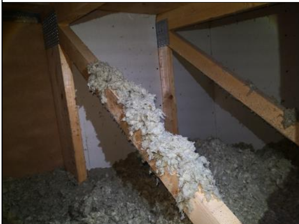
Kuva 268 Ullakon seinärakenne muuttuu erilaiseksi hammashoitolan väliseinän kohdalla. Kyseessä on palo-osaston raja.
