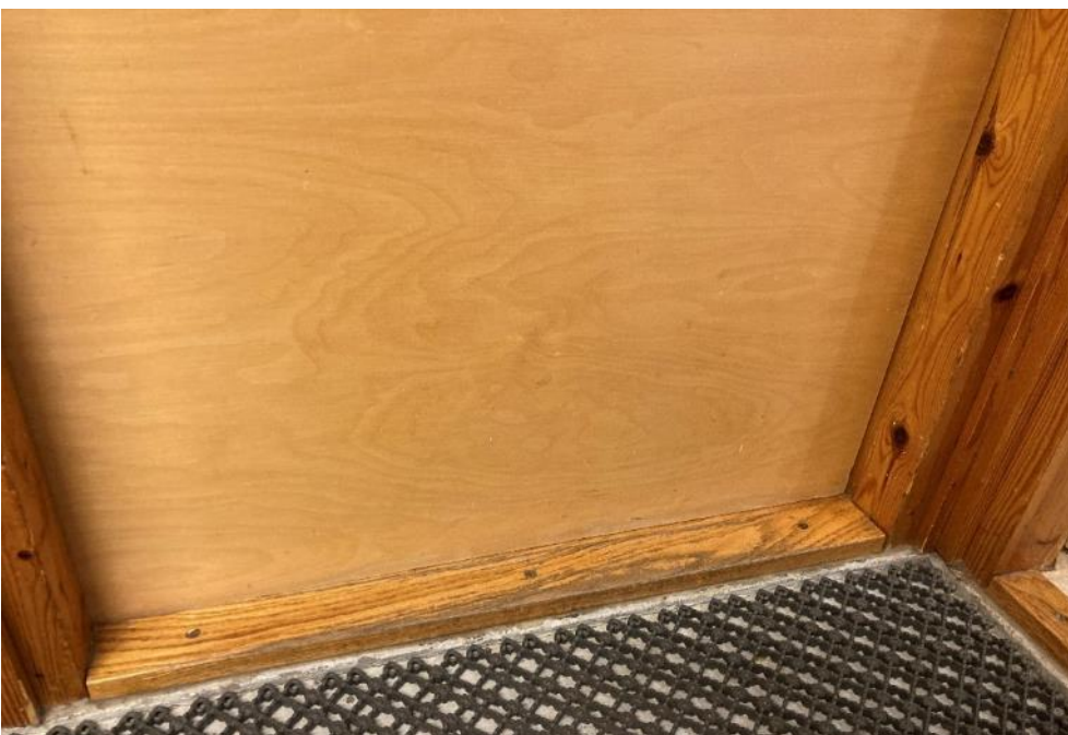
Kuva 5.4. Ovirako puuttuu.
