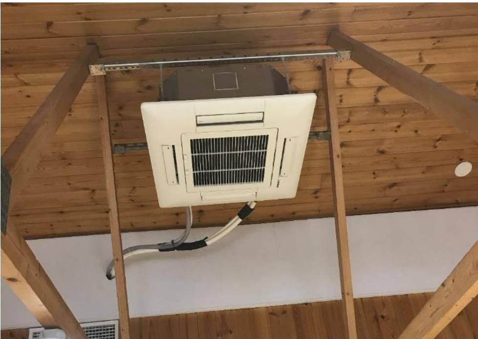
Kuva 5.8. Ilmalämpöpumpun sisäyksikkö.
