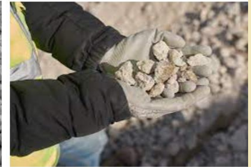
Ruduksen betonimurskeelle vihreää valoa rakennuslehti.fi
