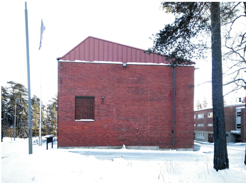
Rakennuksen pohjoispääty ja haalausluukku huoneeseen 201.
