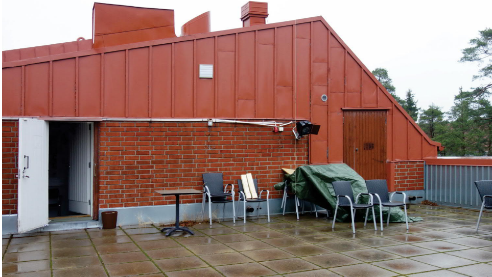
Rakennuksen eteläpäädyn kattoterassi
