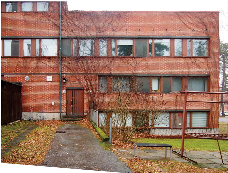
Sisäänkäynti talonmiehen asuntoon sekä eteläpäädyn kattoterassi
