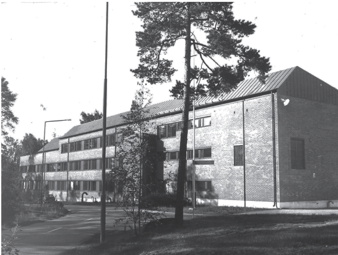
Pääjulkisivu Lämpömiehenkujalle ennen vuotta 1975. Alkuperäisestä ulkoasusta puuttuvat myöhemmin lisätyt pääoven katos sekä IV-konehuoneen laajennus katolla. VTT:n arkisto.
