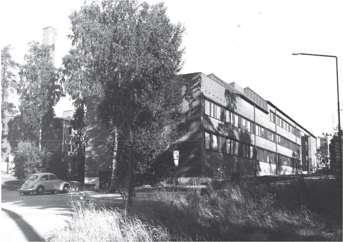
Pääjulkisivu Lämpömiehenkujalle, oletettavasti 1960-luku. VTT:n arkisto.
