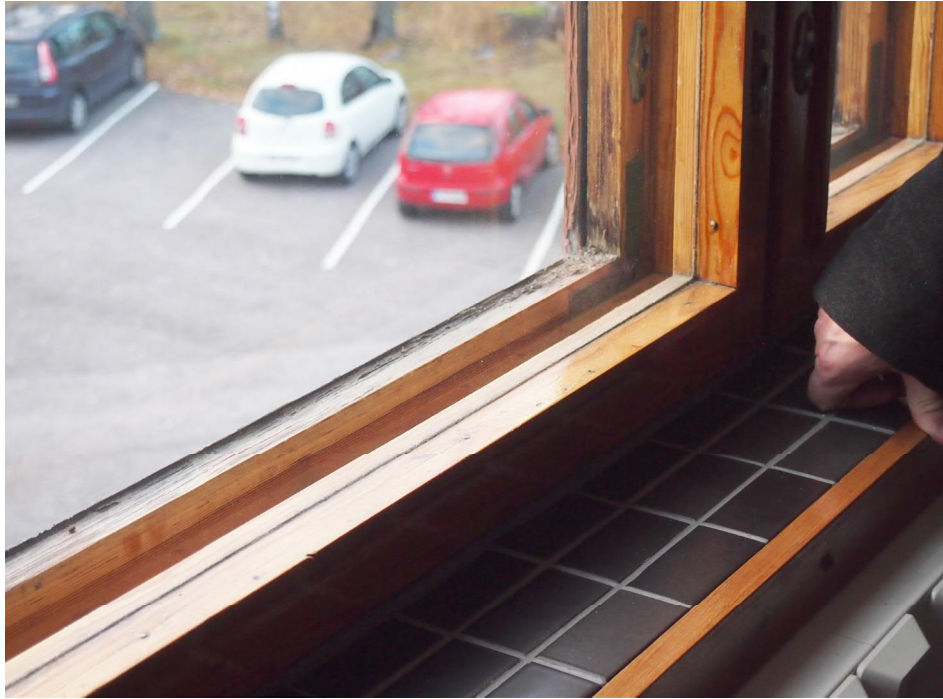
Tyypillinen toimistohuoneen lakkapintainen puuikkuna laattapintaisella ikkunapenkillä.
