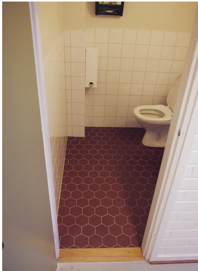
WC:n H303b pinnat ovat säilyneet alkuperäisessä asussaan.
