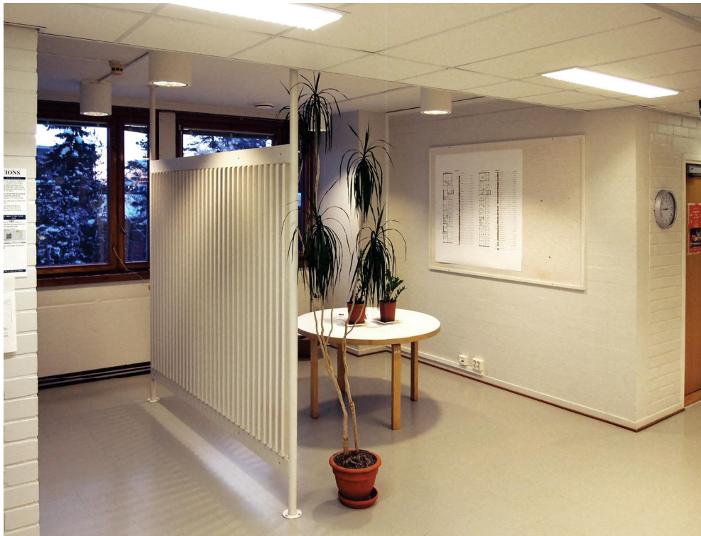
Aulan H304b: Kiinteä sermi on lisätty vuoden 1999 peruskorjauksessa. Kuvassa näkyvä alakatto liittyy käytävään.
