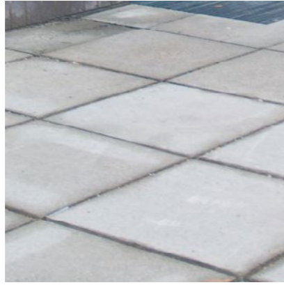
kookkaat betonilaatat, pesty pintakäsittely
