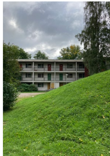
Korttelipihan nurmikumpu on mahdollisesti täyttömaata.
