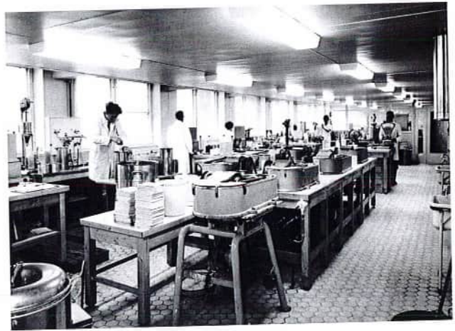
Jauhatus- ja lujuustutkimusosaston hollanterisali. (KCL ka)
