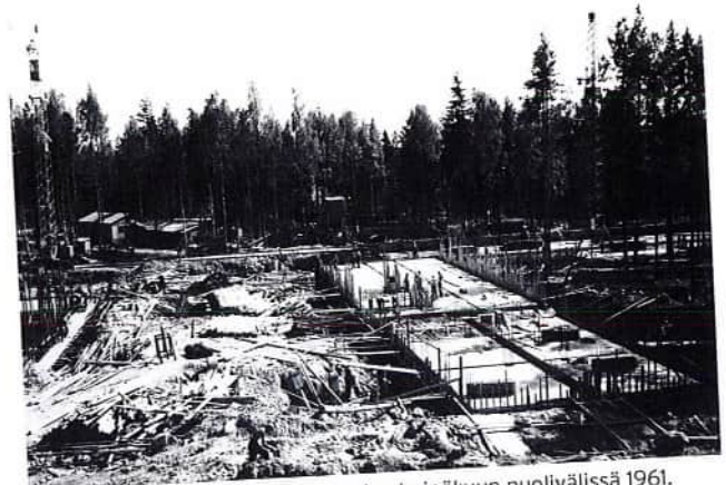
C- ja B-siipien kellariholvit valett uina heinäkuun puolivälissä 1961. (KCL ka)
