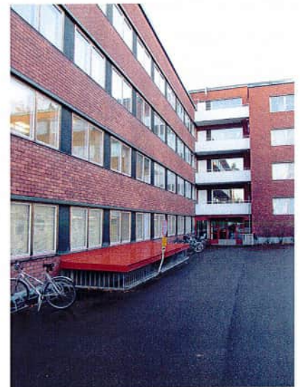
Ilmanvaihdon sisäänottoaukko pihatasolla.
