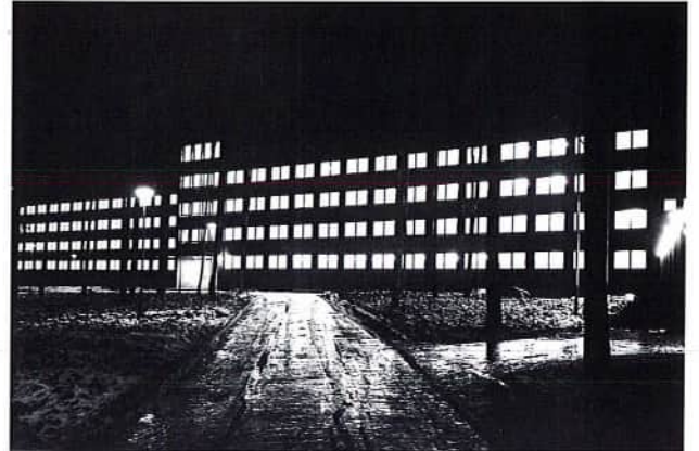
Johdonmukainen julkisivu. (KCL ka)
