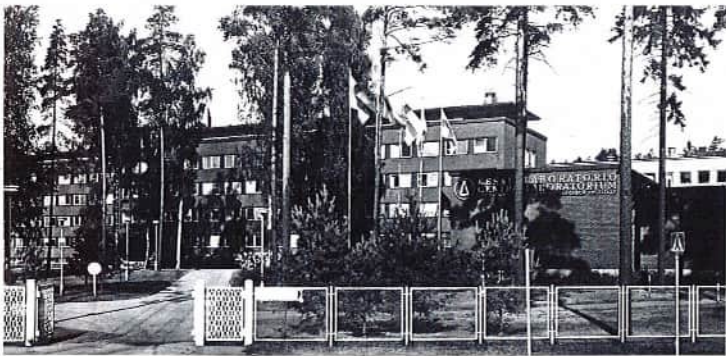
Keskuslaboratorion sisäänkäyntinäkömä 1963. (KCL ka)
