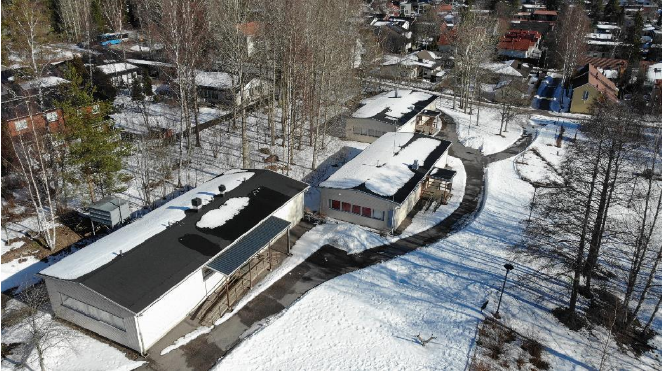
Ilmavalokuva 2 kohteesta 16.3.2023. Kuvassa purkulistalla olevat siirtokelpoiset Parakkikoulut.
