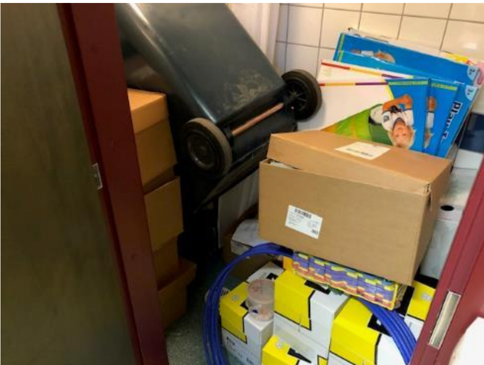
Kuva 5.13. Hopsulan opettajainhuoneen suihkutilassa 107 varastoidaan tavaraa, mikä estää lattiakaivon huollon.
