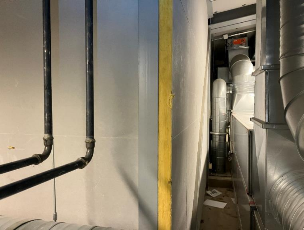
Kuva 4.21. Tilassa 302 on runsaasti avoimia villapintoja.
