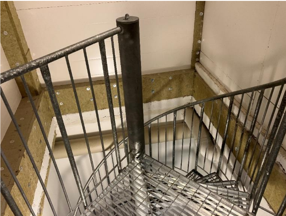
Kuva 4.20. Tilassa PR5 on runsaasti avoimia villapintoja.
