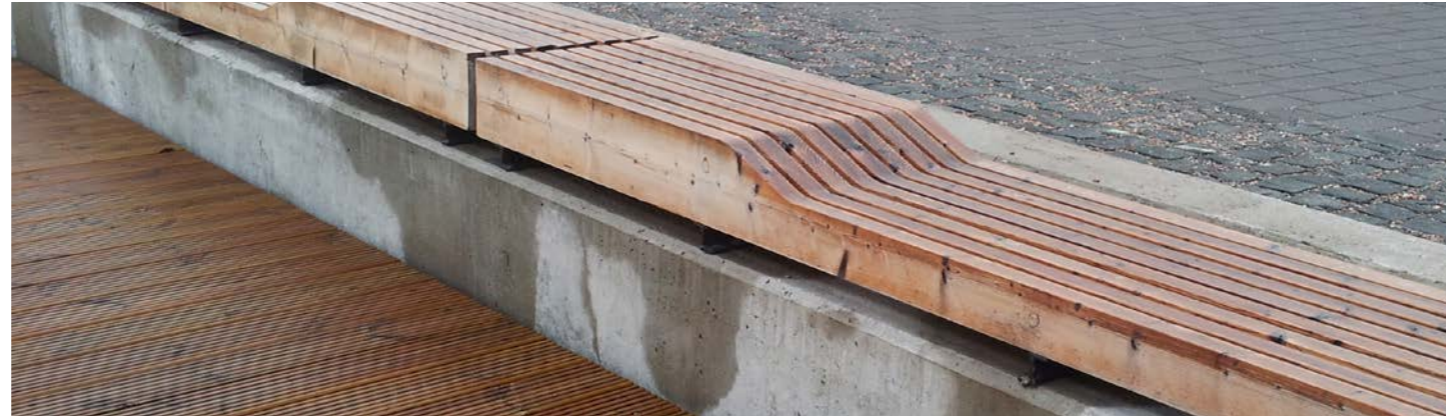
Siltatorin istuskelumuriin integroidaan penkit, jotka voivat olla puupintaisia tai niissä voidaan käyttää alueen tehostevärejä.
