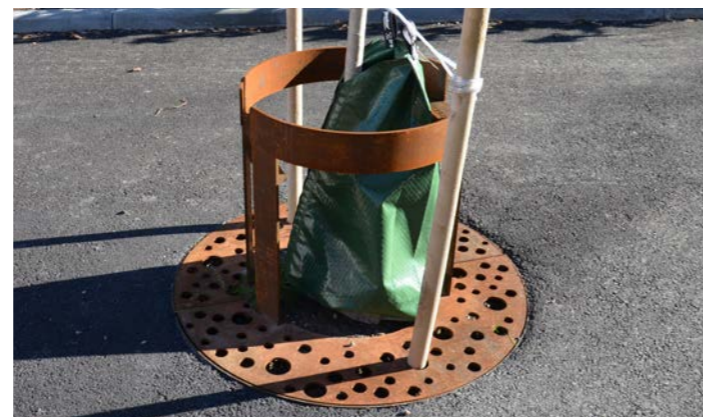
Rungonsuojissa ja maaritiloissa voidaan käyttää Cor-tenia.
