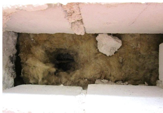
Kuva 14. Ulkoseinän (US4) rakenneavaus (RA9, 20.6) luokassa 143.
