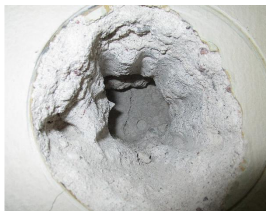
Kuva 15. 2.kerroksen siporex -eristeinen ulkoseinärakenne (US5), luokka 230.
