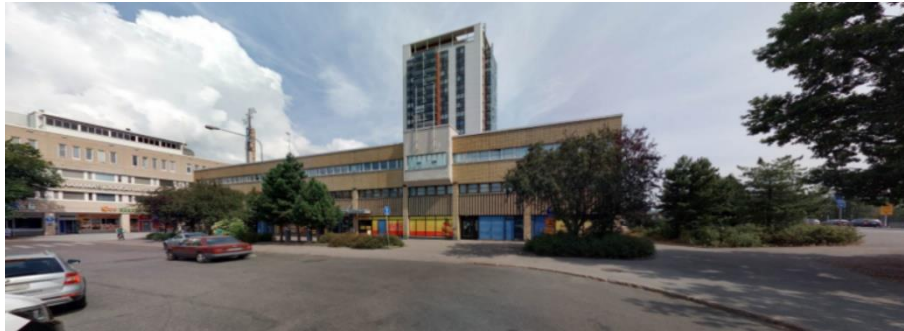
Kuva: Näkymä Lakkisepänkujalta itään päin kohti liikerakennusta. Taustalla as. Oy Espoon Leppävaaran Torni. © Espoon kaupunki.
