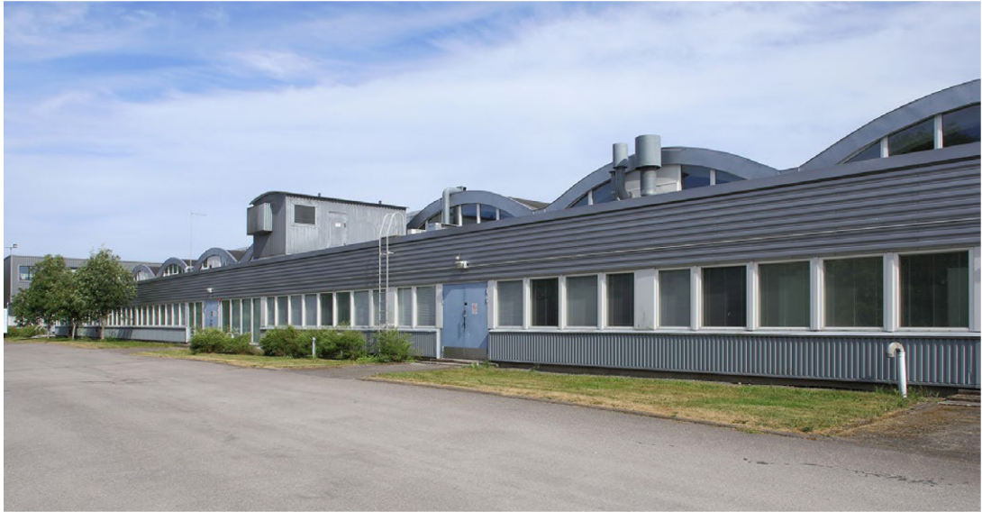
Kuva 17. Kaarihallien luoteeseen aukeava julkisivu vuonna 2018. (Kuvälähde: ark-byroo, 2019)
