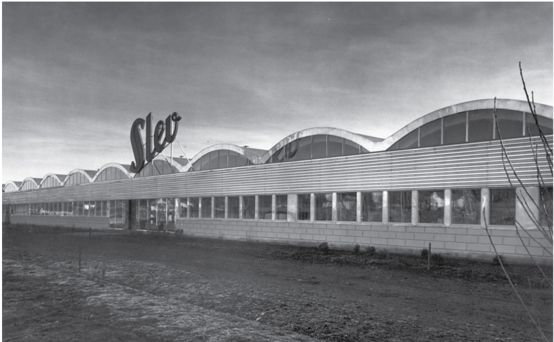
Kuva 16. Kaarihallien luoteeseen aukeava julkisivu vuonna 1958. (Kuva: (Kuvälähde: ark-byroo, 2019; alkuperäinen kuvälähde: Arkkitehtuurimuseo)
