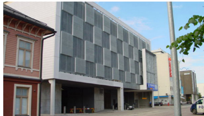
Pysäköintilaitoksen julkisivua voi jaksottaa erilaisilla säleikoilla ja ritilikoilla, jotka joko kulkevat julkisivupinnan mukaisesti tai työntyvät siitä ulos.
