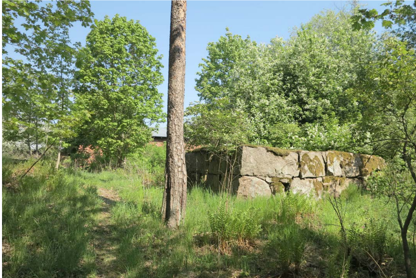
Talousrakennusrivin kaakkoispuolella säilynyt tukimuri.
