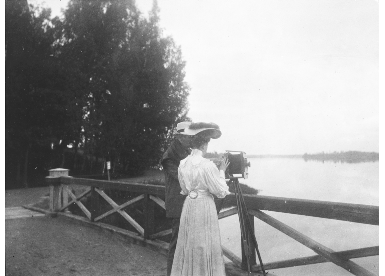
Hanasalmen höyrylaivalaiturilta avautui näkymiä pohjoiseen ja etelään. Laiturilta huvilalle johtava käytävä kiertää niemen rantaa tykkipatterin ulkopuolella. Kuva 1900-luvun vaihteesta. EKM / Åbo Akademin kuva-arkisto, Donnerin kokoelmat
