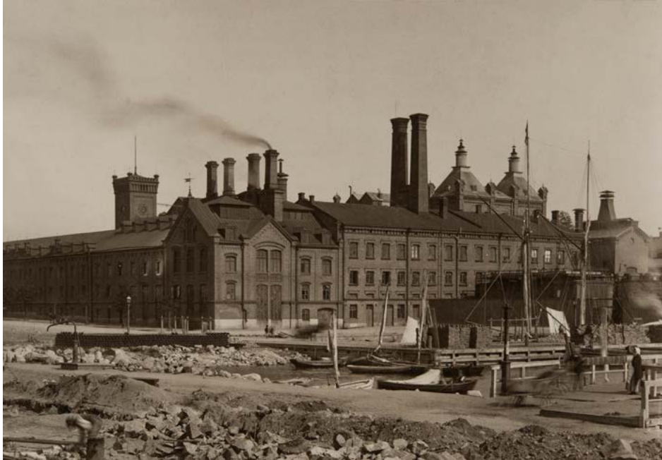
Oy Sinebrychoff Ab panimon rakennukset osoitteessa Bulevardi 38 - 42 (nykyisin 46 - 56) ja Hietalahden eteläinen rantakatu 7. Kuvan oikeassa reunassa laivoja Hietalahden satamassa. Valokuva 1890-luvulta, Helsingin kaupungin museo.
