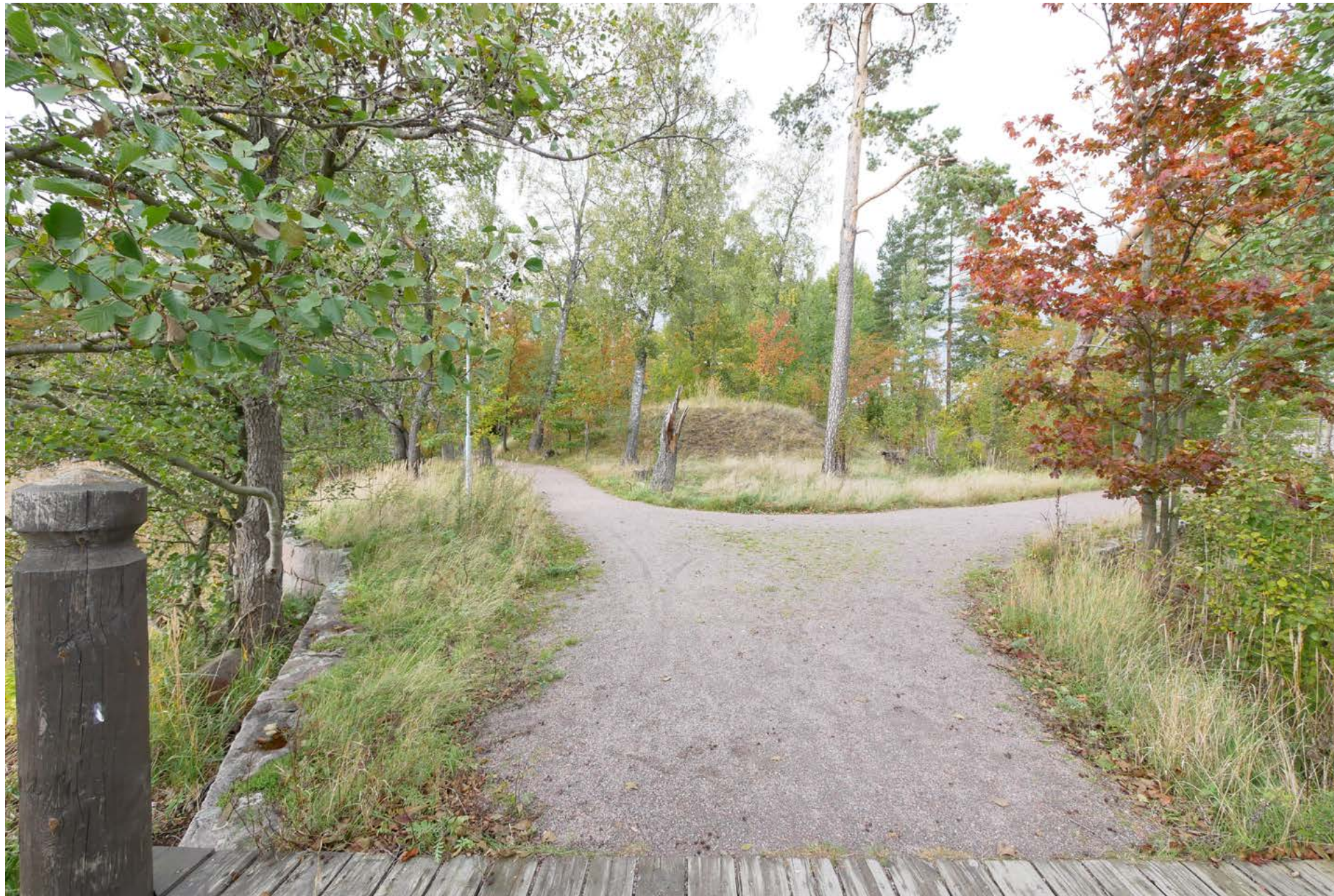
Laiturille johtavan käytävän reunalla on lohkokiviharkoista muurattu pengermuuri. Vasemmalla näkyy muurin kaareva osa.
