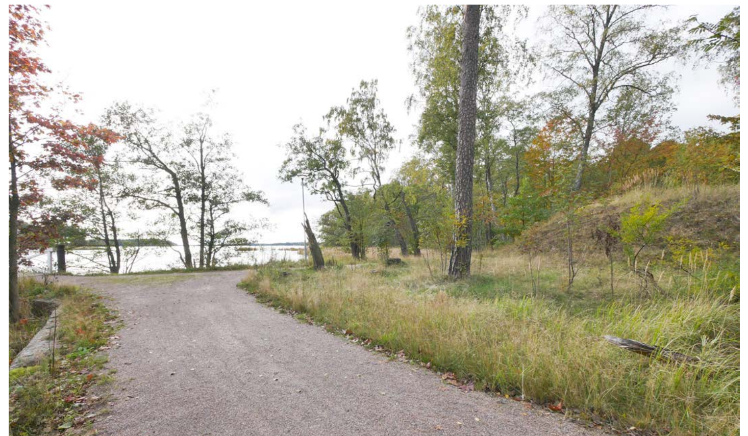
Oikealla näkyy tykkipatterin uloin luiska. Varustuksen polveileva siluetti kätkeytyy puuston lomaan.
