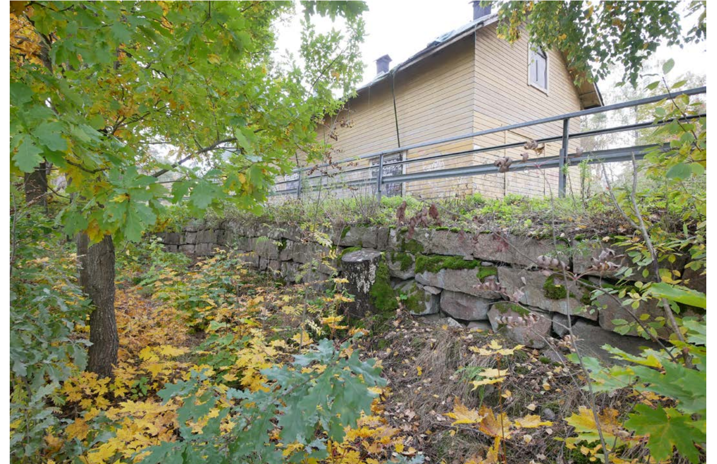
Riihen edessä on tukimuurin varaan rakennettu käytävä.
