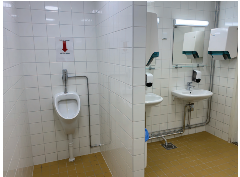
2. kerroksen varastotila (242) ja 3. kerroksen wc-tiloja (302).
