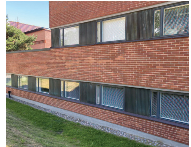
Eläväinen tiilijulkisivu paikkauksineen. Myös kupari on patinoitunut ajan kuluessa kauniisti.
