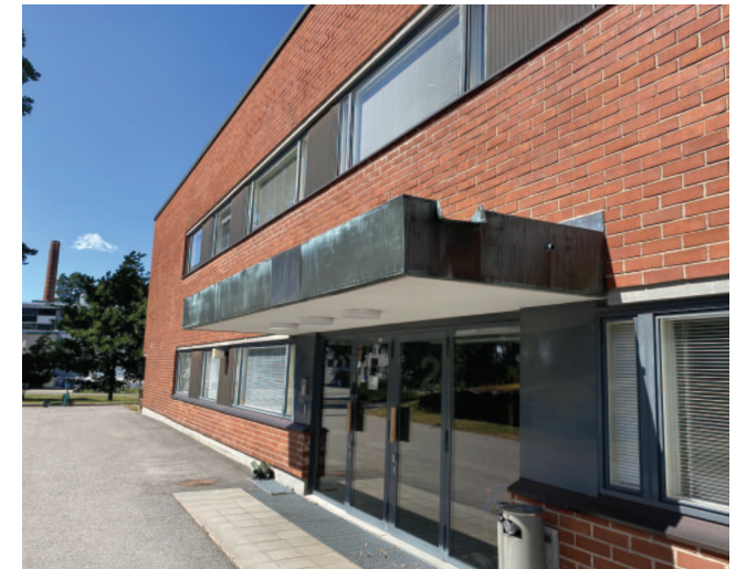
Laboratorio-osan kaakkoisen julkisivun alkuperäinen sisäänkäyntikatot.
