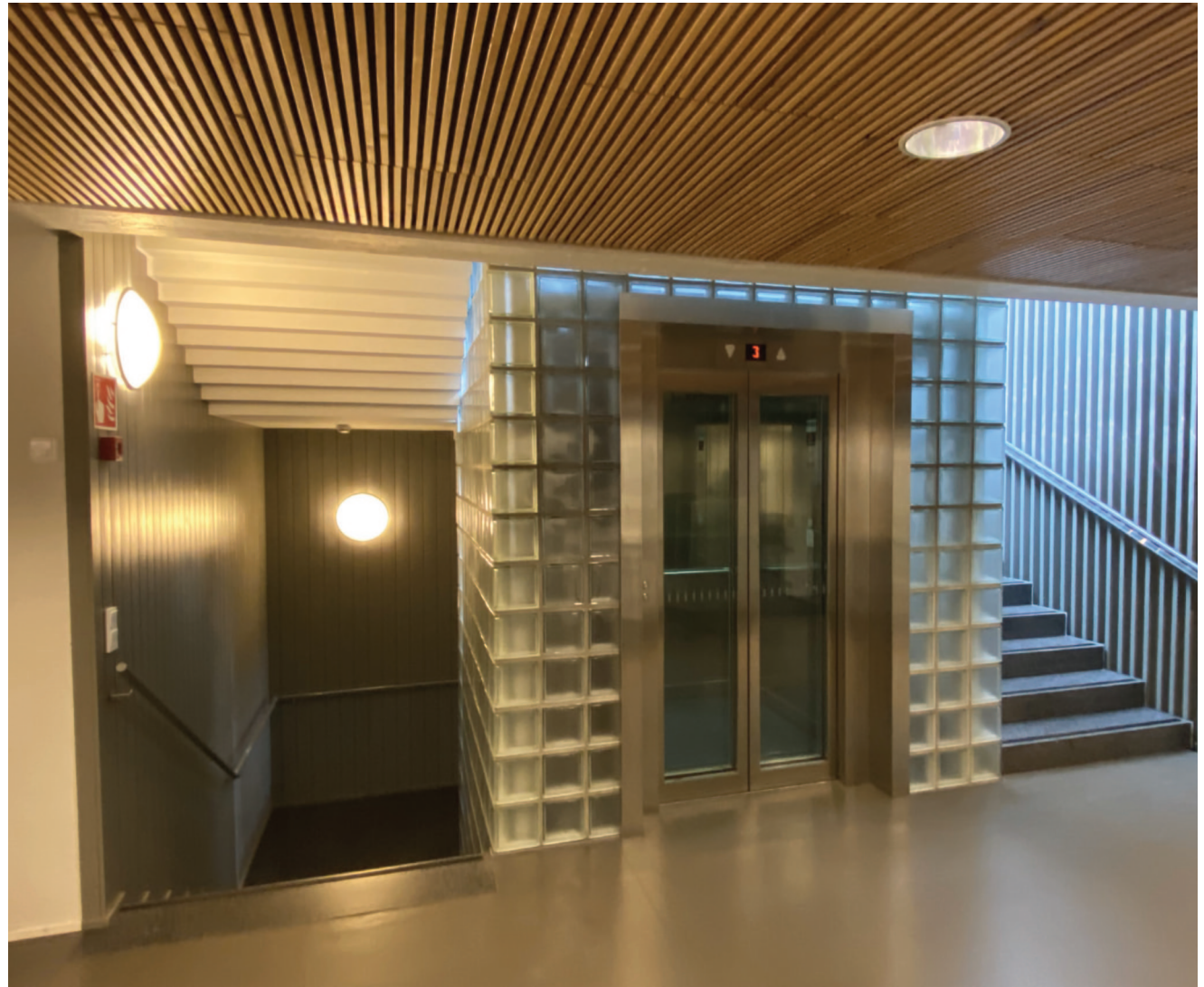
Porrashuone (201.16) 2. kerroksen tasolla. Porrashuone ja hissi on toteutettu vuosien 2007–2009 peruskorjauksessa. Tuolloin purettiin pääaulan aiempi kierreporras.
