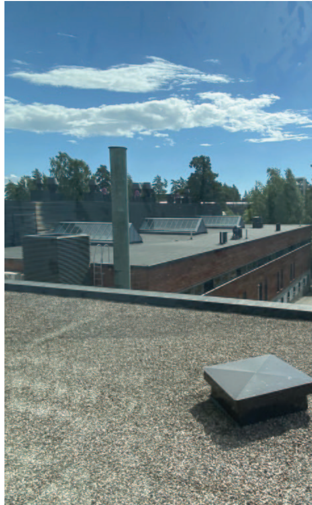
Näkymä laboratorio-osan katolta konehallin katolle.
