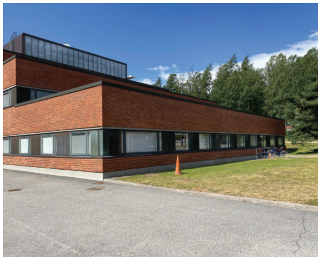
Merkittävin muutos laboratorio-osan koilliseen julkisivuun on vuosina 2007–2009 katolle rakennettu ilmanvaihtokonehuone.
