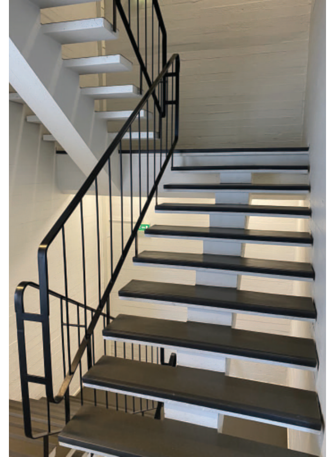
Laboratorio-osan ja konehallin välisen nivelosan portaikko (201.15) on harvoja 1960-luvun asussa säilyneitä tiloja rakennuksessa. Askelmien pintamateriaali on vaihdettu 2008, sillä alkuperäinen pinnoite sisälsi asbestia.
