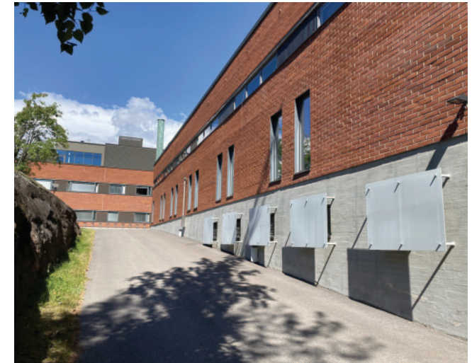
Konehalliosan lounaisen julkisivun ilmanottorilät on vuoden 2015–2016 peruskorjauksessa peitetty julkisivusta hieman irrallaan olevilla harmailla paneeleilla.
