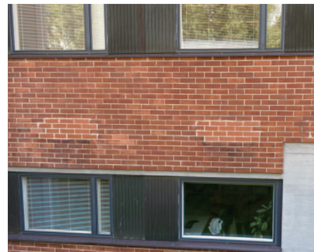
Vuosien 2007–2009 peruskorjauksen aikaiset tiilimuurauksen korjaukset näkyvät selkeästi Vuorimiehintien puoleisessa julkisivussa.
