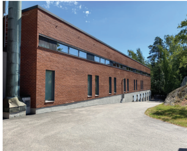
Konehalliosan julkisivu lounaaseen. Julkisivua on täydennetty 1. kerroksen uusilla ukkunoilla vuosina 2015–2016.
