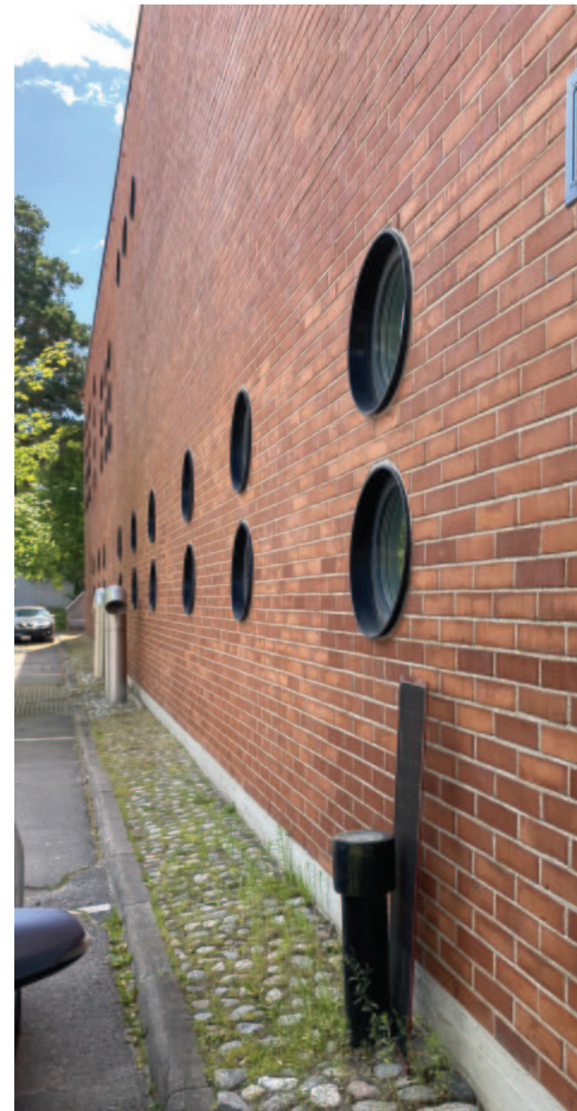
Konehalliosan koilliseen julkisivuun vuosina 2015–2016 lisätyt pyöröikkunat luovat uuden ajallisen kerrostuman koko rakennuksen yleisilmeeseen.
