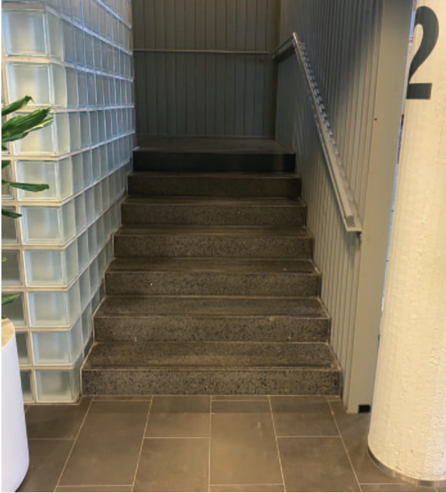
Pääportaan (101.3, 201.16, 301.18) askelmat ovat mosaiikkibetonia.
