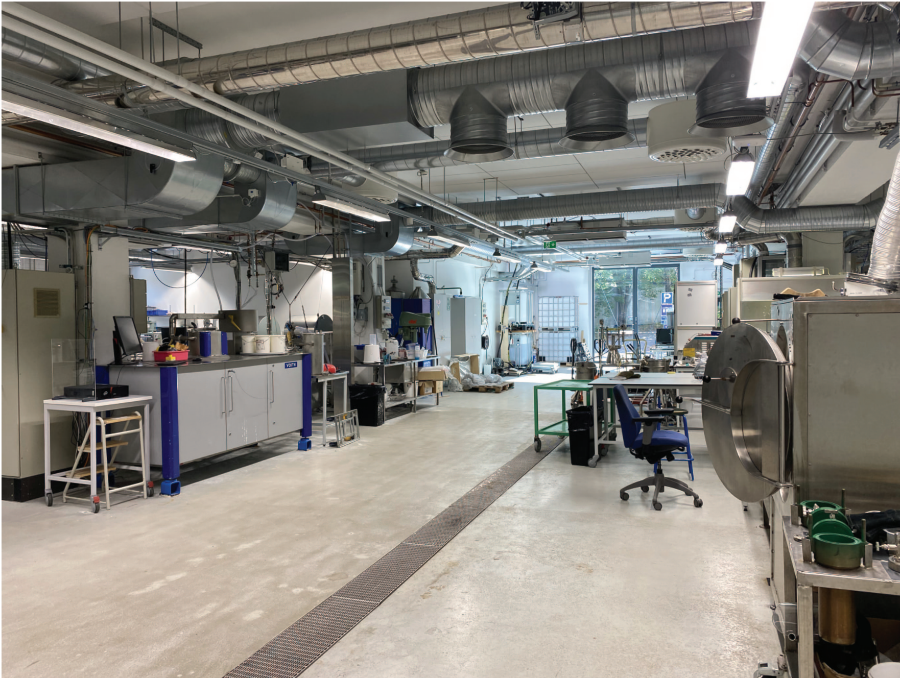
Konehalliosan 1. kerroksen työpis- teitä ja laitteita.
