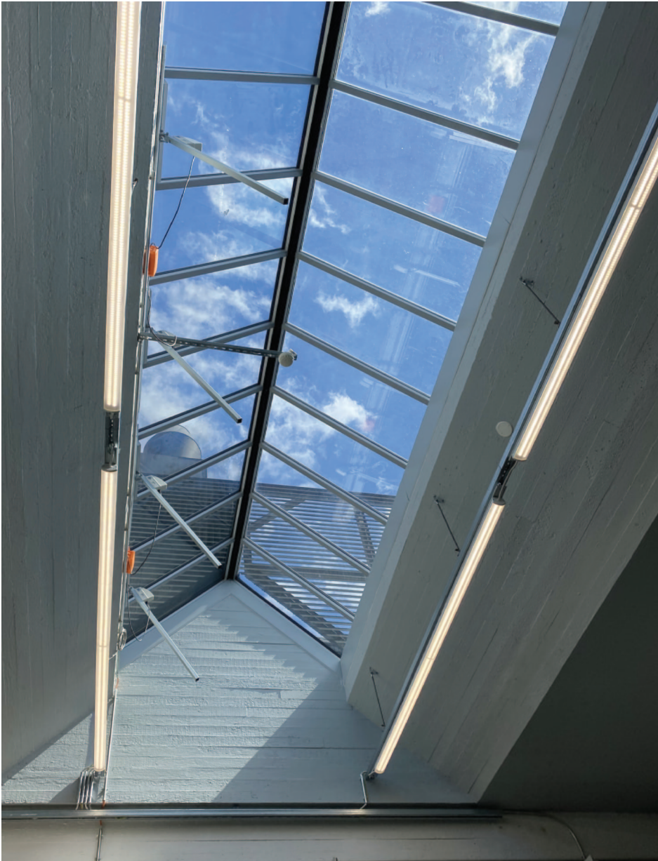
Konehalliosan alkuperäiset kattoikkunat uusittiin vuosien 2015–2016 peruskorjauksessa.
