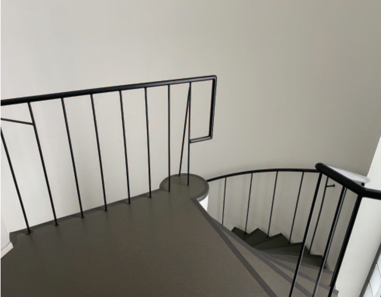
Vuorimiehentien puoleinen porrashuone (101.13, 201.14, 301.16) on rakennuksen ainoita alkuperäisenä säilyneitä tiloja. Askelmien pintamateriaali on vaihdettu asbestivapaaksi vuosien 2007–2009 peruskorjauksessa.
