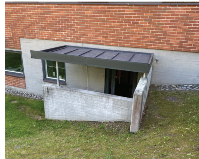
Vuorimiehintien puolella oleva uusi poistumiestie, joka on rakennettu laajennettuun 1. kerroksen osaan.
