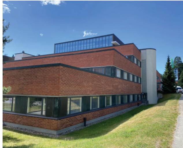
Vuorimiehentien puolella rakennuksen ja kadun välillä maastoa on muokattu merkittävästi alkuperäisen rakennusvaiheen yhteydessä, jotta ensimmäisen kerroksen ikkunat ja ovet on saatu maantasoon.
