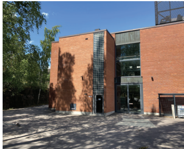
Konehalliosan kaakkoiseen julkisivuun on vuosien 2015–2016 perusakorjauksessa lisätty uusi porrashuone.
