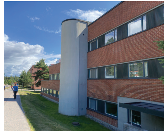
Vuorimiehintien puoleinen julkisivu (luoteeseen) sekä kierre- portaan umpinainen betoniseinä.
