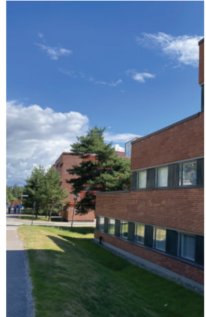
Näkymä Vuorimiehentieltä kohti koillista. Julkisivun takana näkyvä mänty kuuluu tonttialueen harvoihin alkuperäisiin puuistutuksiin.
