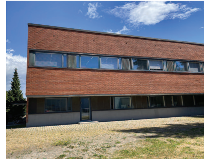
Lounaisessa julkisivussa kolmas kerros on rakennettu ulokkeelle, ja toisen kerroksen seinäpinta on betonia.
