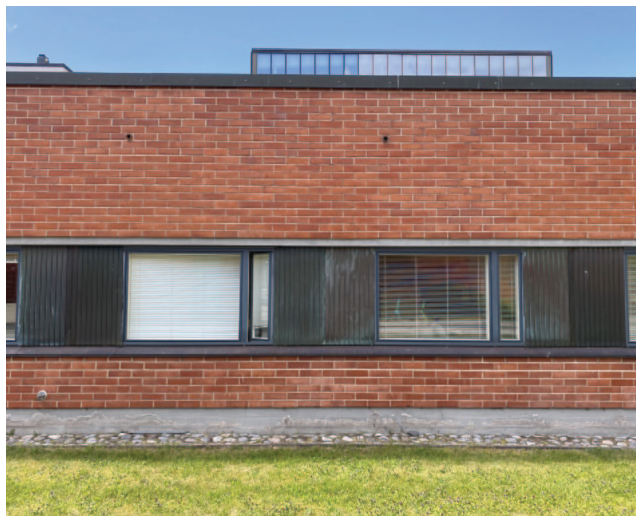
Laboratio-osan julkisivua koilliseen. Nauhaikkunat ja niitä rytmittävät profiloituneet kuparilevy-pinnoitteet.
