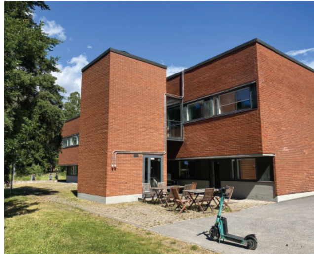
Laboratorio-osan julkisivu lounaaseen. Mehutölkkimäinen, umpitiilinen porrashuone on vuoden 2007–2009 peruskorjauksen lisä.
