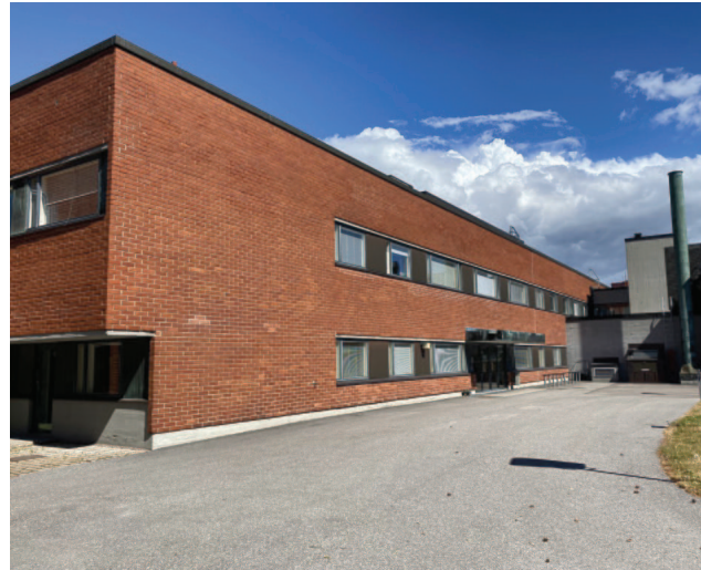
Julkisivu kaakkoon Tekniikantietn puolelta. Äärimmäisenä betonipintainen laboratorio-osan ja konehallin yhdistävä siipi kuparipinnoitteisine savupiippuineen.
