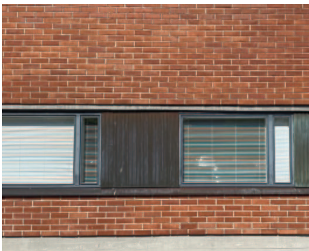
Rakennuksen julkisivujen perushahmo muodostuu tiilimuurauksesta sekä nauhaikkunoista, joiden välillä on profiloitua kuparia olevat levyt.
