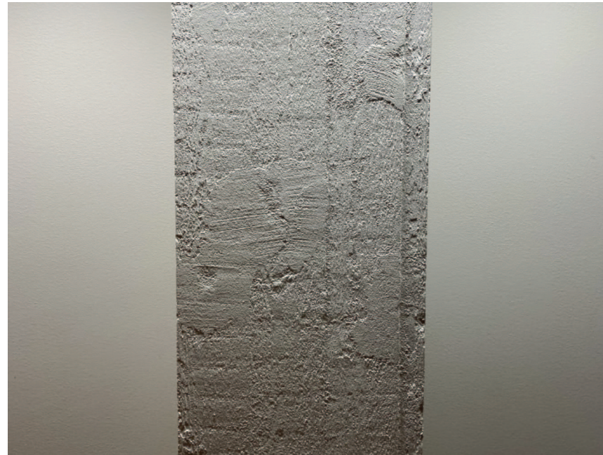
2. kerroksen käytävätiloja (201). Näkyviin jätetyt palkkien muottipinnat ovat tarkoituksenmukaisesti valaistuna kuin reliefejä.
