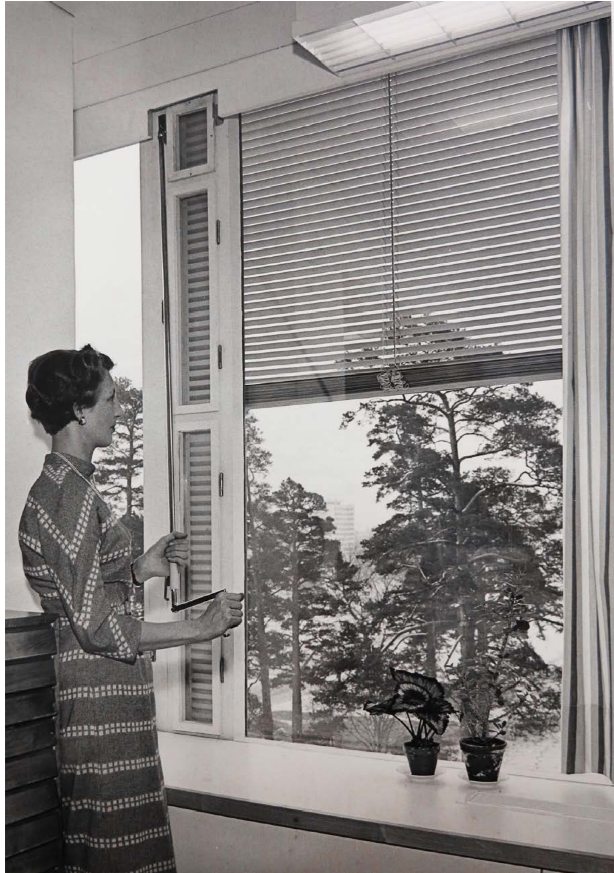
Toimistokerroksen ikkuna ja ulkopuolisen sälekaihtimen säätövipu, kuva 1961 Eero Troberg, Arkkitehtuurimuseo
