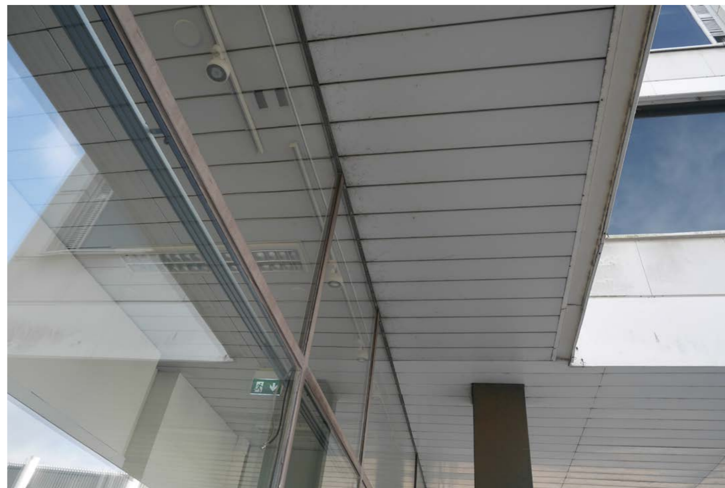
”Lipan” etureunan katveeseen on alkuperäisten detaljipiirustusten mukaan suunniteltu markkii-sikotelo.
