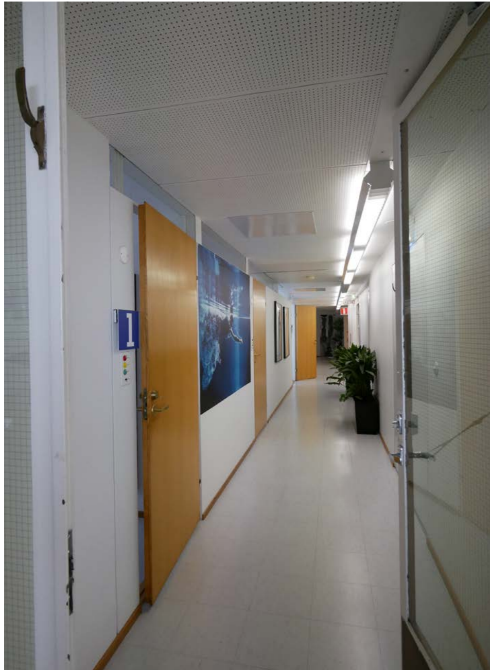
Ominaispiirteitään säilynyt käytävätila yläkkuinoineen ja lakattuine ovineen. Lattiapäällysteenä on alkuperäinen vinyylilaatta.
