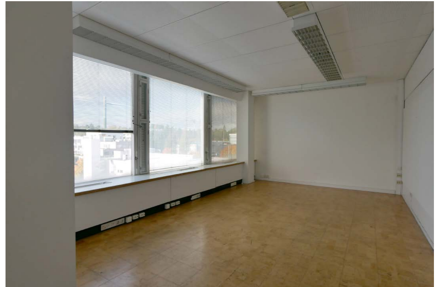
Ikkunaseinän säilynyt perusratkaisu leveine ikkunalautoineen, jonka alla on talotekniikan asennuskotelo.
