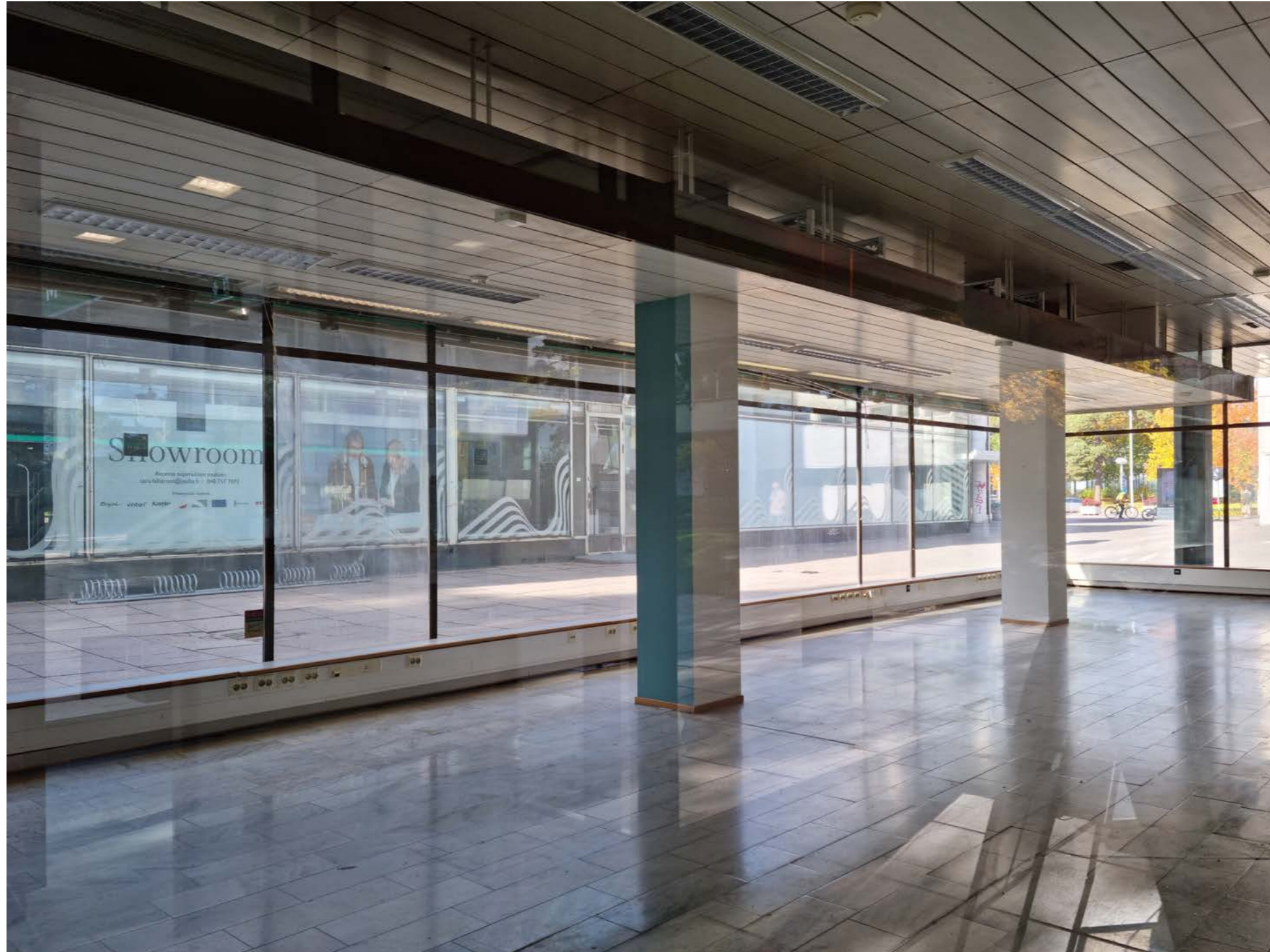
Pilaririvi ja lähes lattiasta kattoon ulottuvat sirorakenteiset ikkunat - sisätilan yhteys ulkotilaan - on pohjakerroksen leimallisia ominaispiirteitä.
