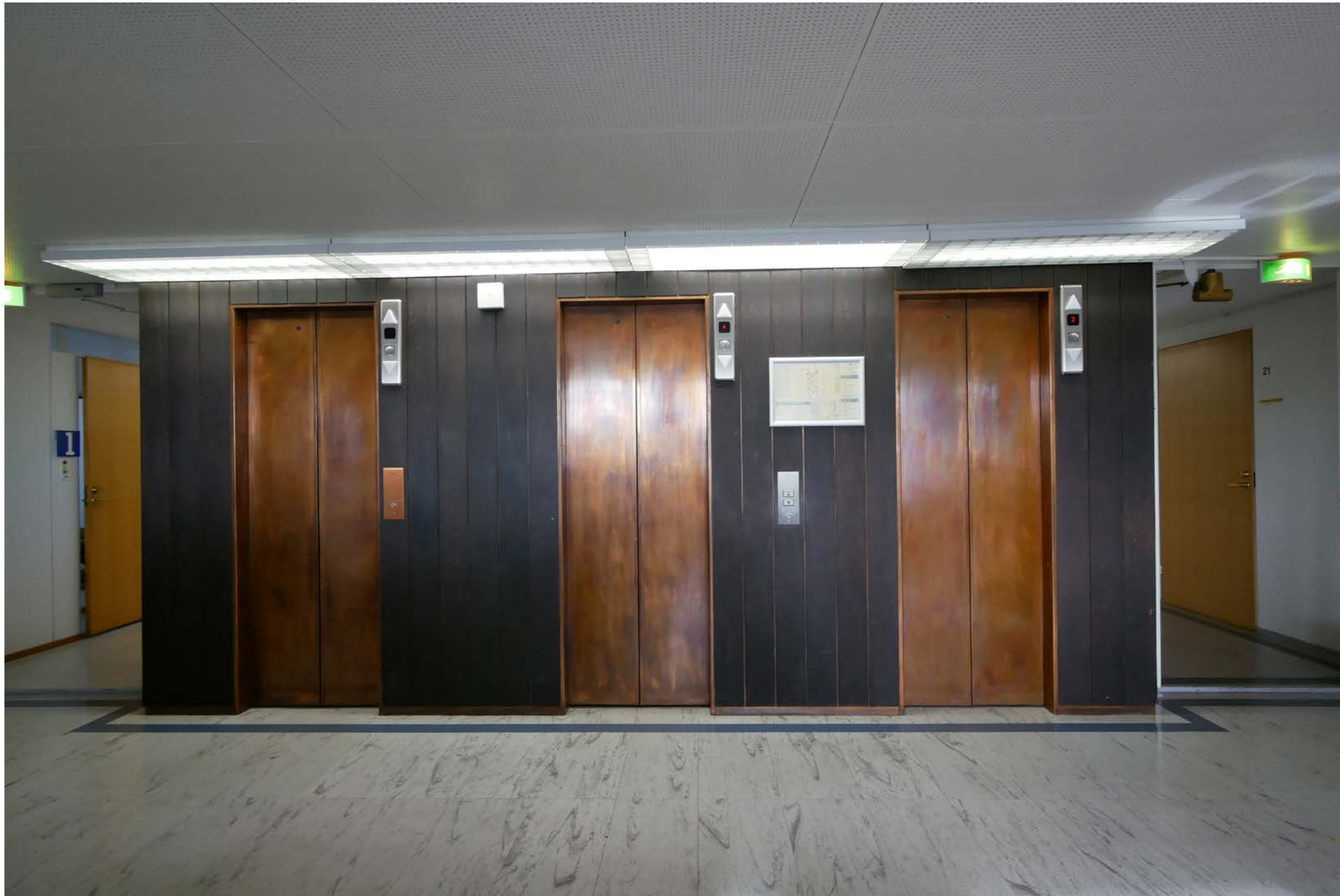
Kerroksissa toistuva tunnusomainen säilynyt, kuparilla ja tummaksi petsatulla puuverhouksella päällystetty hissirintama.
