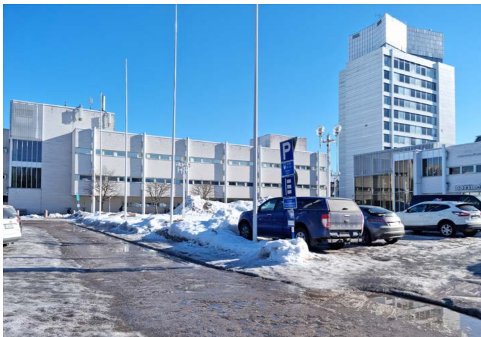
Keskustorni kuvattuna luoteesta Kulttuuriaukion ylitse, vasemmalla Kulttuurikeskuksen torinpuoleinen julkisivu.
