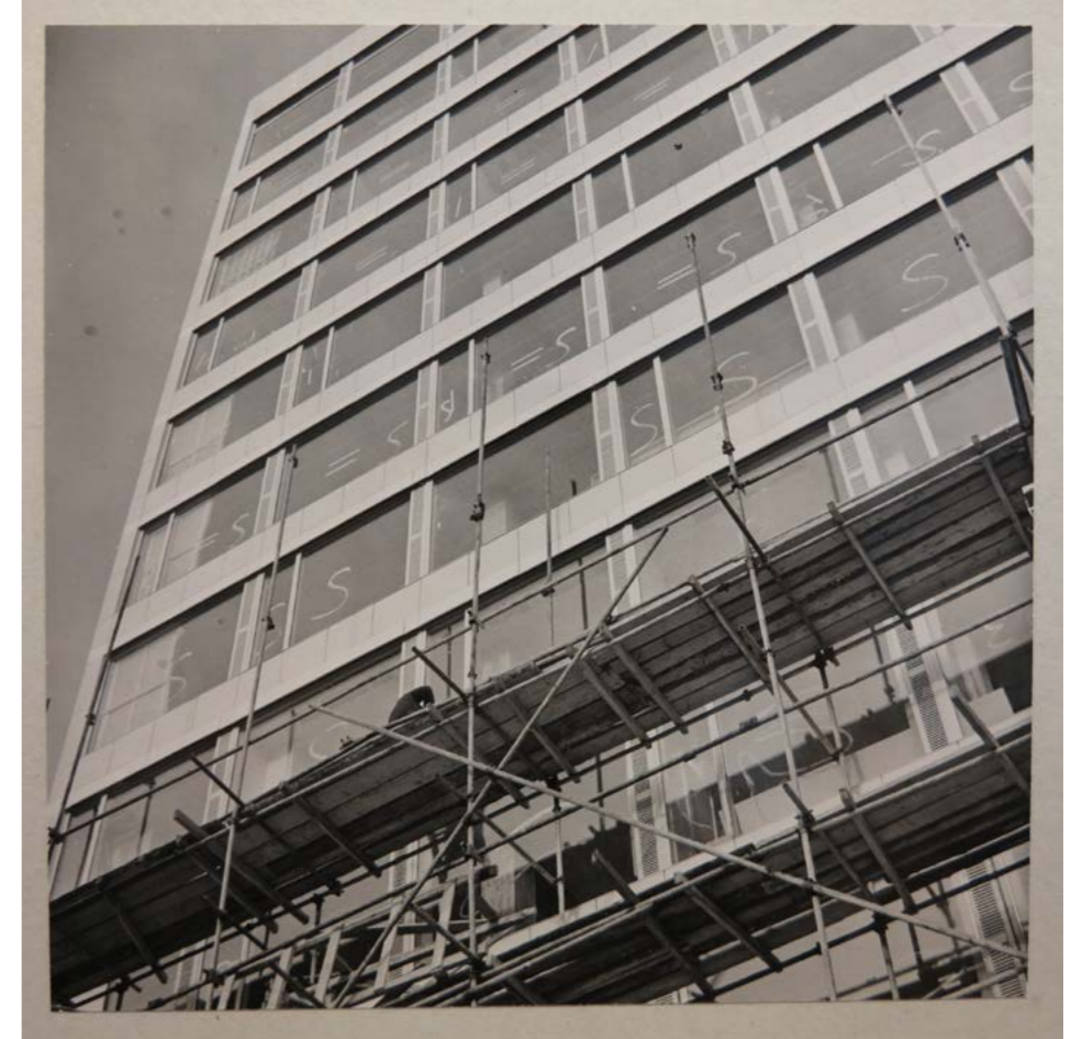
Keskustorni rakenteilla. Kuva Aarne Ervi, Arkkitehtuurimuseo
