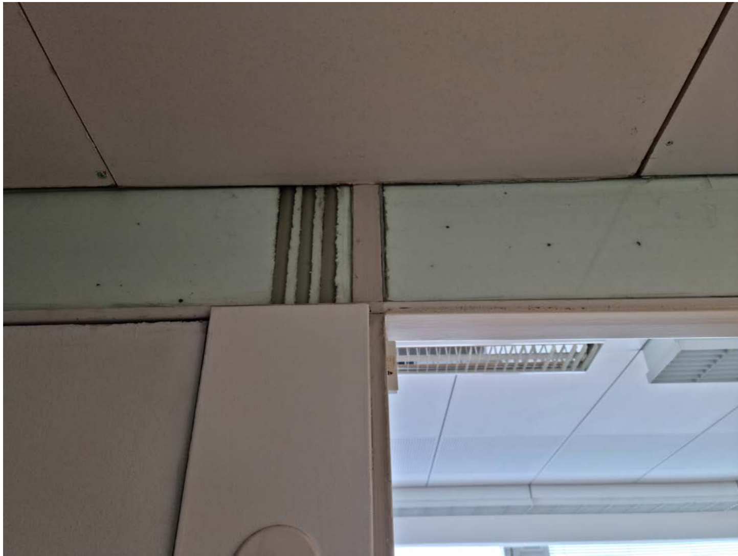
Säilyneitä väliseinä- ja alakattorakenteita. Käytäväseinän yläikkuna on peitetty.
