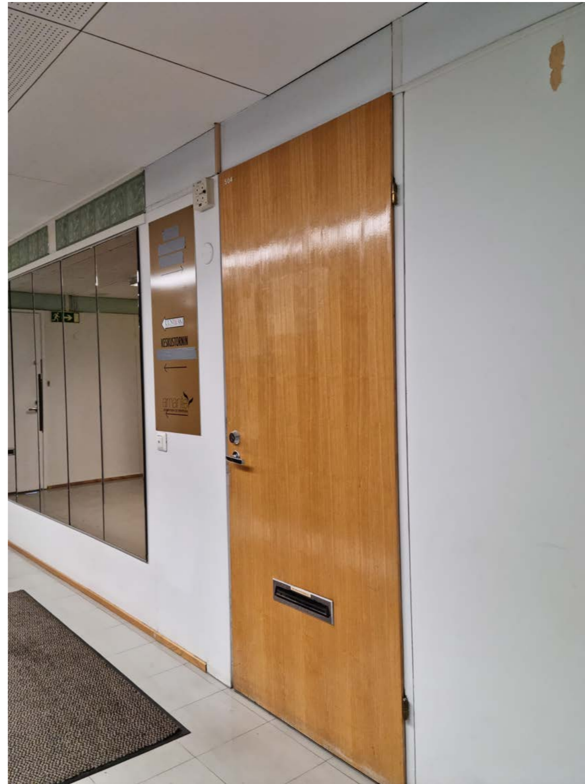
Käytävän oven alkuperäinen sovitus levyseinään ilman peitelistoja.
