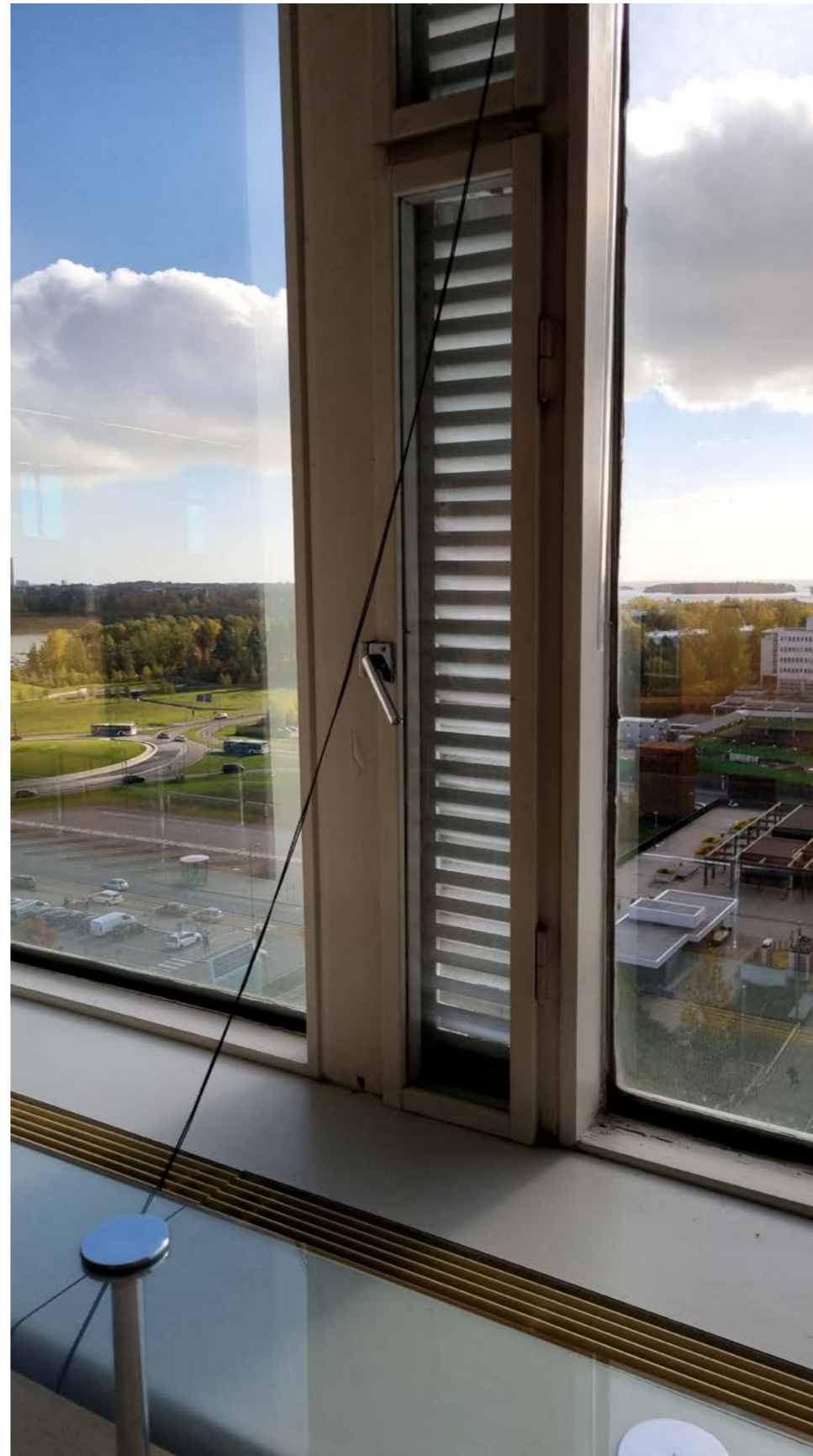
Ikkunan tuuletusluukku ja säleikkö. Ulkopuoliset sälekaihtimet on poistettu 1980-luvun alussa.
