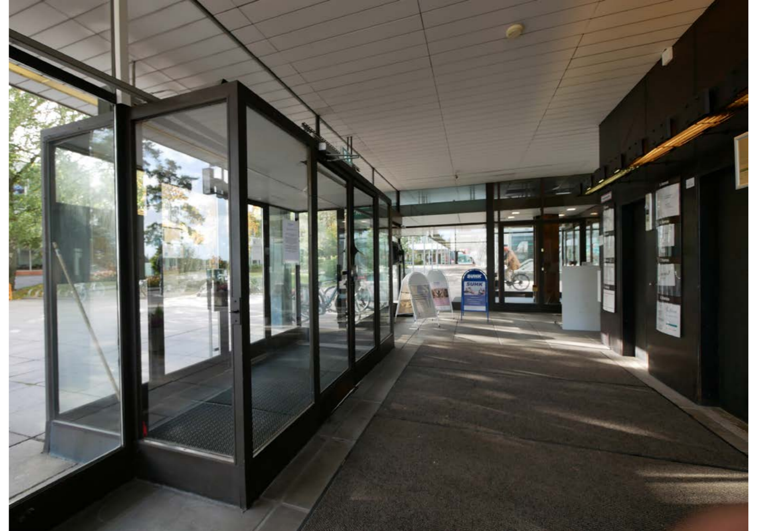
Hissiaula vuonna 2022. Pyöröovi vaihdettiin suorakulmaiseksi tuulikaapiksi viimeistään 1970-luvulla. Lattian betonilaatoitus on säilynyt.
