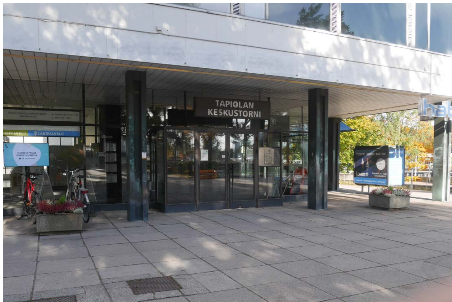
Sisään vedetyn julkisivun eteen muodostuu pilaririvin kehystämä katettu etutila.
