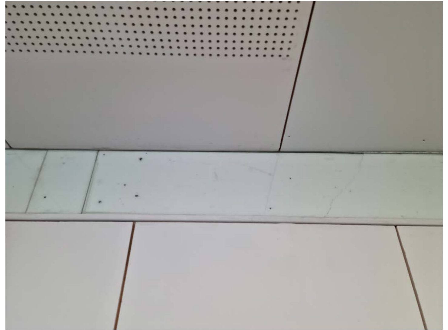
Käytävien alakatoissa on alun perin käytetty rei'itettyjä levyjä.
