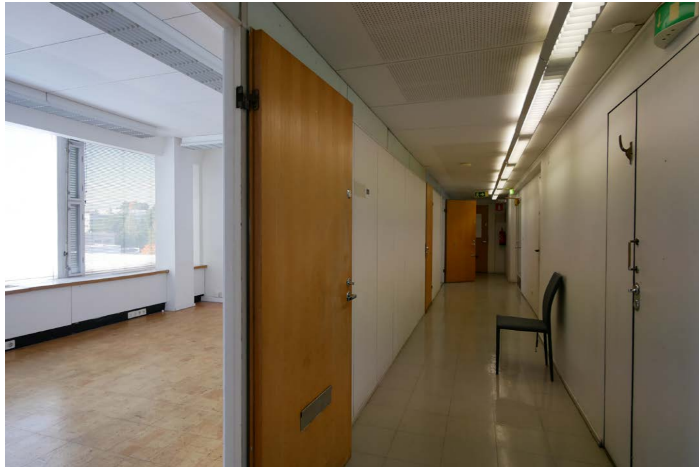
Länsisivun toimistokäytävän eleettömät peruspiirteet ovat säilyneet, yläikkunanauha on levytetty umpeen. Käytävän lattiapinnoitteena on alkuperäinen vinyylilaatta.
