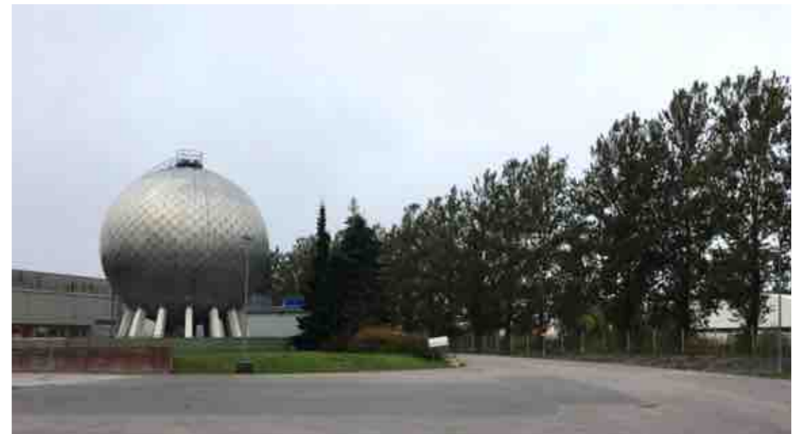
SPRINKLERIVESISÄILIÖ JA RADANVARREN PUURIVI (KUVA: B&M)
