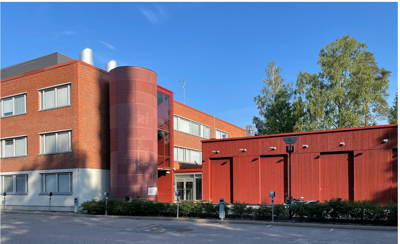
Haukilahden lukio ja puutyöhalli, nykytilanne
