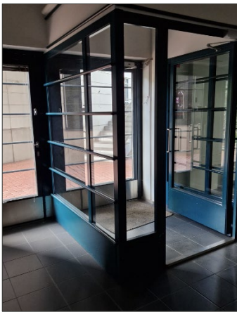
Kuva 6 Ulko-ovi ja tuulikaappi
