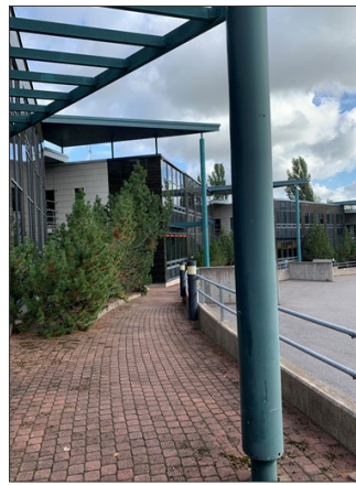
Kuva 7 Piharakenteita ja katoksia
