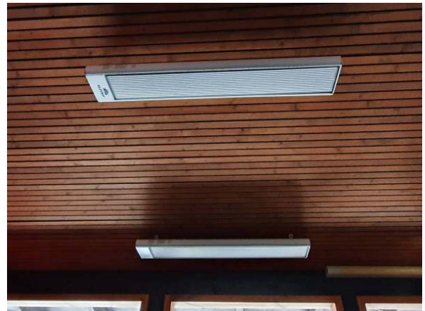
210. Huoltorakennuksen kattosäteilijöitä.
