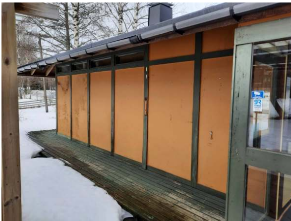
1. Vastaanoton takaosalla ränni, muualla ei.
