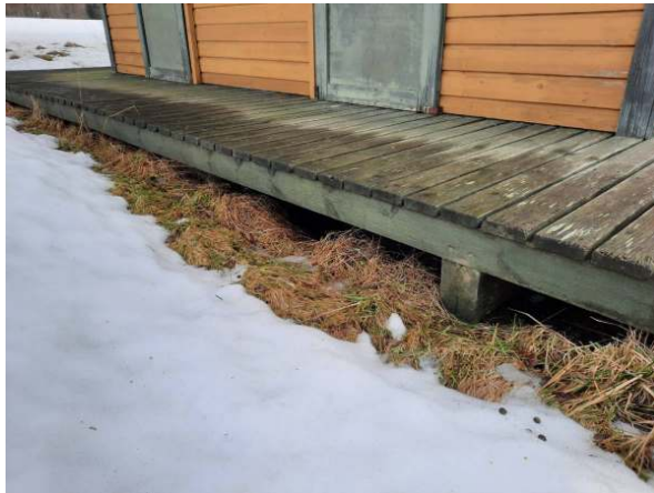
26. Huoltorakennusten perustukset alla.
