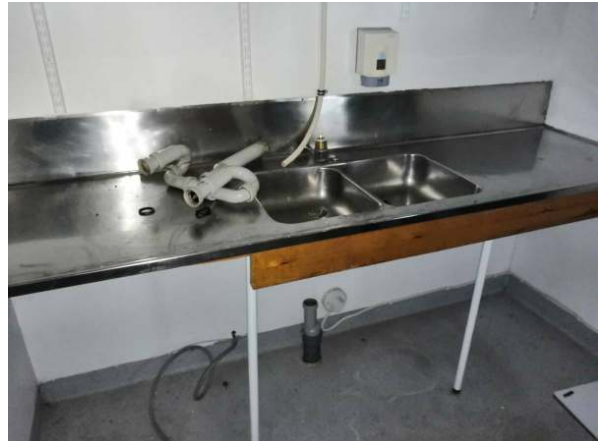
182. Viemäreitä on purettu vastaanottorakennuksessa.
