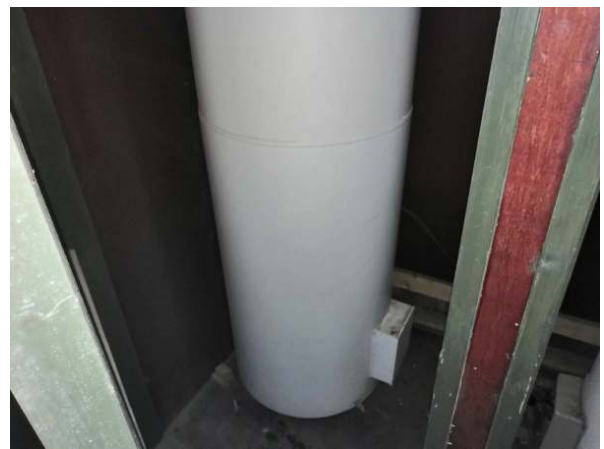
178. Suihkutiloja palvellut lämminvesivaraaja.
