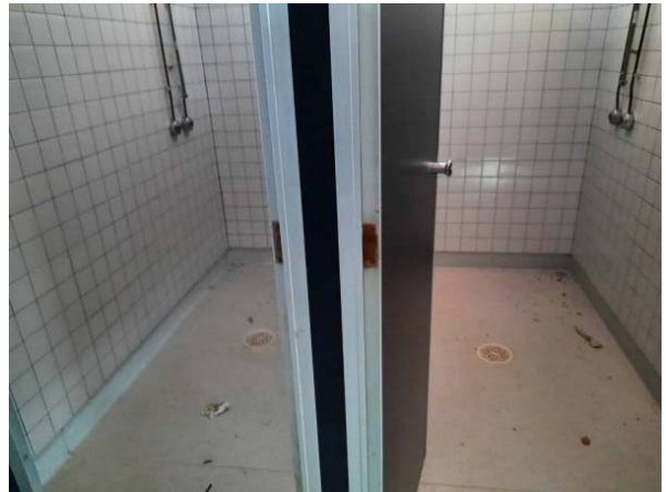
174. Uuden huoltorakennuksen suihkutilaa.
