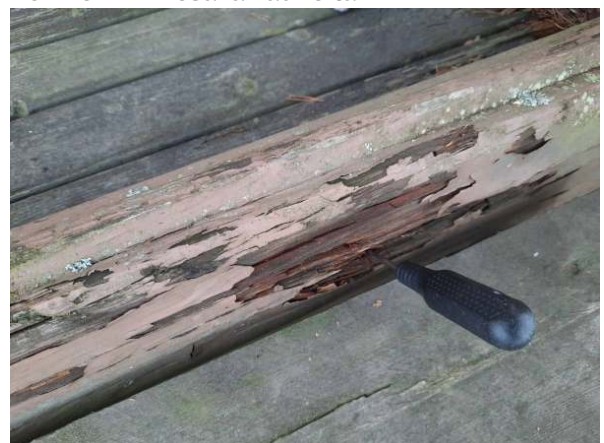
42. Mökin 14 osalla vaurioita.
