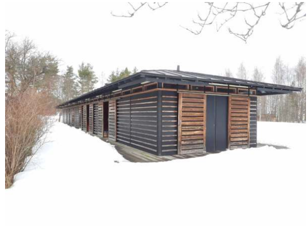
118. Vesikatto uudempi huoltorakennus.
