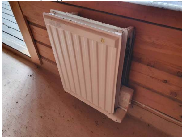
209. Saunarakennuksen sähköpatteri.
