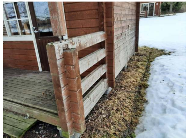
8. Mökkien osalla kattovedet ohjataan vierustalla.
