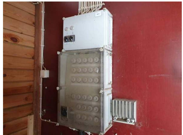
196. Vanhemman huoltorakennuksen keskus.
