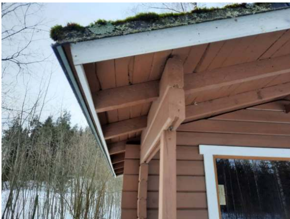
123. Mökkien katot ovat likaantuneita ja osin jo kuluneita.
