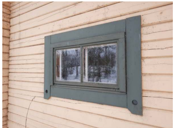
97. Valokuvaa saunan ikkunasta.
