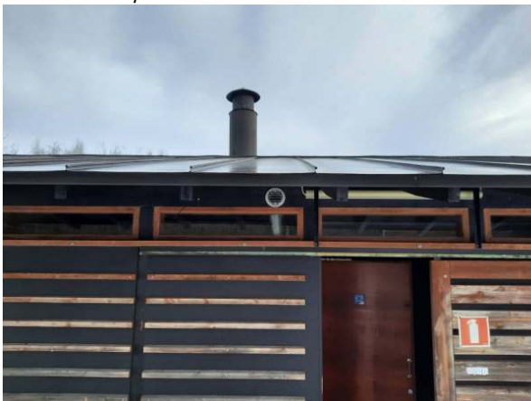
96. Valokuvaa uudempi huoltorakennus ikkunasta.
