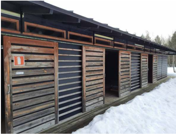
119. Vesikattoa uudempi huoltorakennus, joka vielä kunnossa.
