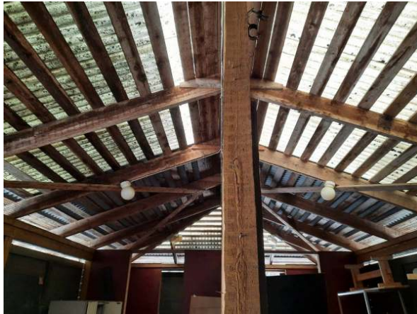
37. Kuvaa runkorakenteista huoltorakennuksessa.
