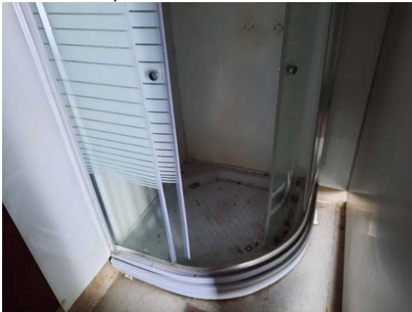
173. Vanhan huoltorakennuksen suihkutilaa.
