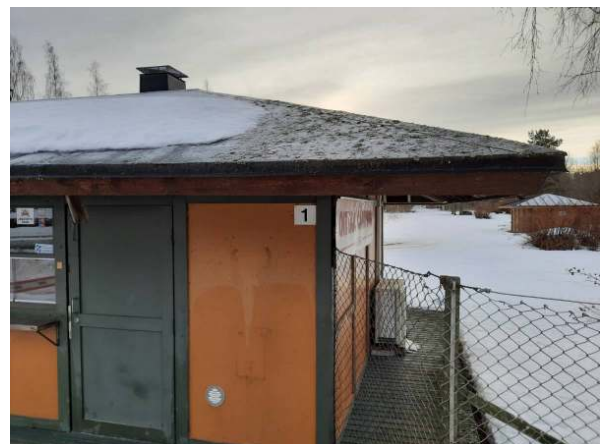
112. Sen bitumikate on likaantunut.
