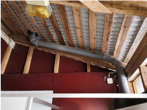
181. Tuuletusviemäri huoltorakennuksessa.
