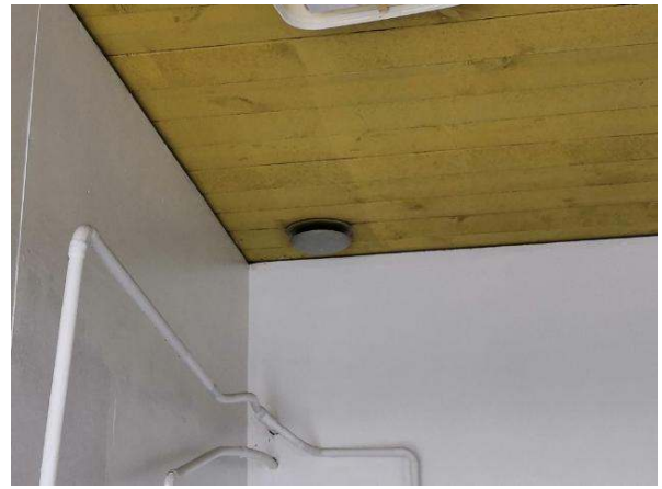
190. Lautasventtiili vastaanottorakennuksessa.
