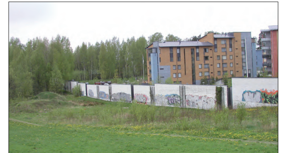
Kuva 3-26. Kaivoksen Vaskipellon alueen nykyiset Kehä II:n linjauksen suuntaiset autokatokset toimivat meluseinäinä. Katosten on suunniteltu jatkuvan eteenpäin Kehä II:ta seuraten.
