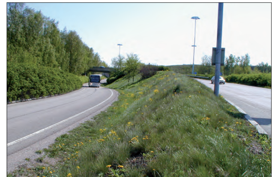
Kuva 3-41. Meluntorjunta hoidetaan meluvalleilla aina, kun se on mahdollista. Esimerkki Matinsolmusta.
