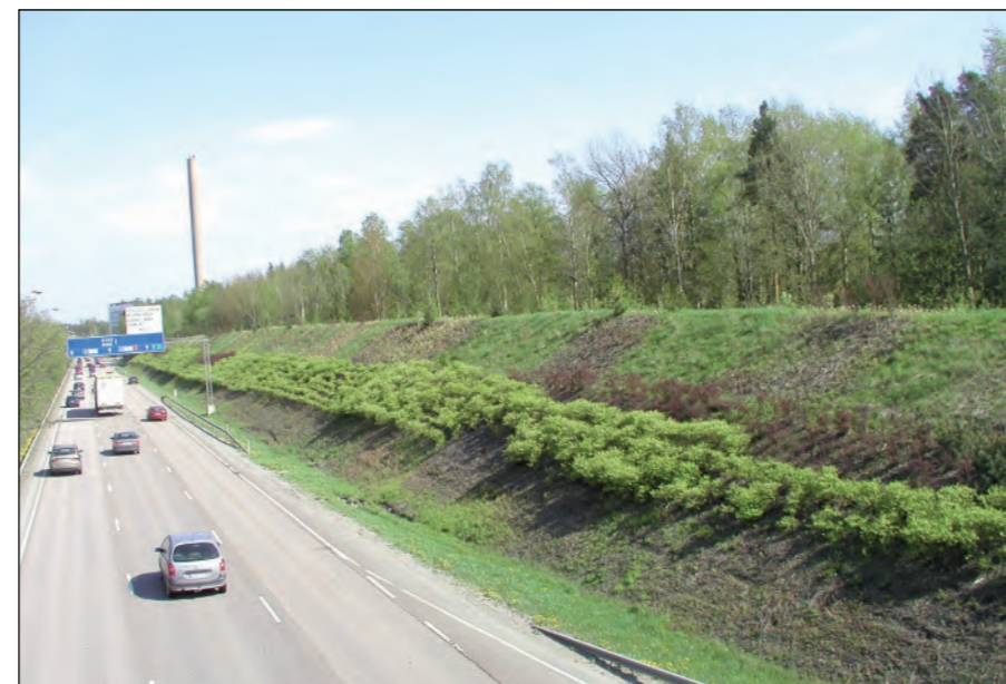
Kuva 3-22. Meluvalliesimerkki Kehä I:n varrelta Lassilasta. Meluvalleja on suunniteltu Kehä II:n jatkeen varrelle mm. Koivuvaaran kohdalle, Rajatorpantienvarteen sekä Kehä II:n ja Hämeenlinnanväylän liittymän alueelle.
