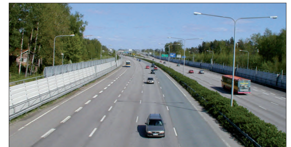
Kuva 4-18. Melusteiden ansiosta suunnittelukohteen asukkaat onnistutaan suojaamaan hyvin tiemelulta. Kuvassa Länsiväylän melusteita, jotka vastaavat mittasuhteiltaan mm. Äijänpellon tulevia esteitä.
