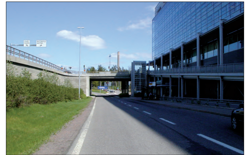
Kuva 3-42. Ahtaissa kohdissa joudutaan käyttämään tukimuureja. Esimerkki Matinkylän eritasoliittymästä (Iso Omena oikealla).
