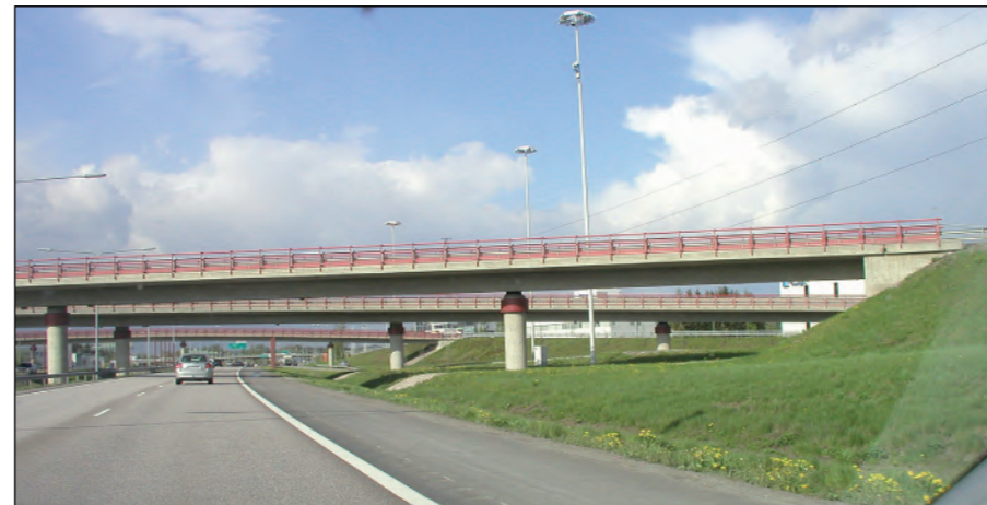
Kuva 3-36. Silloille voidaan antaa yksilöllistä tai alueellista ilmettä mm. värien käytöllä ja pienillä yksityiskohdilla. Kuvan esimerkki Tuusulanväylän ja Kehä III:n eritasoliittymästä. Kehä II:lla siltojen tunnusväri on sininen.
