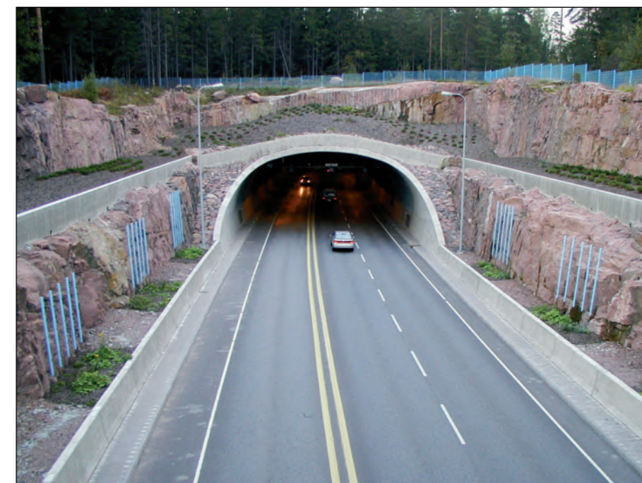
Kuva 3-32. Hiidenkallion tunnelin eteläinen suuaukkoalue. Uusi tunneli rakennetaan nykyisen tunnelin itäpuolelle (kuvassa oikealle puolelle).
