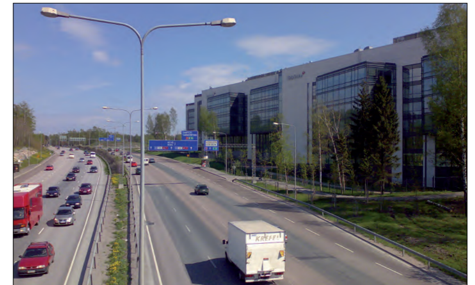
Kuva 3-54. Kuninkaantammen alueelle kaavailtu liikerakentaminen rajautuu tulevan Kehä II:n ja Hämeenlinnanväylän eritasoliittymän koilliselle sektorille. Kuvassa vastaava tiemaisemaa Kehä I:ltä Pohjois-Haagassa.
