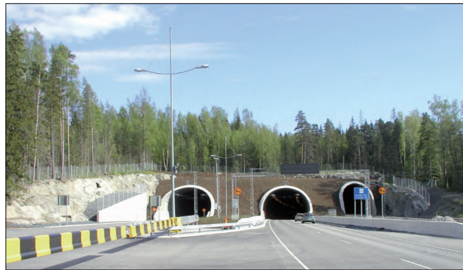
Kuva 3-40. Karakallion ja Hämeenvaaran tunneleiden itäiset suuaukot vastaavat korkeussuhteiltaan kuvassa olevaa Vuosaaren tie- ja ratatunneleiden pohjoista suuaukkoaluetta.
