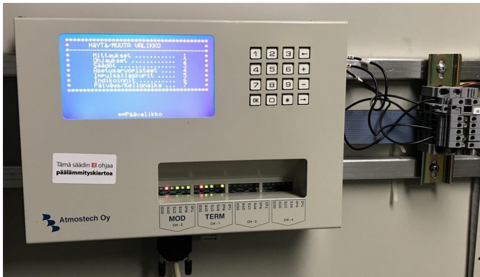
Kuva 6.1. Atmostech CPU A88.
