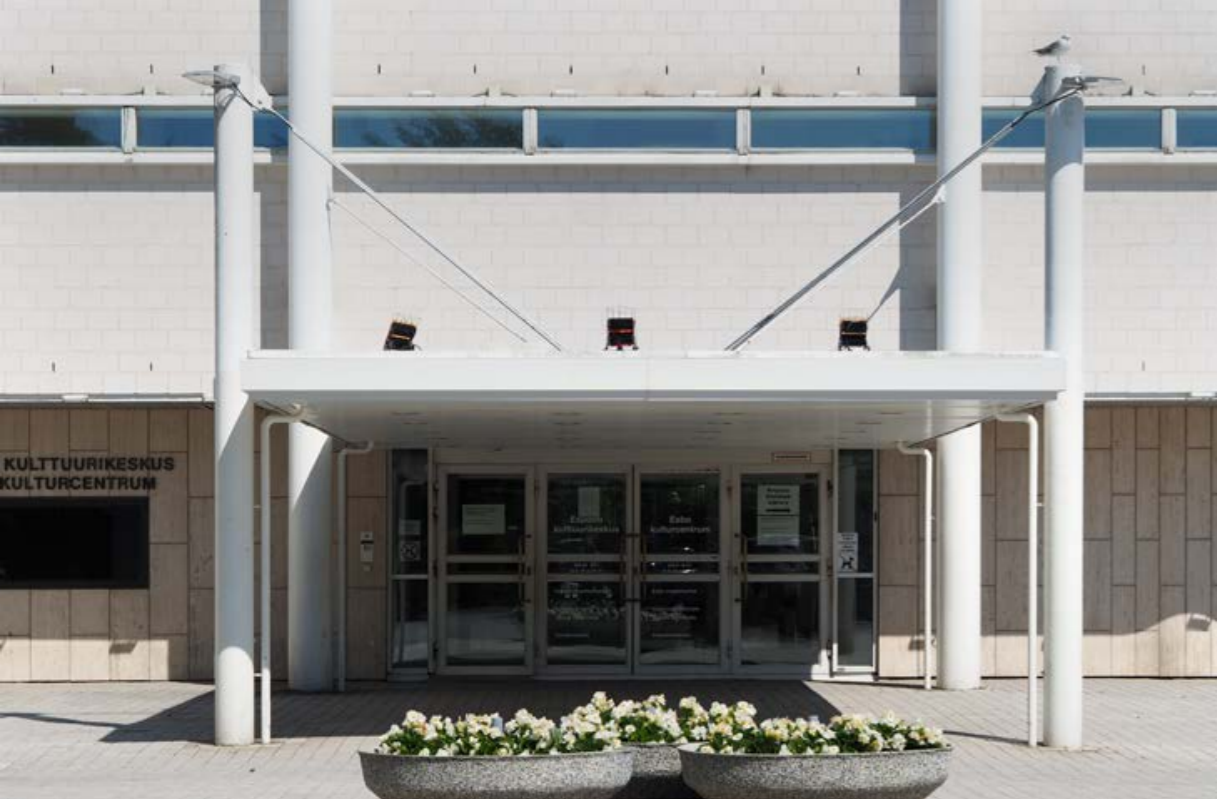
↑ Kulttuuriauktion puoleinen pääsisäänkäyntikatos laskeutuu matalalle tulijan ylle. Rakenne on omintakeisesti ripustettu pilarien varaan. Sisäänkäynti on korostettu molemmiin puolin julkisivun travertiiniverhouksella. Kuvassa näkyy myös julkisivun ja pilarien eleetön liittyminen aukiopintaan. amoy 2020
