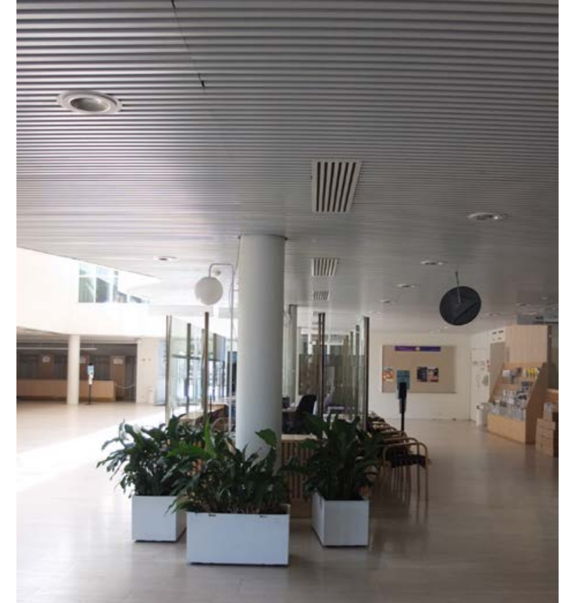
←← Viereinen sivu: Alakaton avaus Louhisalin ylälämpiössä paljastaa mineraalivillalevyjärjestelmän yläpuolella kulkevat IV-asennukset. amoy 2020
