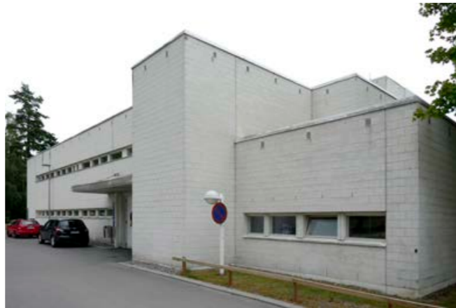
↑ Pohjoisjulkisivu on kiistatta kulttuurikeskuksen koruttomin. Salien taustatiloille ja logistiikalle varatussa rakennuksen pohjoisosassa olennaista on massoitteleminen, josta salit erottuvat hierarkisesti ja muurimainen julkisivu, jossa aukotus on toteutettu matalina nauhoina. amoy 2020
