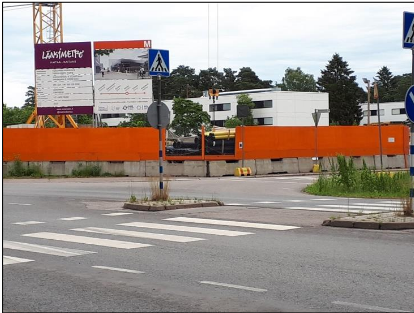
Kuva 16. Kaitaan metroaseman rakennustyömaa 26.6.2019
