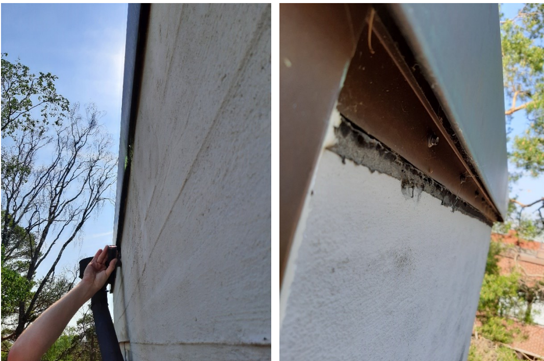
Räystäään tutkimista. Lista todennäköisesti estää lepakoiden pääsyn rakennukseen.
