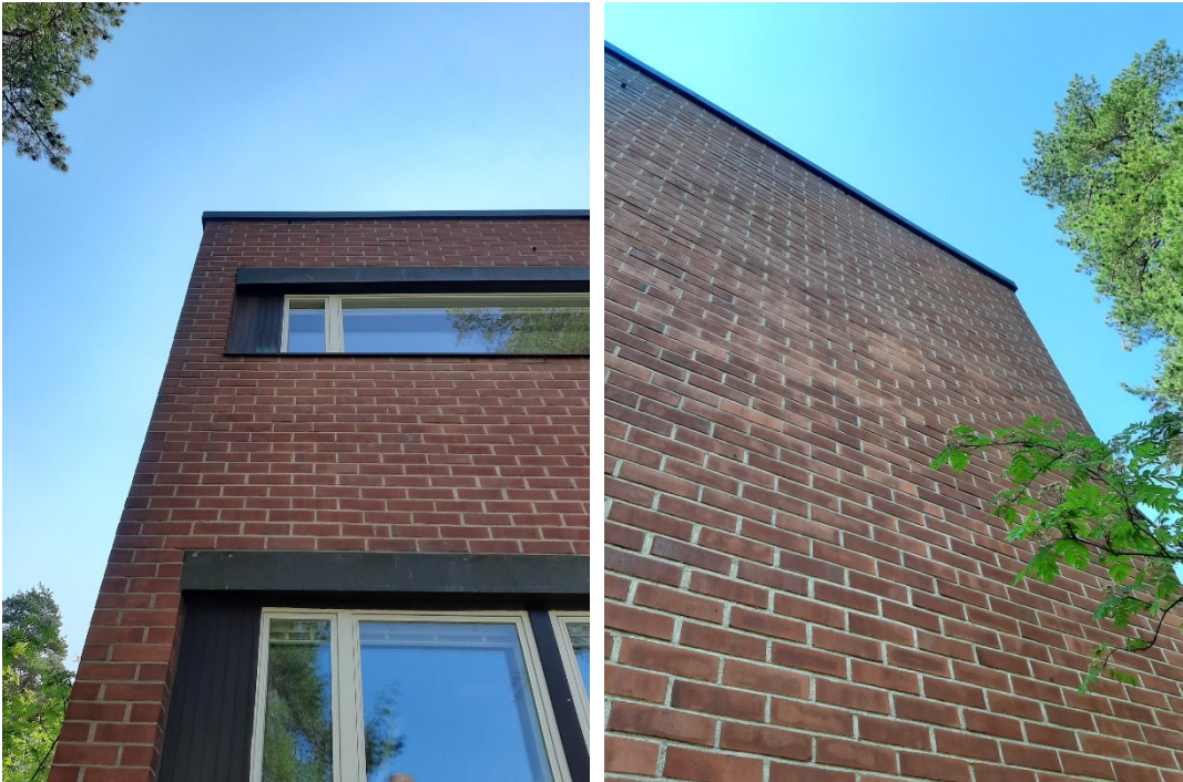
Rakennuksen seiniä ulkoa. Oikeassa kuvassa näkyy ylhäällä tiilenrako.
