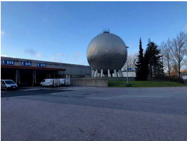
Kuva 4 Sprinklerijärjestelmän varavesisäiliö
