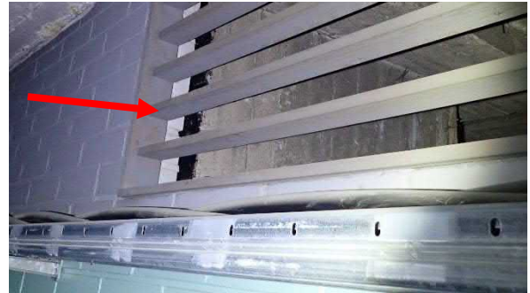
Kuva 14. Maanvastaisten rakenteiden vedeneristeet (bitumikermit ja -sivelyt) saattavat sisältää asbestia ja PAH-yhdisteitä.
