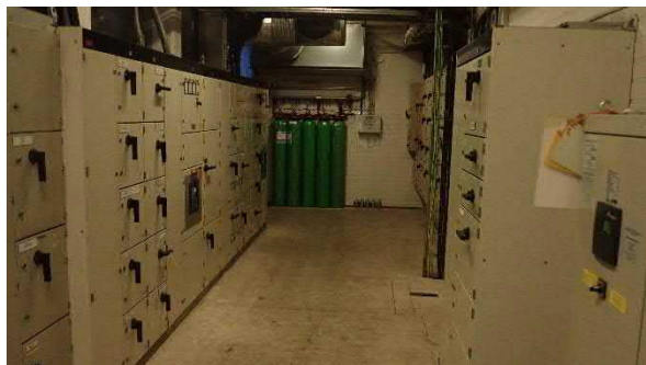
Kuva 5. Asbestipitoinen 250 mm x 250 mm vinyylilaatta
