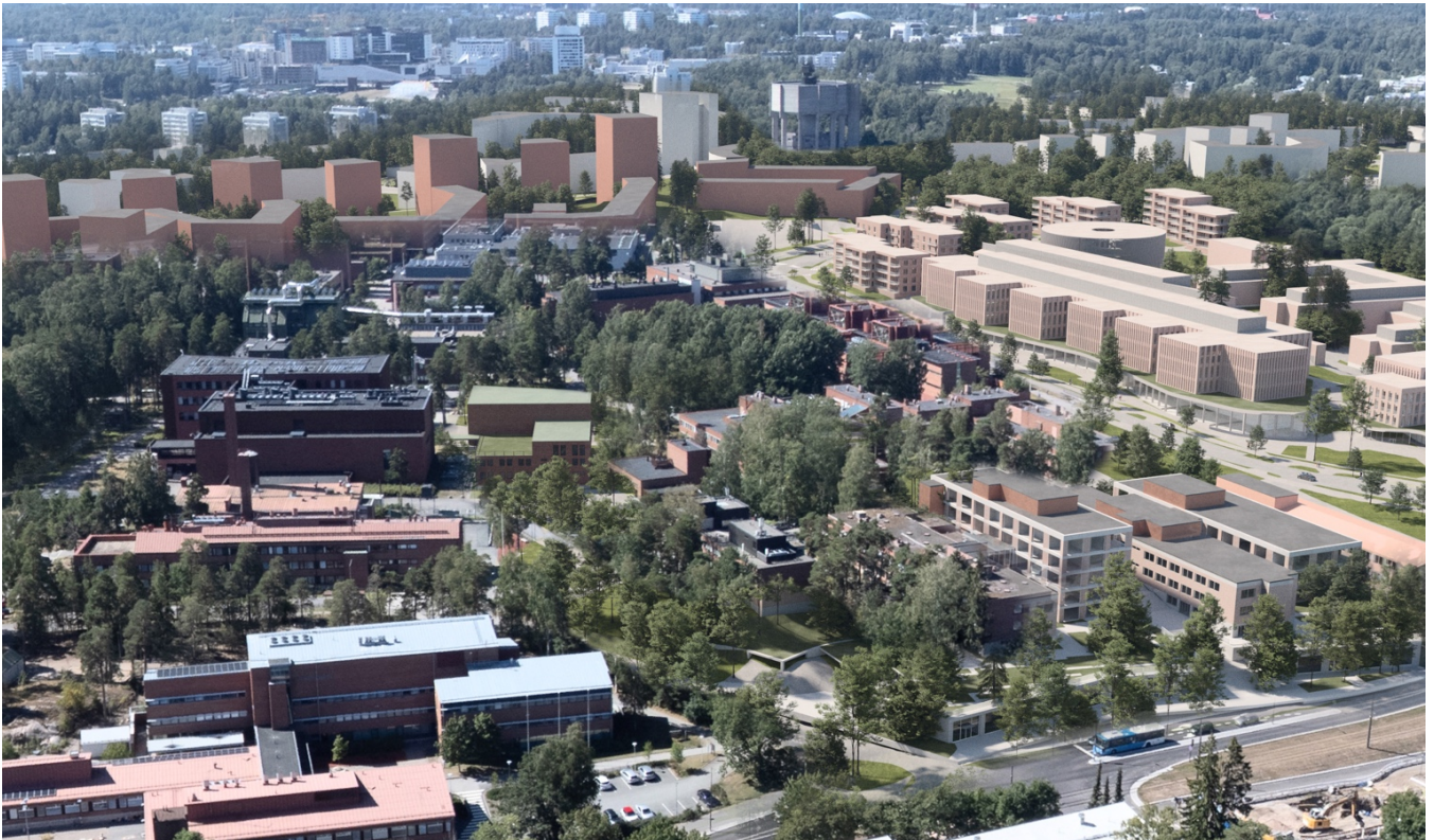
Ydinturvatalo sijaitsee keskellä Kivimies-korttelin pohjoisosaa. Lisärakennus muodostaa yhdessä GTK:n talon kanssa taustaseinän Geologinpuistolle. Kaavaluonnosvaiheen havainnekuva. Kuva Tietoa Oy.
