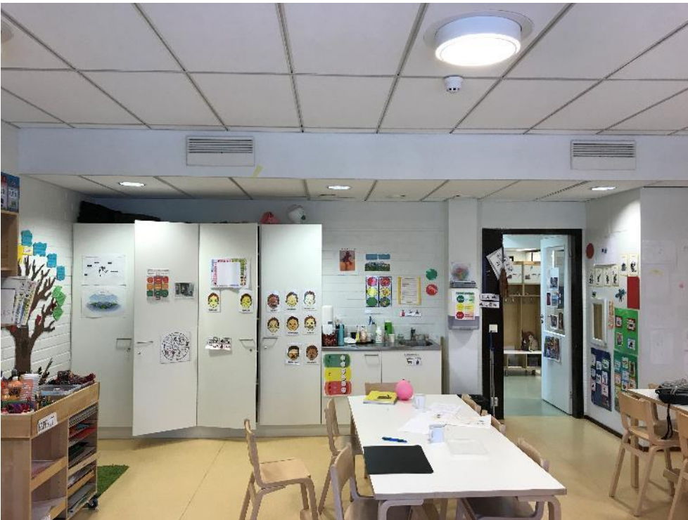
Kuva 4.7. Huoneen 219 reunimmaisessa kaapissa on koettu hajuongelma.
