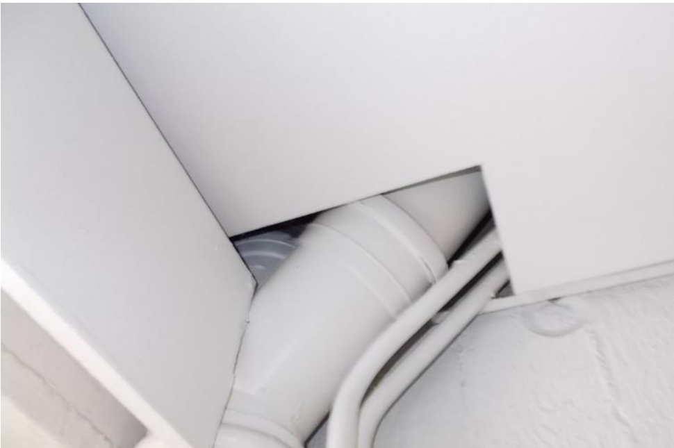
Kuva 4.5. Läpivienti huonetilassa.
