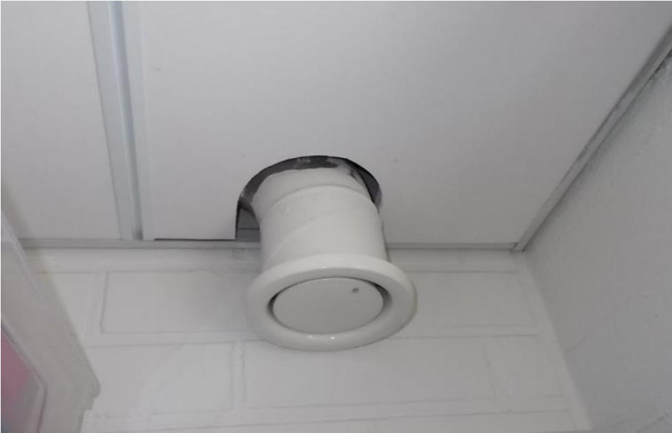
Kuva 4.6. Läpivienti huonetilassa.
