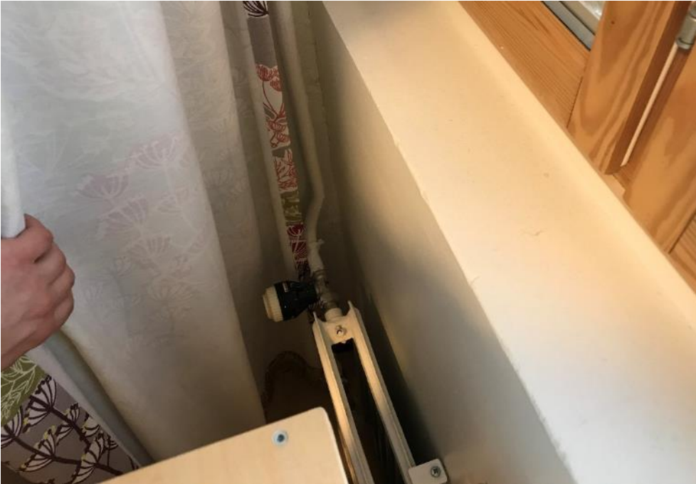
Kuva 5.3. Patteritermostaatit on verhojen sisällä.
