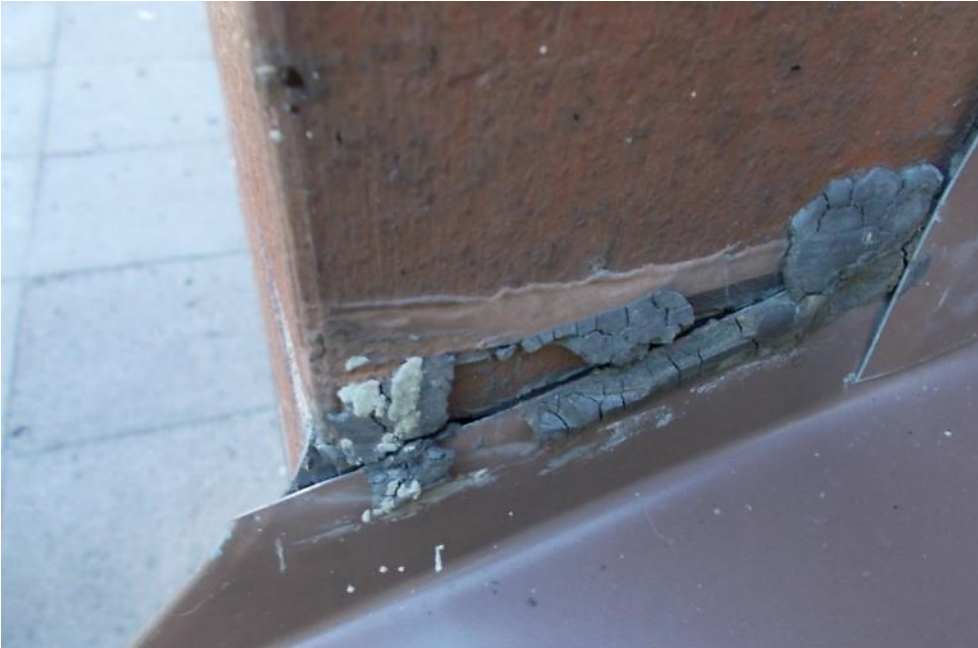
Kuva 4.4. Ikkunan vesipellin ylösnosto.
