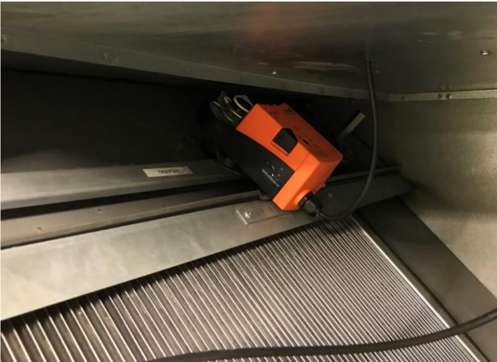
Kuva 6.3. LTO-peltitoiminnassa on ongelmia.
