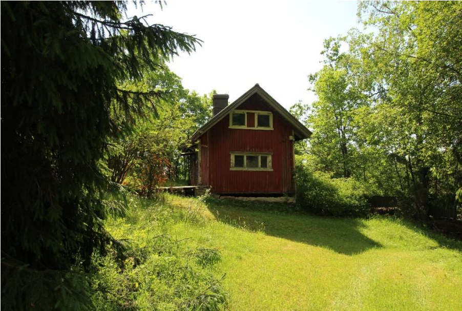
AKDG6889:49 Espoo Nupurinkallio. Gumböle Albacka. Pihapiiriä. Kuvattu luoteesta. Kuvaaja Tuija Väisänen.
