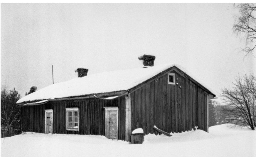
Yllä oikealla (423_820_2) ja vasemalla (423_819_2) valokuvat Nupurin mäkituvasta 1980-luvulla. Vasen valokuva rajattu. Kuvat Erkki Härö 1982/ Espoon kaupunginmuseon kokoelmat.
