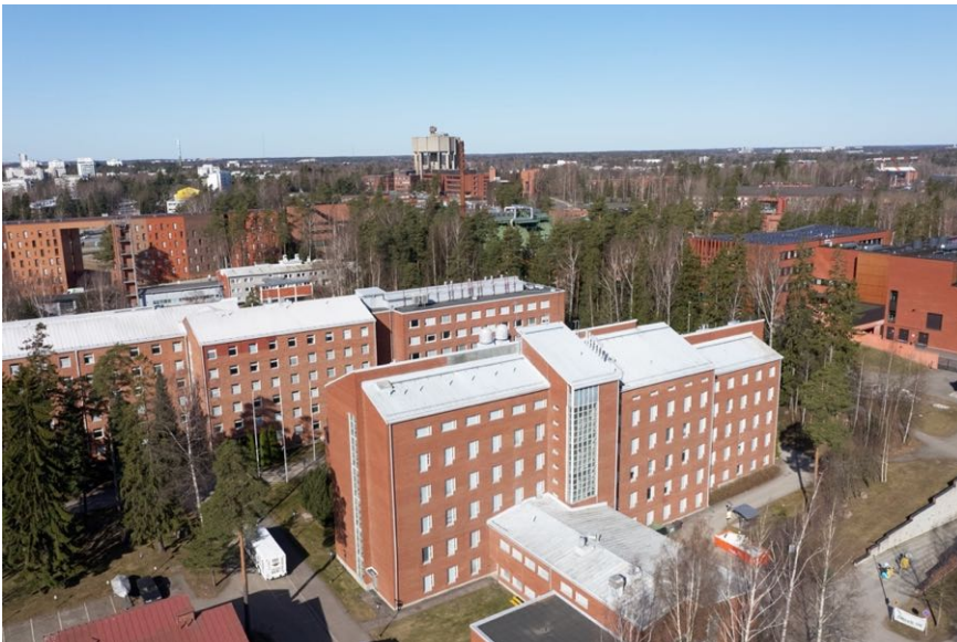
Kuva 13. Otaniemen keskellä oleva metsikkö on Espoon liito-orava-aineistossa esitetty liito-oravien kulkuyhteydeksi. Ylempää otetussa kuvassa näkyy hyvin, miten rakennusten väliin jää pieniä metsiköitä. Liito-oravat pystyvät niillä elämään, jos niihin on puustoinen yhteys.
