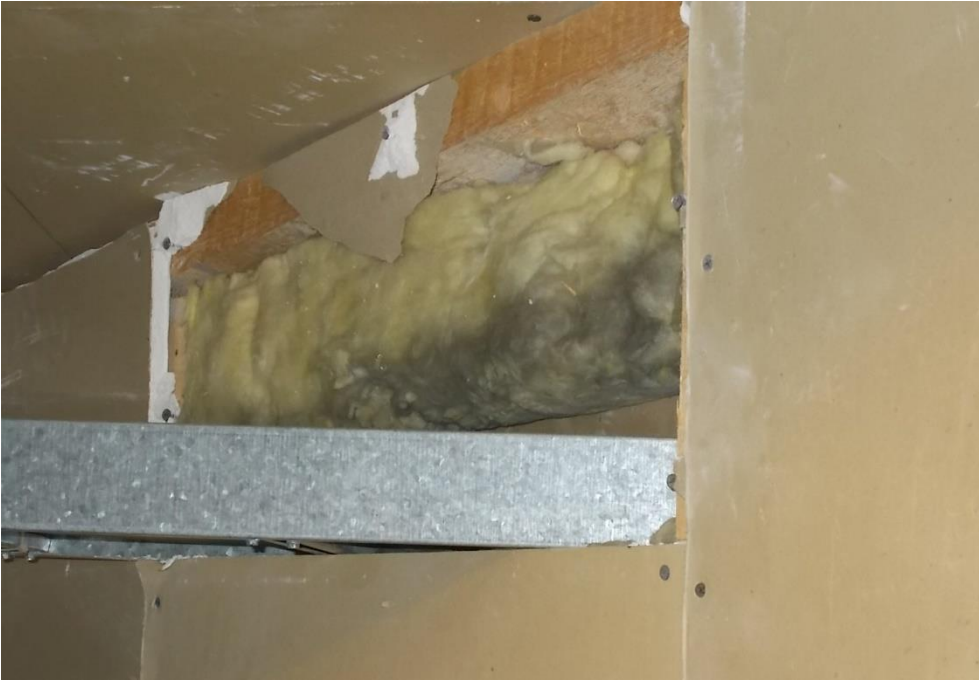
Kuva 4.14. Lämpivienti IV-konehuoneessa.
