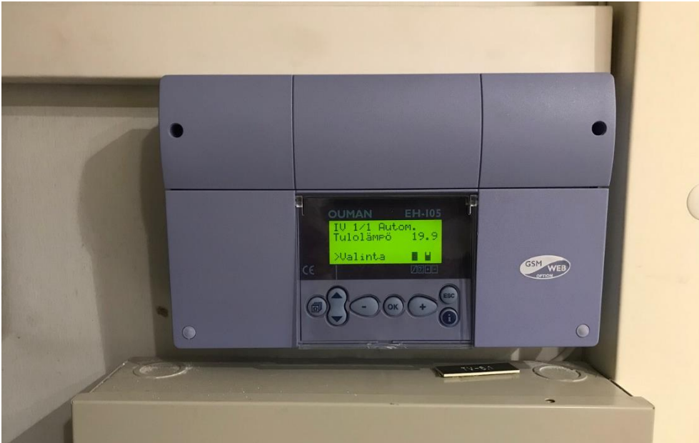
Kuva 6.1. Ilmanvaihtokoneen säädin.
