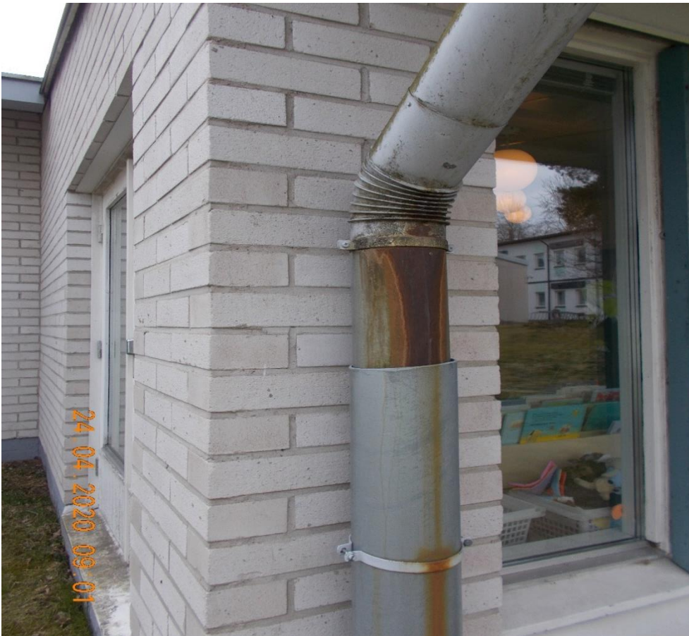
Kuva 4.5. Ruostunut syöksytorvi.
