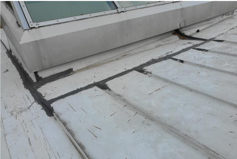
Kuva 4.3. Peltikatetta on korjattu.
