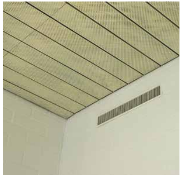
↑ Tilahahmoiltaan ja osin materiaaleiltaan, erityisesti alakattojen osalta, alkuperäisinä säilyneet liiketilat: Parturi-Kampaamo Punatukka (tila 7), Kampaamo Salon C (tila 12) ja Pukuvuokraamo Tapiolan Juhlapuku (tila 11). Tiloissa on säilynyt myös alkuperäisiä ilmanvaihtoventtiilejä (kuva tilasta 7).
