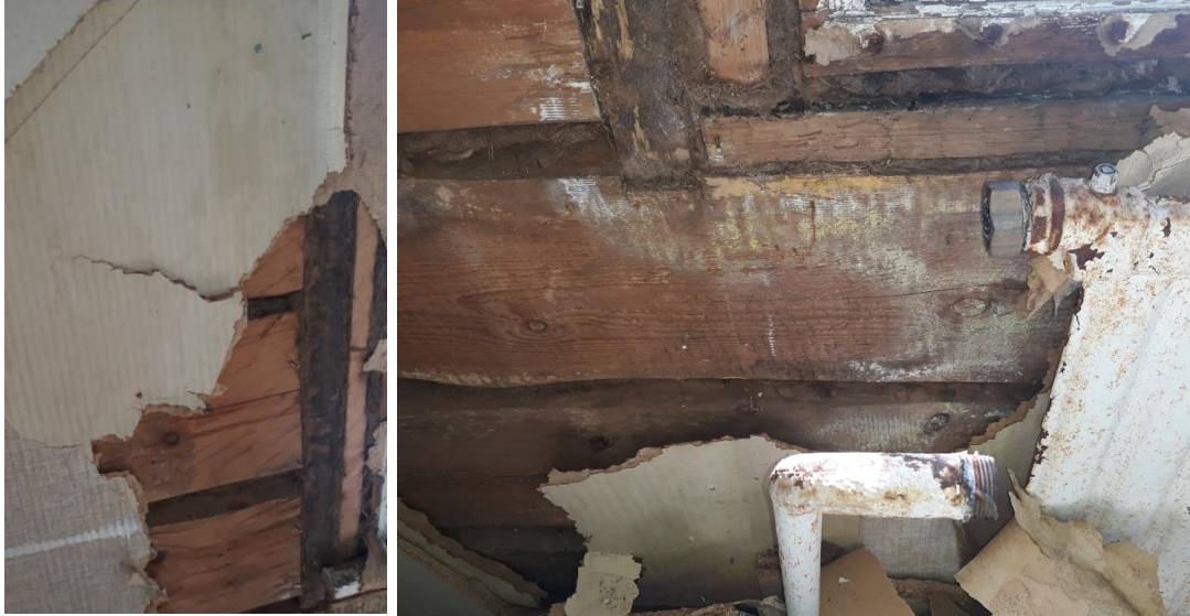
Kuvat 23 ja 24. Tapettikerrosten välissä oli vanhoja vesivalumajälkiä. Pinkopahvin ja hirren välissä oli hirsipinnoilla home- ja lahottajasieniin viittaavaa rihmastoa.
