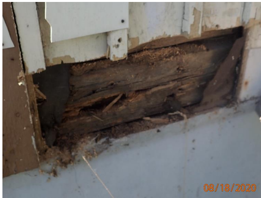
Kuvat 13 ja 14. Rakennuksen kaikilla sivustoilla on tupajumien vaurioittamia hirsii. Kuvassa 14 Tupajumien ulostuloaukkoja.
