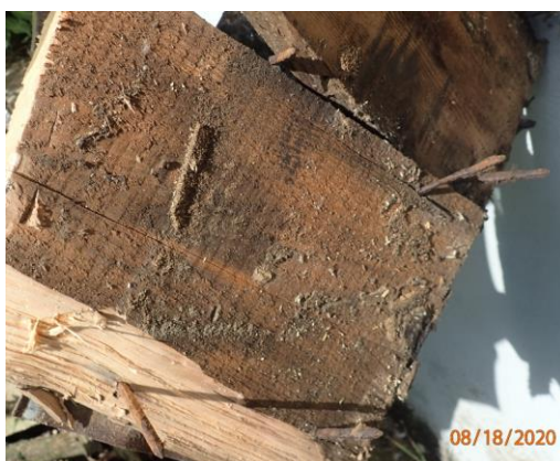
Kuvat 17 ja 18. Tupajumien tekemiä reikiä ja jätöksiä oli myös lautaverhouksen taustapinnoilla sekä tervaperissa.
