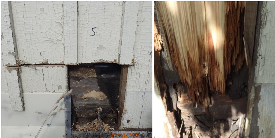
Kuvat 21 ja 22. Osassa avauskohtia alimmat hirret olivat koko hirren paksuudelta (200 mm) lahoja ja porauspuru tummaa. Myös osa puuverhouksen laudoista oli lahoja.
