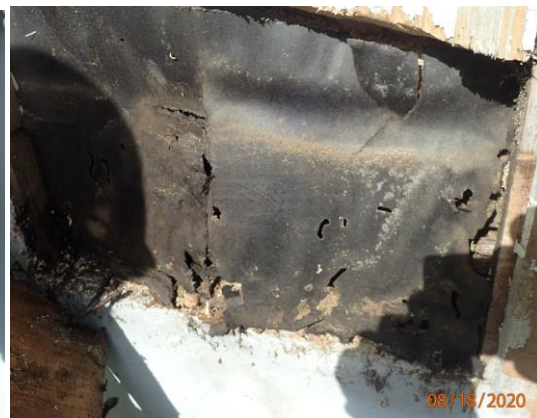
Kuvat 17 ja 18. Tupajumien tekemiä reikiä ja jätöksiä oli myös lautaverhouksen taustapinnoilla sekä tervaperissa.
