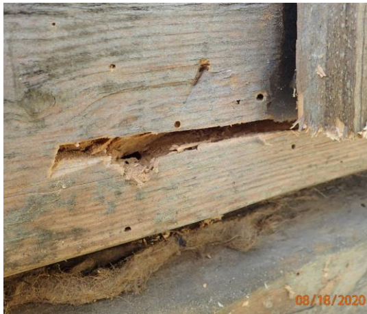
Kuvat 15 ja 16. Tupajumien lisäksi hirsissä oli katkolahoa ja pehmentynyttä hirttä 340 mm korkeuteen asti.
