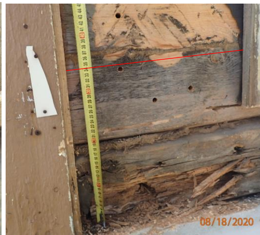
Kuvat 15 ja 16. Tupajumien lisäksi hirsissä oli katkolahoa ja pehmentynyttä hirttä 340 mm korkeuteen asti.
