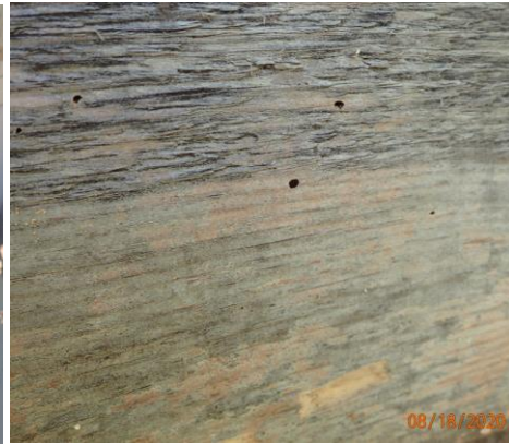
Kuvat 13 ja 14. Rakennuksen kaikilla sivustoilla on tupajumien vaurioittamia hirsii. Kuvassa 14 Tupajumien ulostuloaukkoja.
