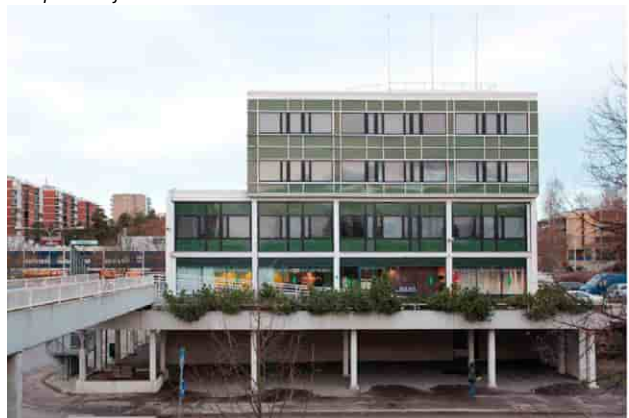
Purettu Esson pääkonttori, Kuunkehrä 6 (Oy Esso Ab, Kuitinmäen pääkonttorin rakennushistoriaselvitys, Livady Oy, 2013)
