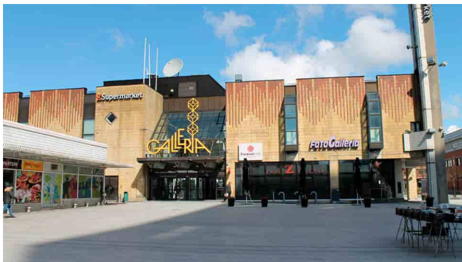
Leppävaaran Galleria valmistui 1985 ja sen on suunnitellut Arkkitehtitoimisto Kalevi Ruokosuo Ky. Julkisivuissa on aikakaudelle tyypillistä moni-ilmeisyyttä; koristeellista tiiliverhoilua, lyhtymäisiä lasierkereitä ja näyttävä pääsisäänkäynti.
