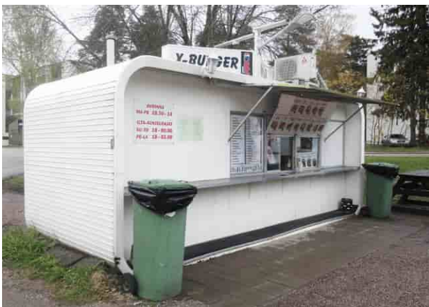
Rakennuskokonaisuuteen liittyy vuonna 1973 valmistunut kioski.
