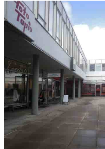
Tapiontori on myös yksi arkkitehti Aarne Ervin suunnittelukohteista Espoon Tapiolassa. Tapiontori valmistui vuonna 1961.
