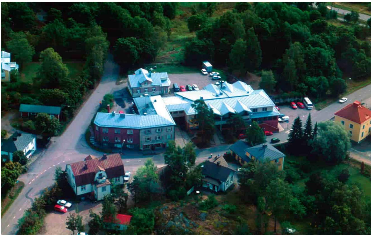
Ilmavalokuvassa vuodelta 1999 näkyvät rakennuskompleksin useina vuosikymmeninä toteutetut osat. Punatiilinen rakennus vuodelta 1928, harmaa rapattu laajennus vuodelta 1952 ja oikealla oleva liikerakennus vuosilta 1969 ja 1986. (lähde: Emil Halme, valokuvaaja Tage Strandström)
