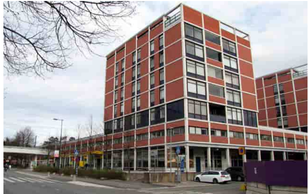
Ostoskeskus asuntoruneen ja Kuunkadun ylittävä kävely- ja pyöräily silta, Maapallonkuja 2
