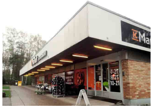
Katoksen alapinta on valaistu.
