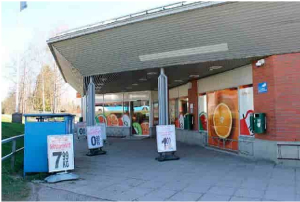
Liikerakennuksessa on runsaasti viistettyjä kulmia.
