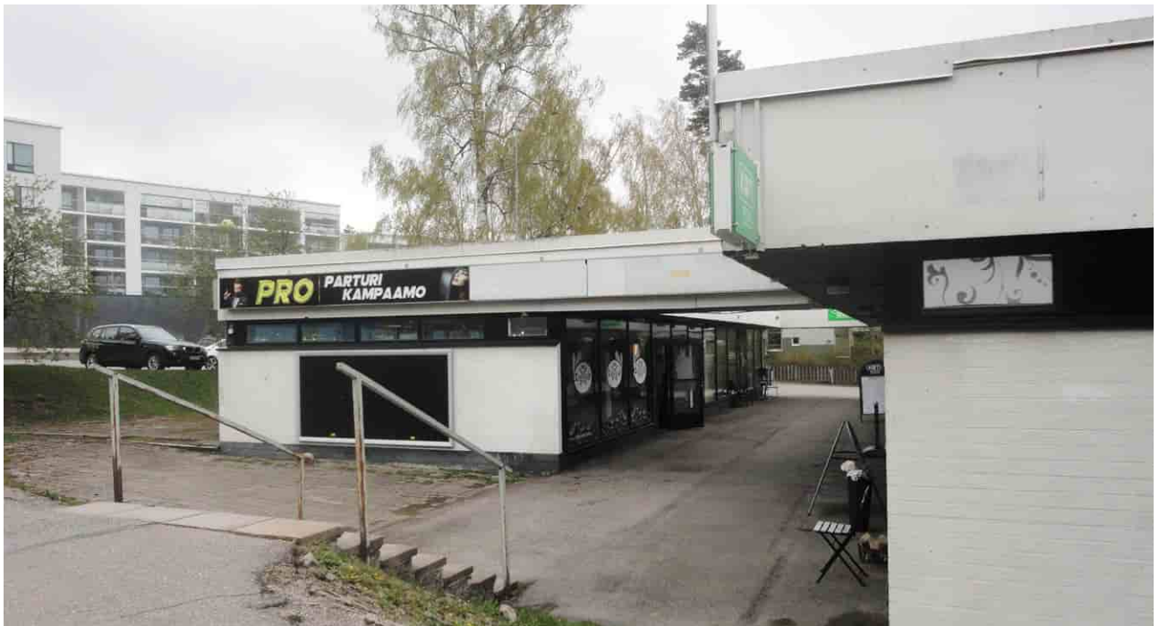
Ostoskeskuksen läpi kulkee katettu ulkokäytävä.
