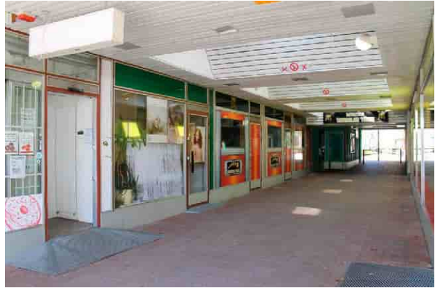
Katetulle käytävälle valoa antavat kattoikkunat.
