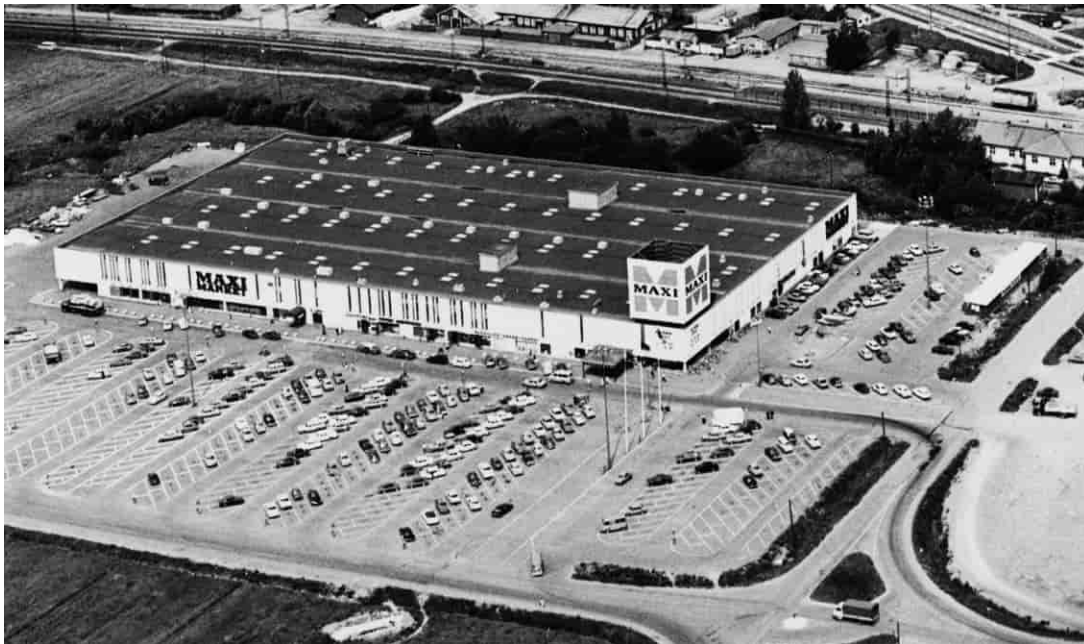
Suurikokoista, tasakattoista ja matalaa liikerakennusta reunustivat laajat pysäköintikentät. (Espoon kaupungin museo, kuvaaja Atte Matilainen)
