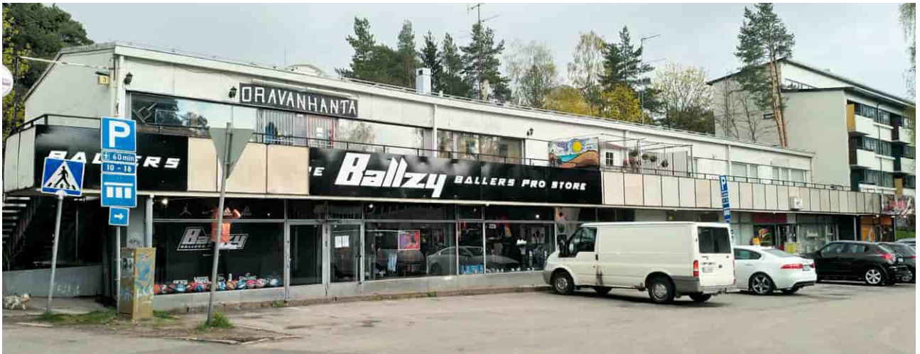
Oravanhattorin liikerakennuksien tunnuspiirteinä on koko pitkän julkisivun mitalle sommitellut ikkunat.
