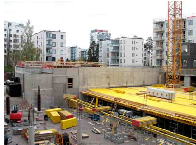
Ostoskeskuksen paikalle on rakenteilla kerrostaloja.
