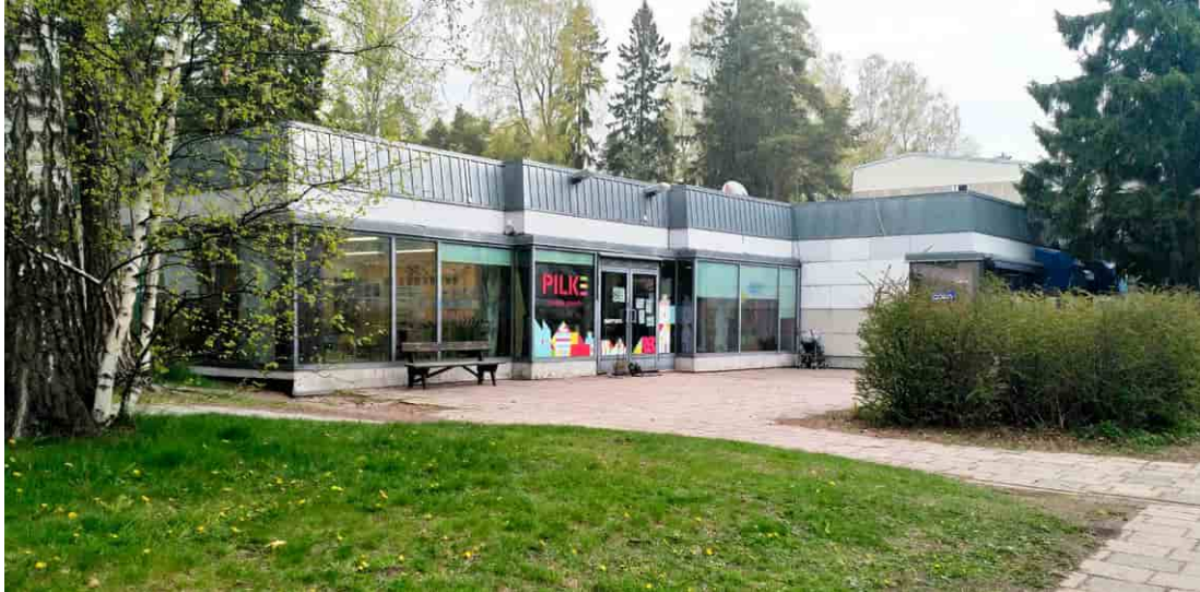
Mäntyviita 6:n liikerakennus.
