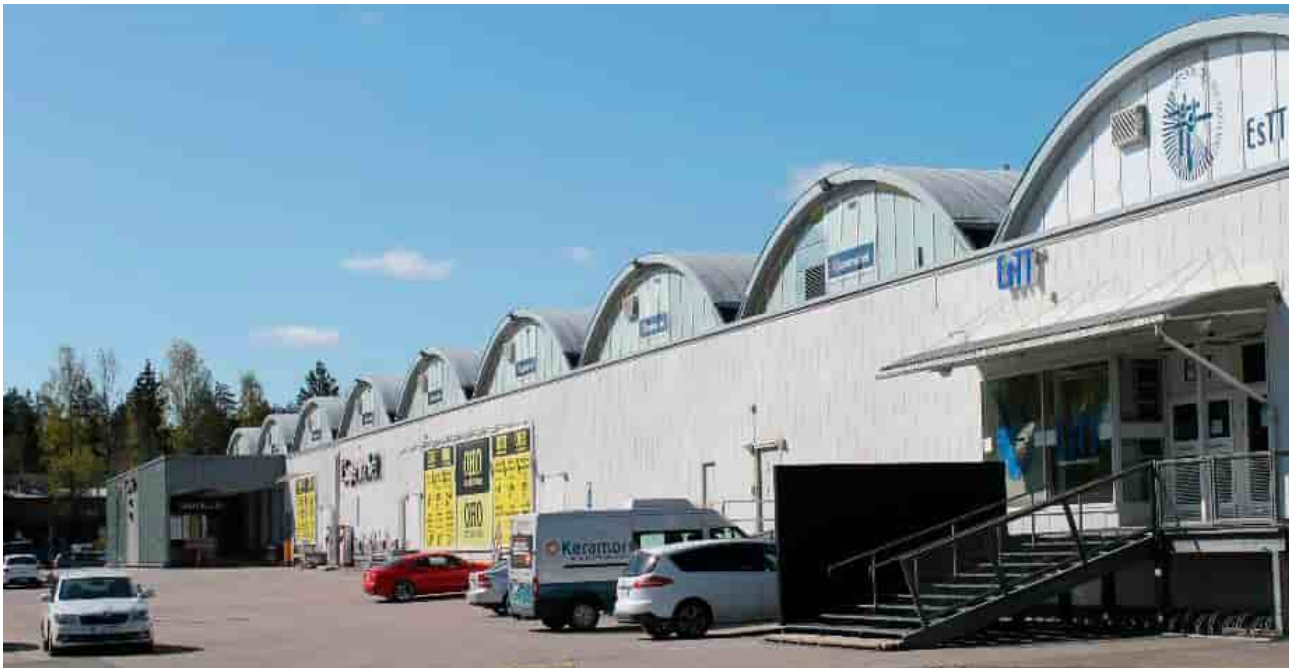
Rakennuksen tunnuspiirteenä on sen komea kaarikatto, joka näkyy erityisen hyvin itäjulkisivulla.
