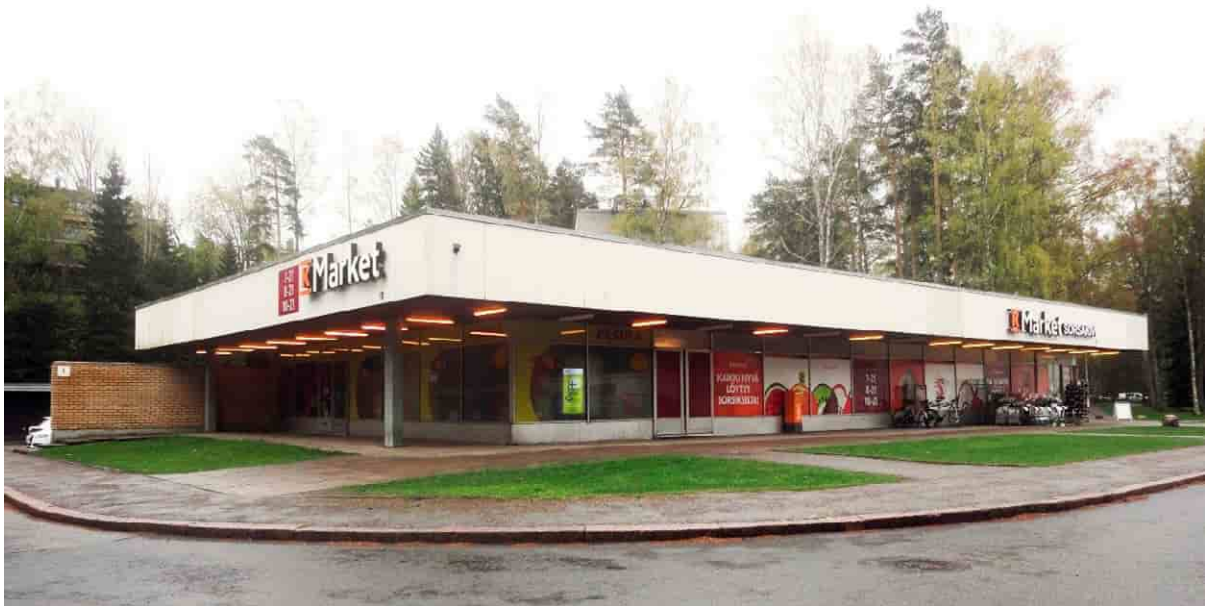
Liikerakennuksen matalaa ulkohahmoa korostaa paksu tasakatto.
