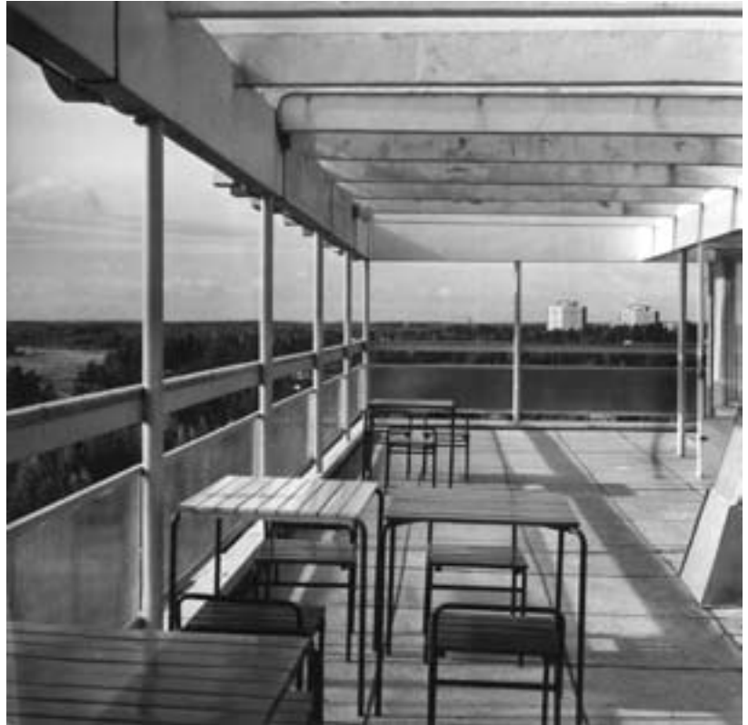
As Oy Mäntytorni, kattoterassi. Arkkitehti Aarne Ervi
