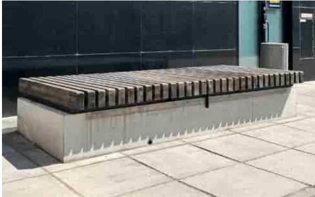
Jakotukkipenkki, koko vaihtelee istuintason alle jäävän jakotukkitilan mukaan, toteutetaan Kulttuuriraitin jakotukkipenkki suunnitelmien mukaisesti, istuintason materiaalina käsittelemätön lehtikuusi. (Sitowise)
