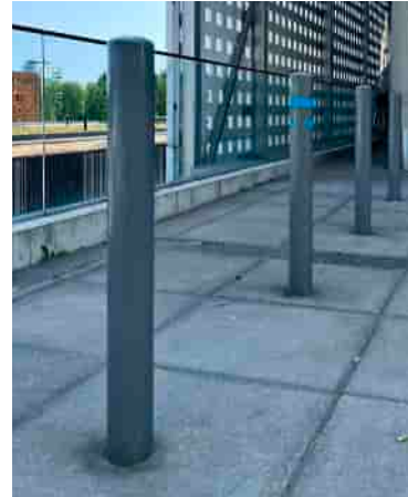
Teräspollareita sijoitettuna Länsituulen itäpäähän. Korkeus 750mm, läpimitta 160mm, RAL 9007.
