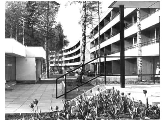
Itärannan ostokeskuksen laatoitusta ja metallikaide. (Asuntosäätiön arkisto)
