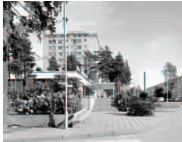
Mäntyviita on Tapiolan vanhinta aluetta. Siellä käytetty laattakoko on 350x350 mm. Paikalla valetuissa betonimuureissa on sahalautamuotti, joka näkyy valmiissa pinnassa. Katuvalaisimena on käytetty Tapiola-valaisinta kaksivartisena versiona. Kuvassa myös kaksi penkkiä harmaaksi peittomaalattuina. (Asuntosäätiön arkisto)
