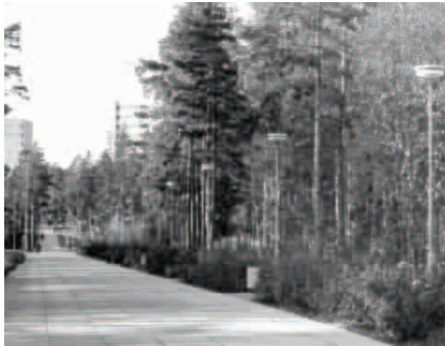
Tapionraitin isoa betonilaatitusta nykyisen Heikintorin kohdalla. Laattasaumat jatkuvat yhtenäisinä Heikintorin lattiassa, jossa pinnoite on samalla moduulilla tehty. Kuvassa myös Ervin suunnittelema Tapiola-valaisin ja Asuntosäätiön oma roska-astiamalli. (Asuntosäätiön arkisto)
