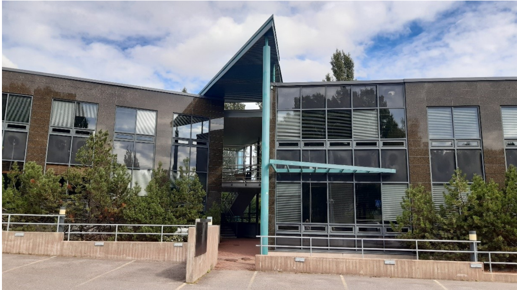
Kuva 4 Toimistorakennusta rytmittävät sinivihreät katosrakenteet, joilla on kolmionmuotoiset lipat. Katokset liittyvät rakennuksen osia yhdistäviin rappuihin, joiden ali näkyy tontin takaosa sekä pohjoisenpuoleinen pientaloasutus.
