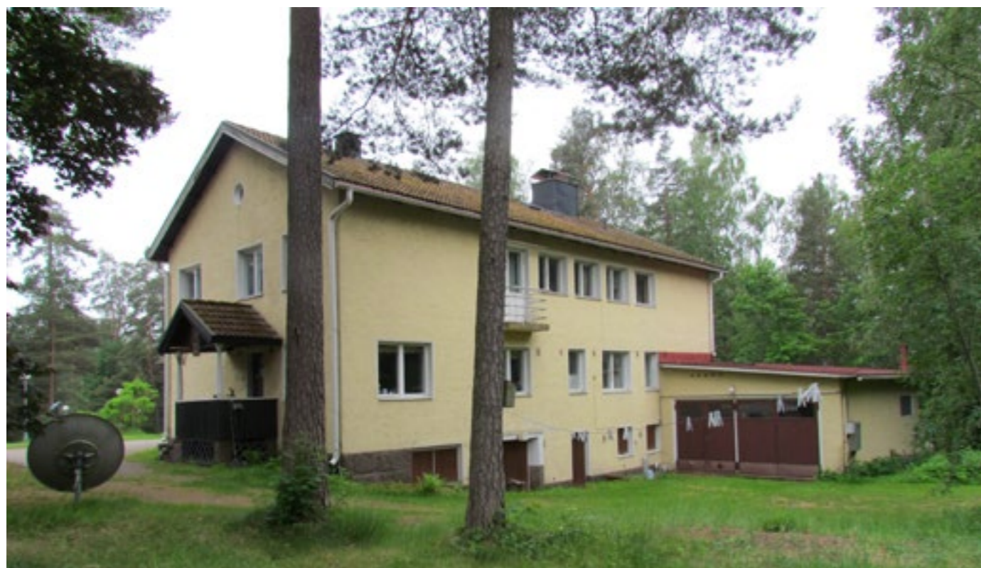
Kuva. Rakennusta on laajennettu autotallilla päärakennuksen pohjoispuolella vuonna 1956.
