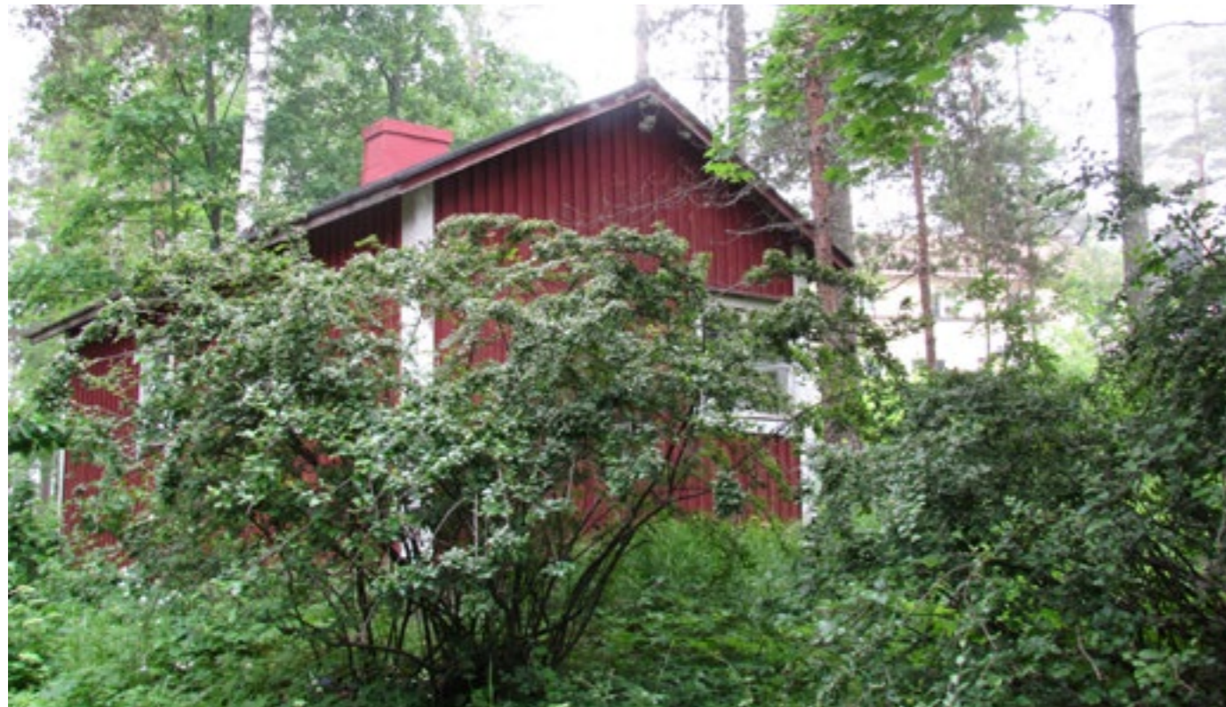
Kuva. Saunan eteläinen julkisivu. Rakennus on käytöstä poistamisen jäljiltä luonnon ympäröimänä.
