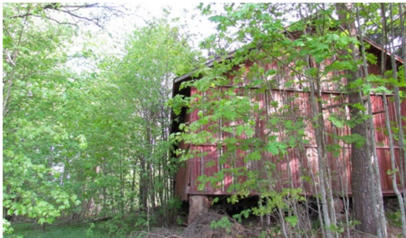
Kuva. Eteläinen julkisivu on kohti Heurlinintietä.
