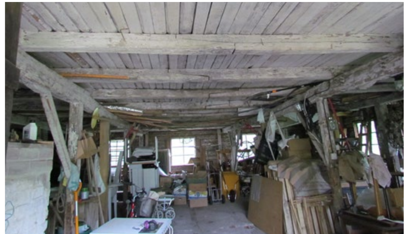
Kuva. Perunakellarin keskiosa on valoisa. Rakenteita on jouduttu tukemaan uusilla pilareilla.
