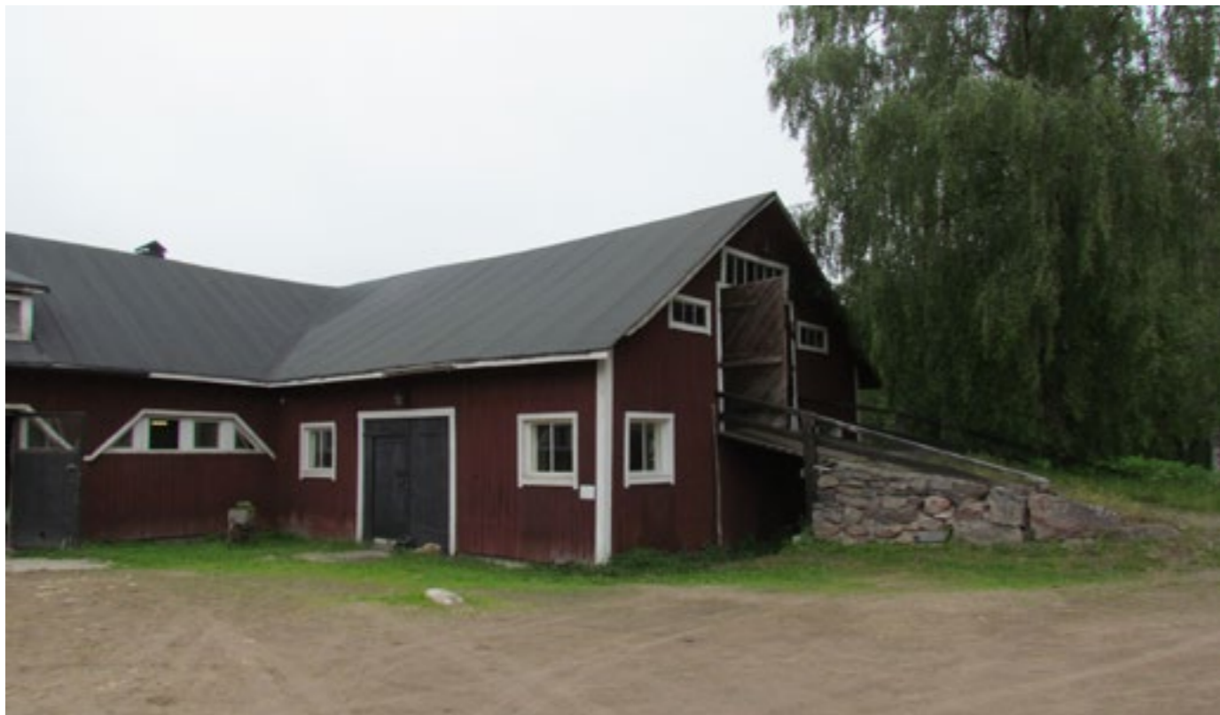
Kuva. Kivinen ajosilta toiseen kerrokseen.
