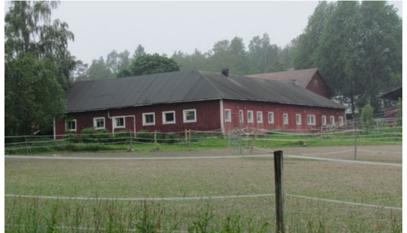
Kuva. Tallin julkisivut avointa maisematilaa kohden.
