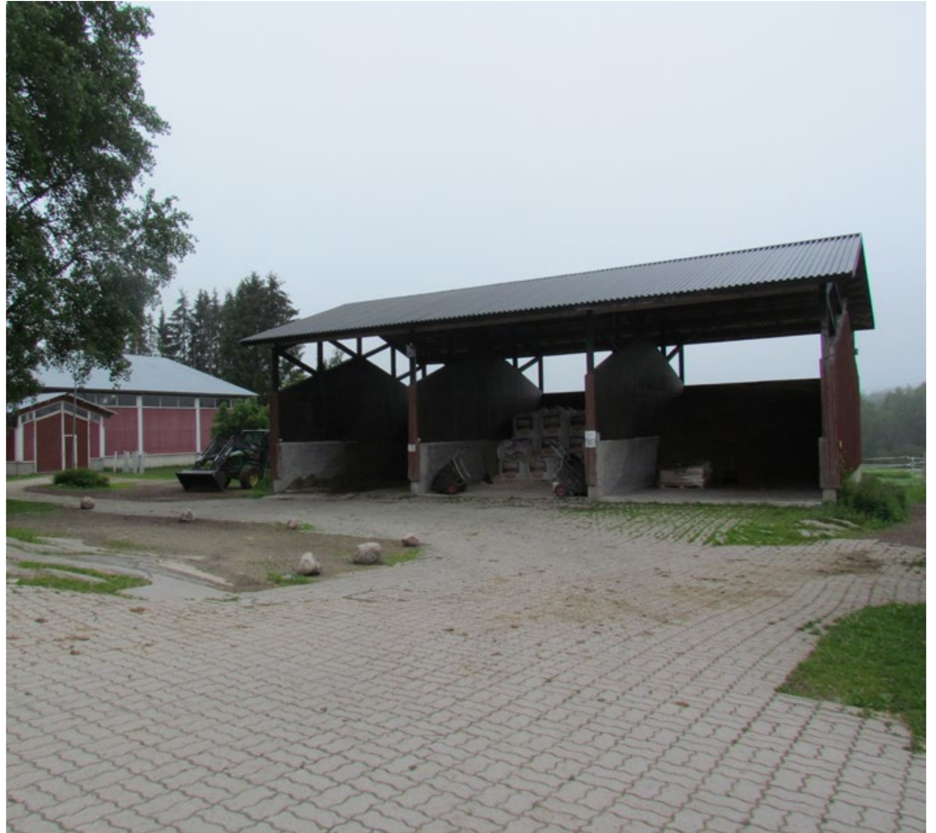
Kuva. Rakennuksen pihanpuoleinen julkisivu on avoin.
