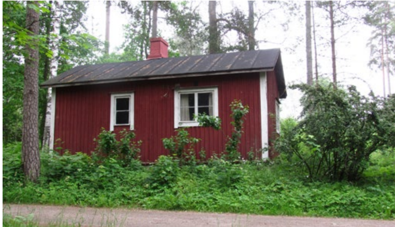
Kuva. Saunan julkisivu Jääskelänpolulle.
