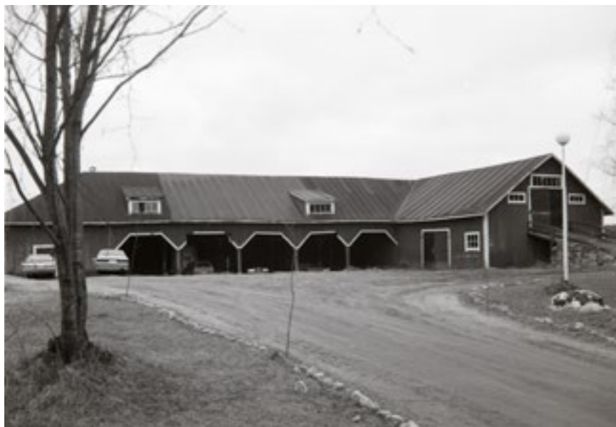
Kuva Espoon kaupungin museo, kuvaaja Jorma Tulkki 1991. Rakennus ennen 2000-luvun muutoksia, jolloin etuosan avonaiset vaunuvajan portit rakennettiin umpeen.
