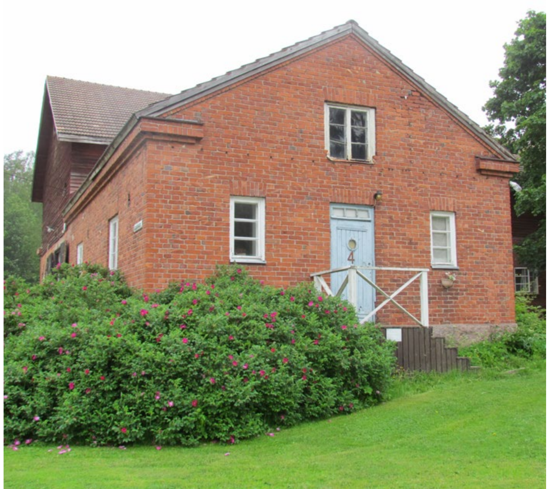
Kuva. Navetan itäjulkisivu on asemoitu vastakkain jo puretun päärakennuksen julkisivua kohden.
