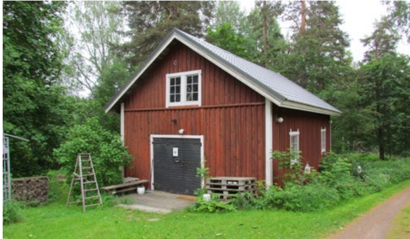
Kuva. Pohjoisjulkisivulla on pariövet.
