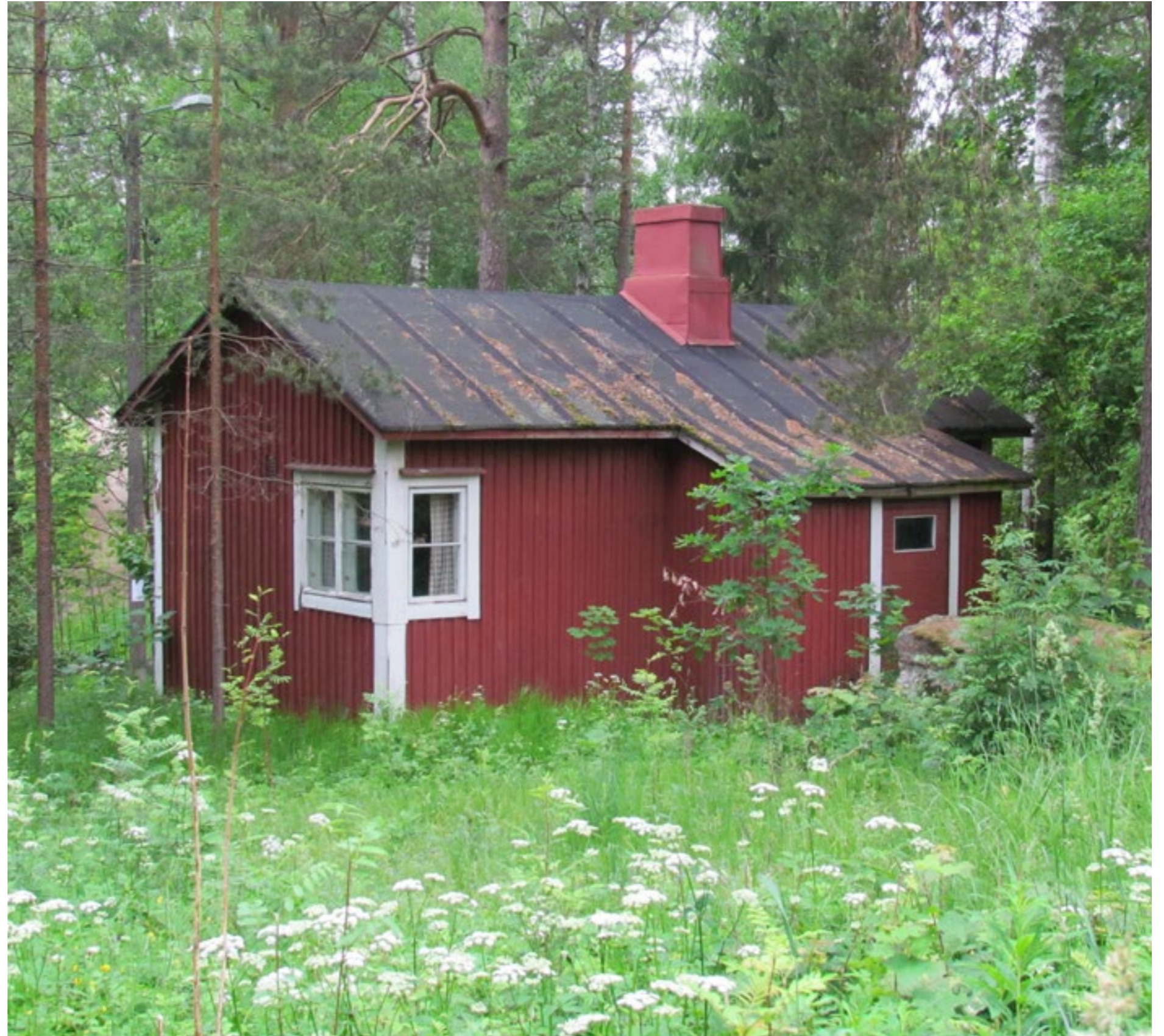
Kuva. Saunarakennus kuvattuna kartanon päärakennukselle johtavalta pihatieltä.
