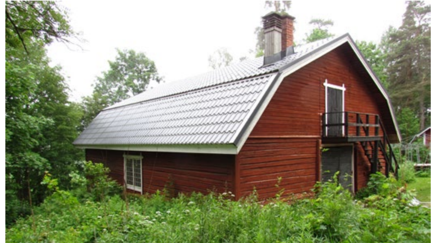
Kuva. Perunakellarin pohjoisjulkisivulla on yksi moniruutuinen ikkuna.
