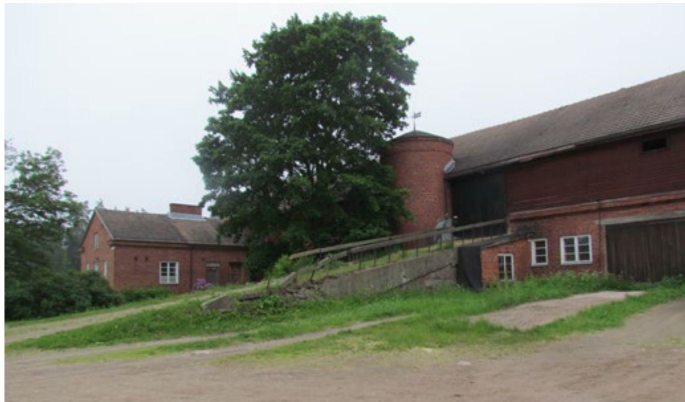
Kuva. Navetan pyöreässä rehutornissa on katolla tuuliviiri, jossa on vuosiluku 1926. Kuvassa oikealla näkyvä pariovi on vuonna 1967 lisätty kahden ikkunan paikalle.
