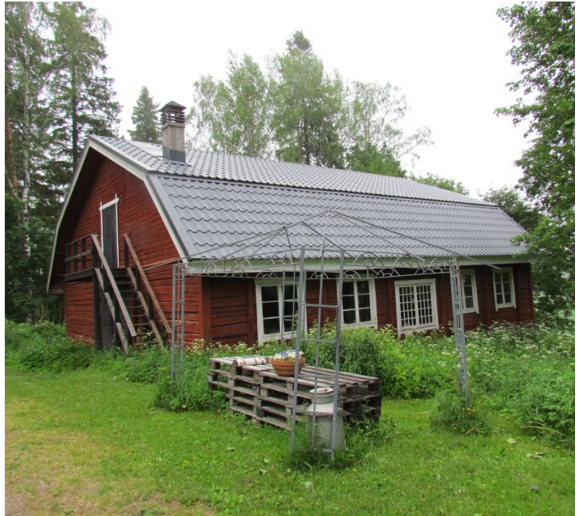
Kuva. Perunakellarin eteläinen julkisivu. Varsinainen perunakellari sijaitsee rakennuksen kivijalassa ja keskikerros on valoisa tila. Ylimpään kerrokseen johtaa ulkoa portaikko.
