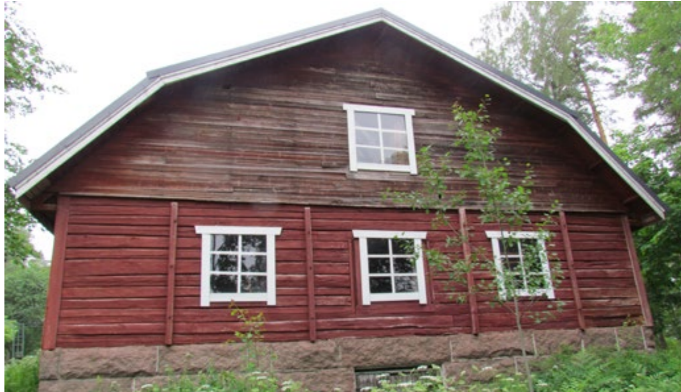
Kuva. Ikkunoiden ruutujaot ovat tehty rimoilla.
