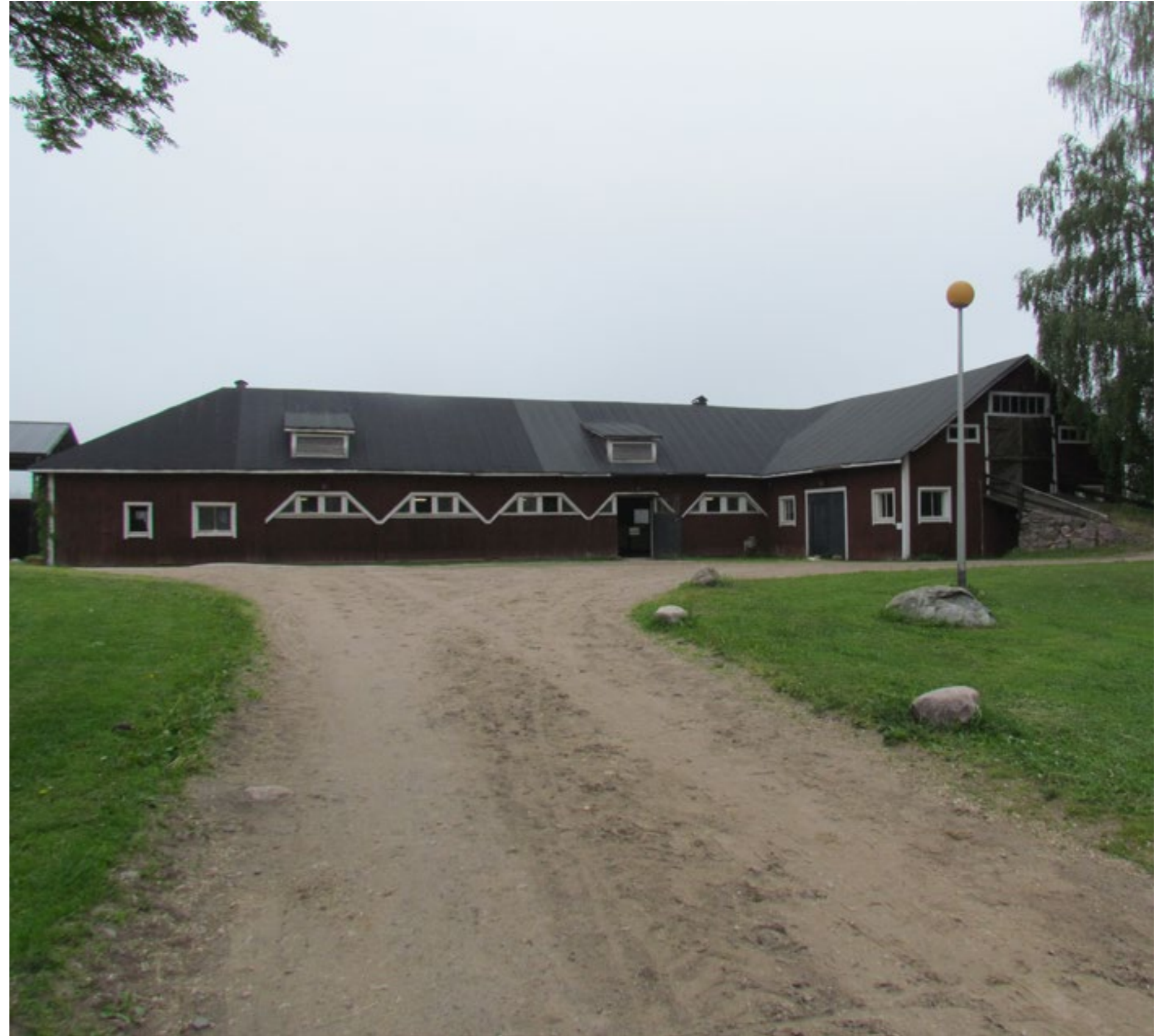
Kuva. Vanha vaunuvaja on muutettu talliksi. Julkisivussa näkyvä ikkunarytmi kertoo alkuperäisen käyttötarkoituksen. Ikkunoita on lisätty sivusiipeen.
