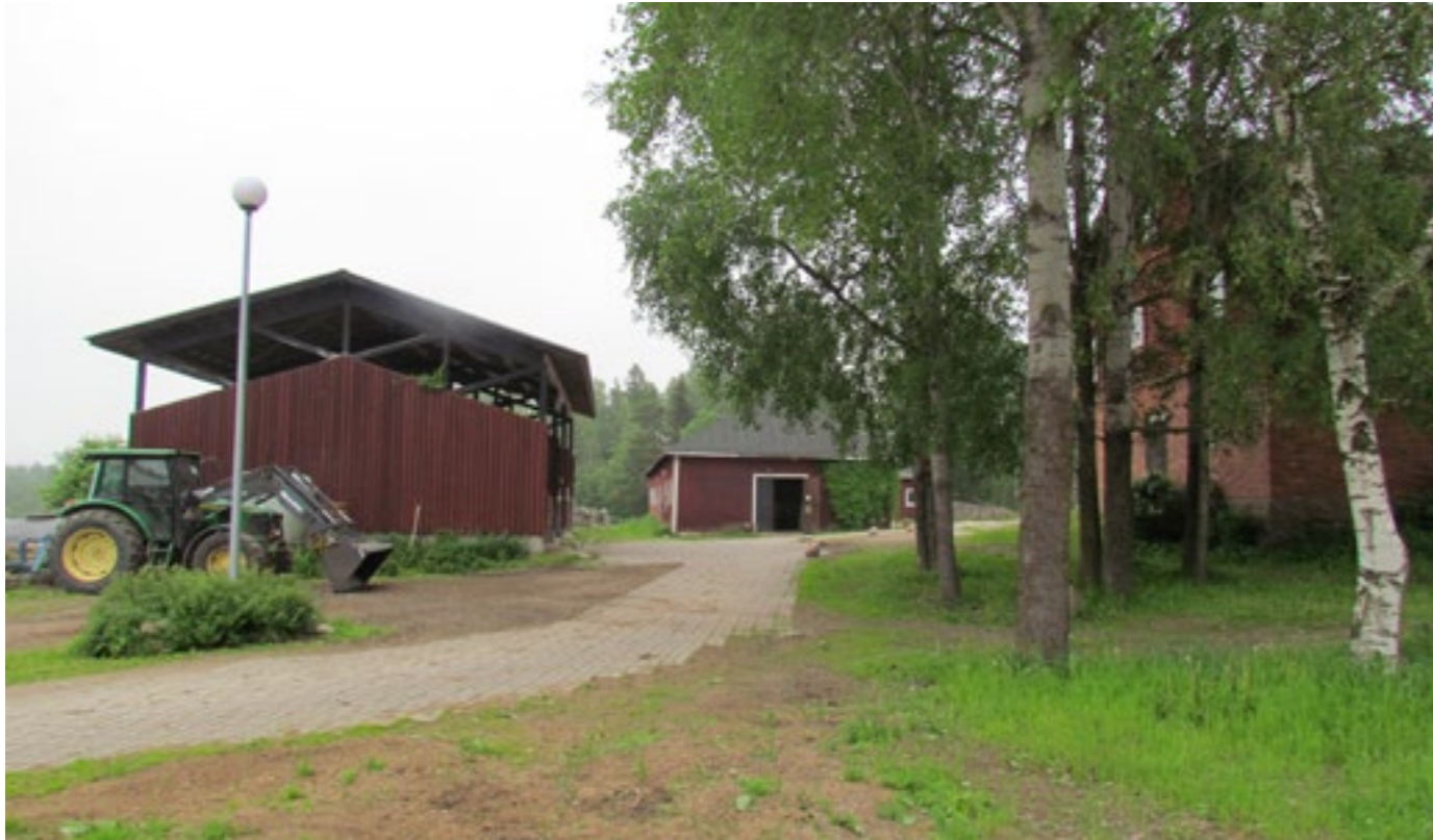
Kuva. Länsijulkisivu. Rakennuksen materiaalit ja sävyt istuvat hyvin ratsastuskeskuksen kokonaisuuteen.
