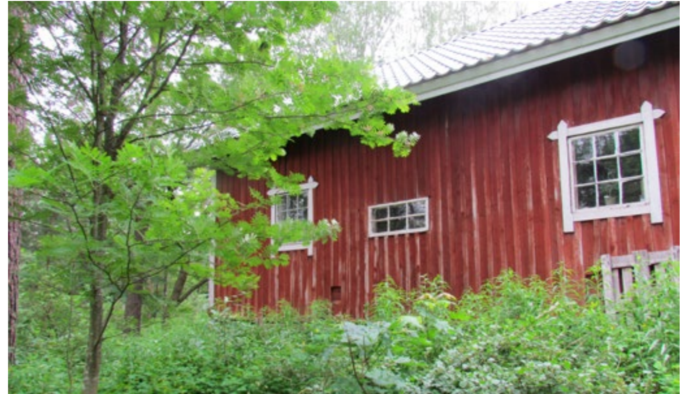
Kuva. Itäjulkisivulla on erikokoisia ikkunaruujuja.
