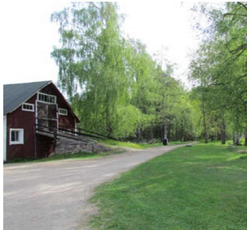
Kuva. Tallirakennuksen kivinen ajosilta.
